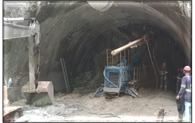
Escavação do túnel de ligação.
