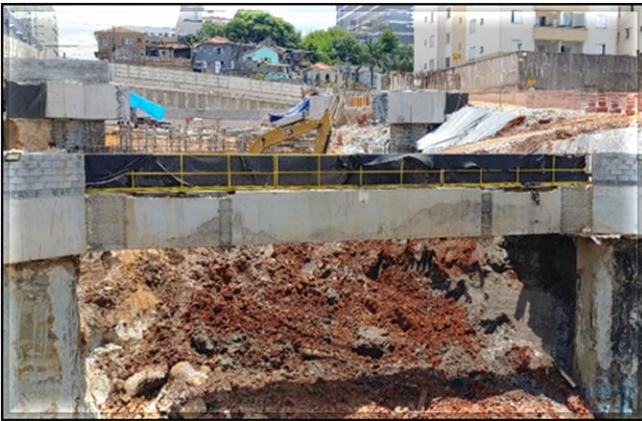
Escavação dos poços do corpo da estação.
