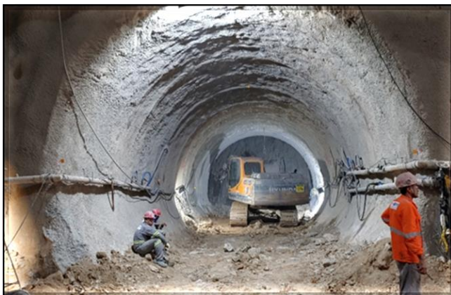
Escavação dos túneis do corpo da estação.
