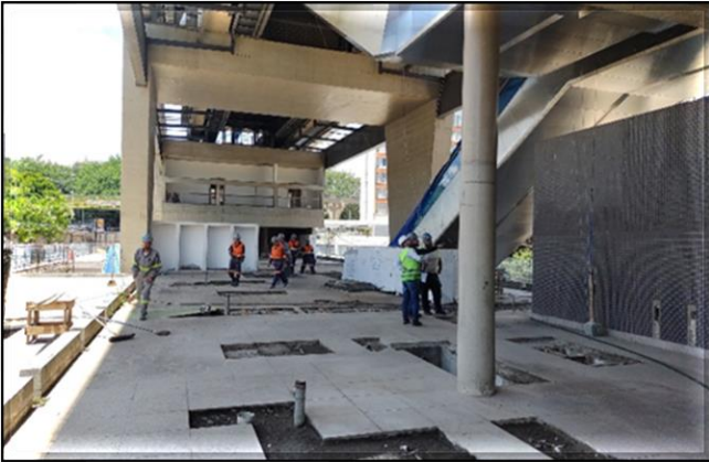
Obra Civil – Em andamento limpeza fina e mobilização das equipes.
