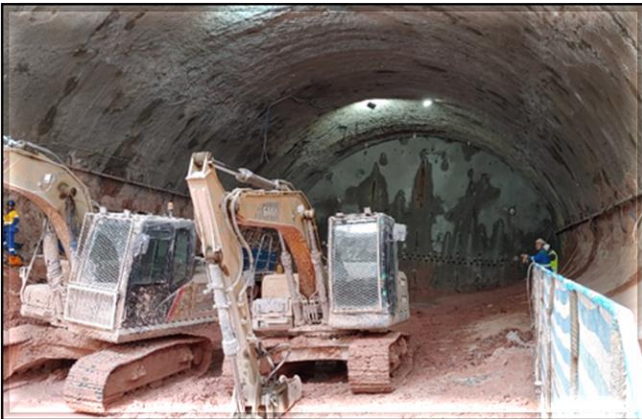
Tratamento dos túneis de via do corpo da estação.
