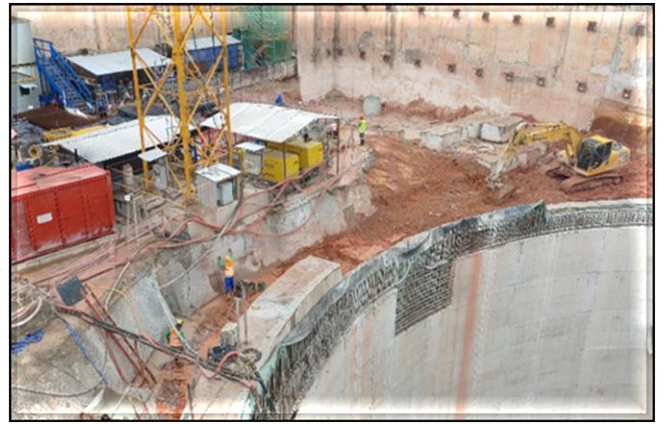
Escavação da ventilação principal do corpo da estação.
