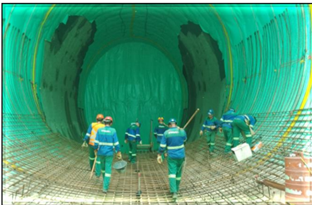
Laje de fundo e revestimento secundário do túnel de ligação.
