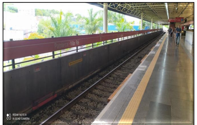
Reforço da borda da plataforma
