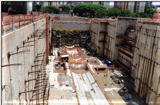
Revestimento secundário do corpo da estação.
