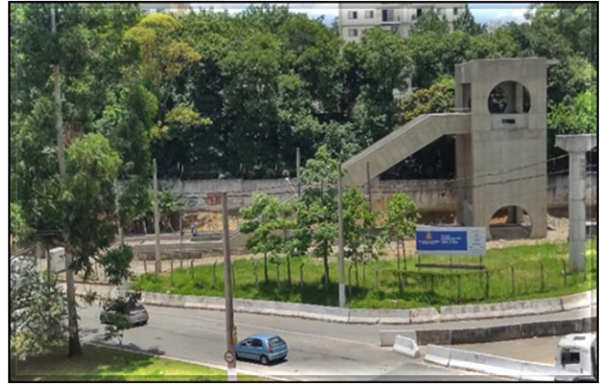
Obra Civil – Em andamento a manutenção do canteiro e mobilização das equipes.
