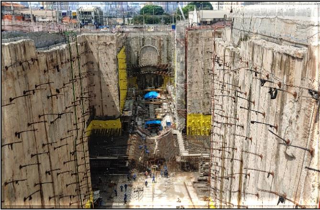
Impermeabilização e laje de fundo do corpo da estação.
