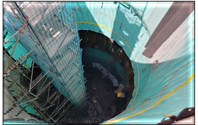
Impermeabilização da parede do poço.
