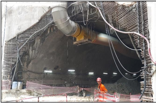
Escavação do túnel de via
