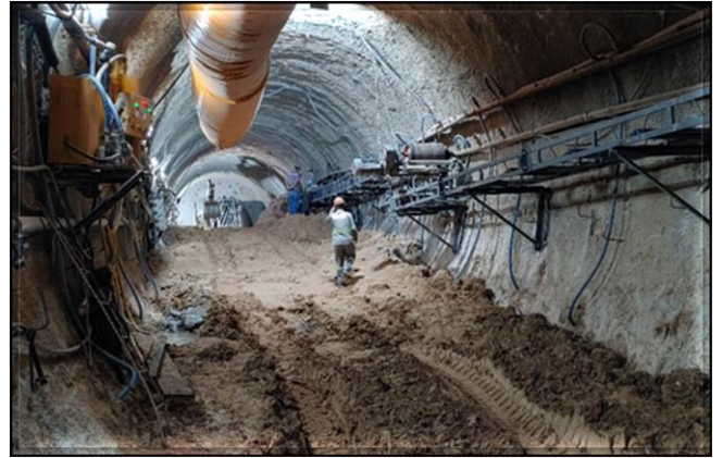
Escavação do túnel singelo.
