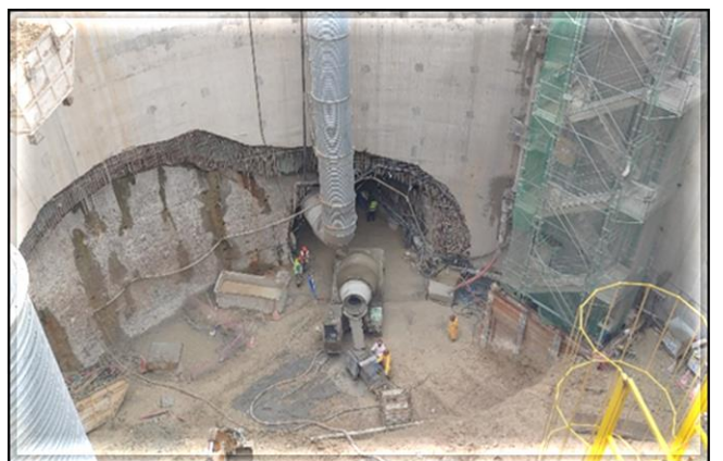
Escavação do túnel singelo.
