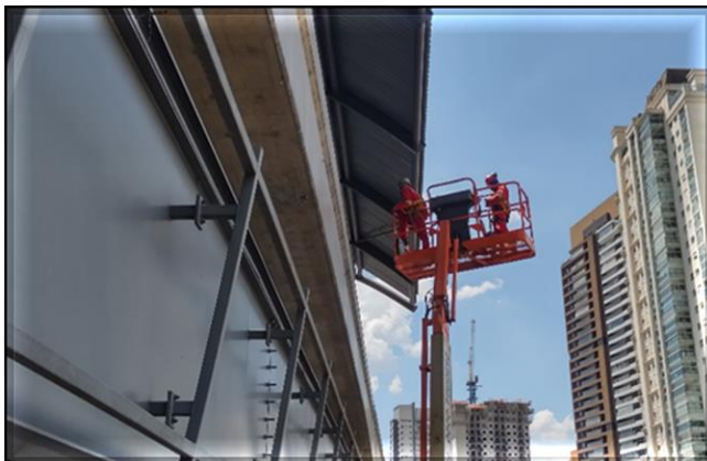
Obra Civil – Em andamento a instalação de acabamento da cobertura da plataforma.
