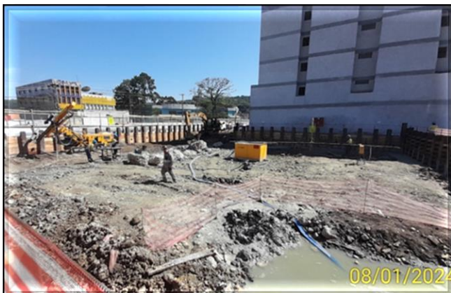
Em execução os tirantes da contenção e escavação do Edifício Técnico.
