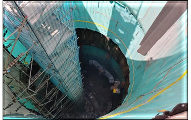
Impermeabilização da parede do poço.
