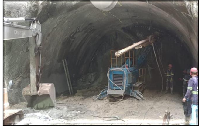
Escavação do túnel de ligação.
