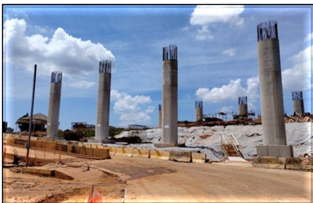
Em andamento a execução das estações, blocos e pilares da via de estacionamento.
