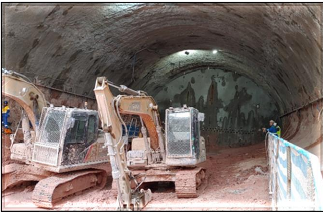
Tratamento dos túneis de via do corpo da estação.
