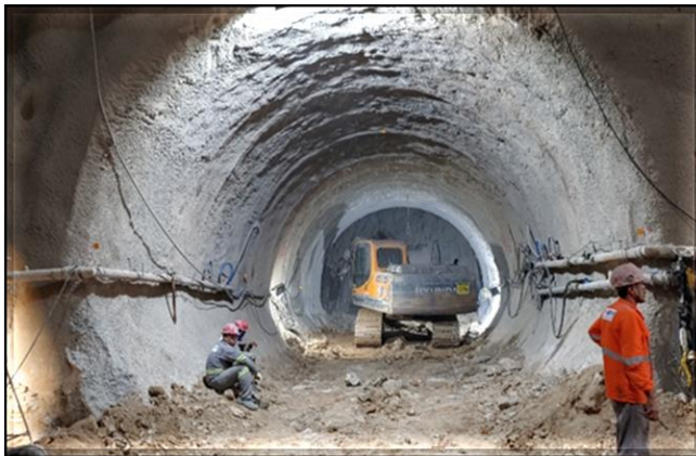
Escavação dos túneis do corpo da estação.
