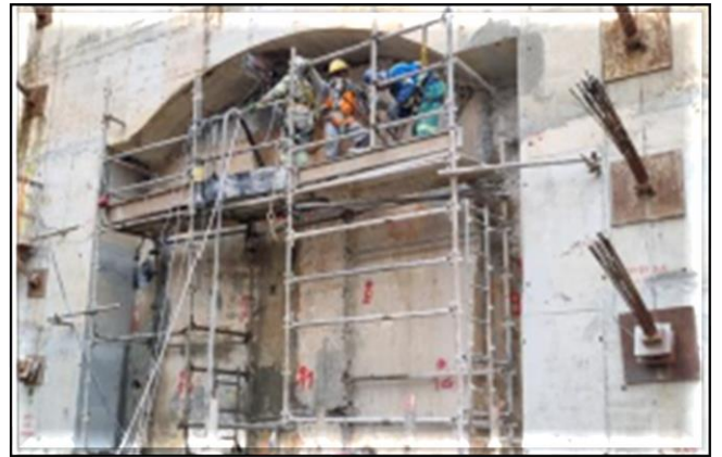
Corte da parede para emboque do túnel singelo.
