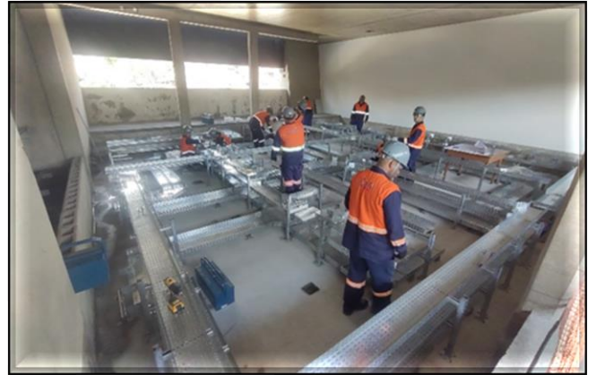
Obra Civil – Em andamento a manutenção do canteiro, limpeza e mobilização das equipes. | Sistemas – Instalação do bandeamento na Sala de Equipamentos Eletrônicos (SEE).
