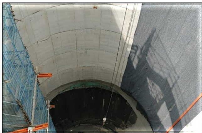
Revestimento secundário do Poço finalizado.
