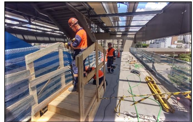
Obra Civil – Em andamento instalação de proteção. | Sistemas – Em execução a instalação do bandeamento na Sala de Equipamentos Eletrônicos (SEE).
