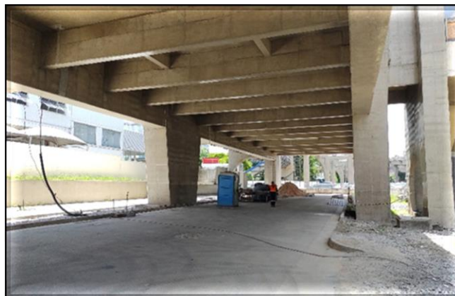
Obra Civil – Em andamento a manutenção do canteiro, limpeza e mobilização das equipes.
