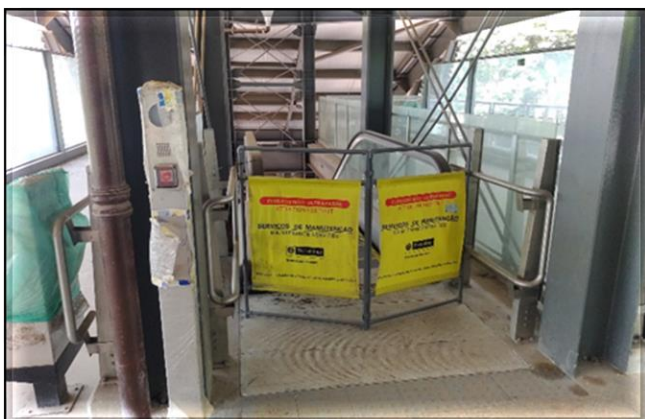
Obra Civil – Em execução o escopo remanescente. | Sistemas – Montagem dos elevadores e escadas rolantes.
