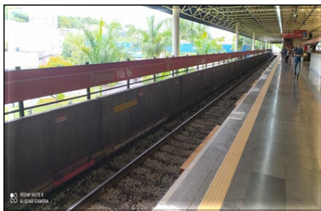
Reforço da borda da plataforma
