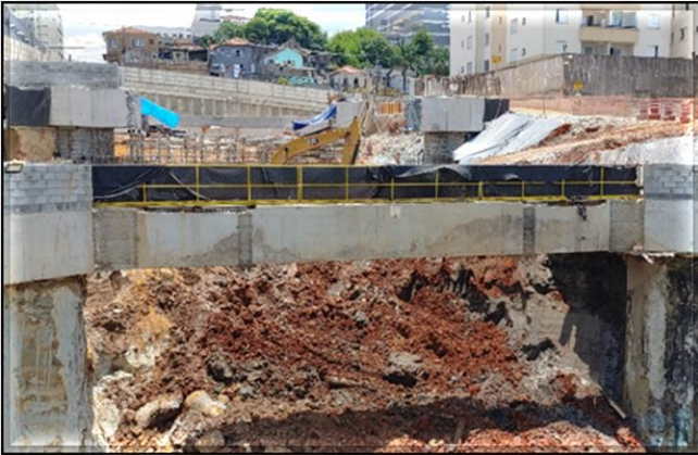
Escavação dos poços do corpo da estação.
