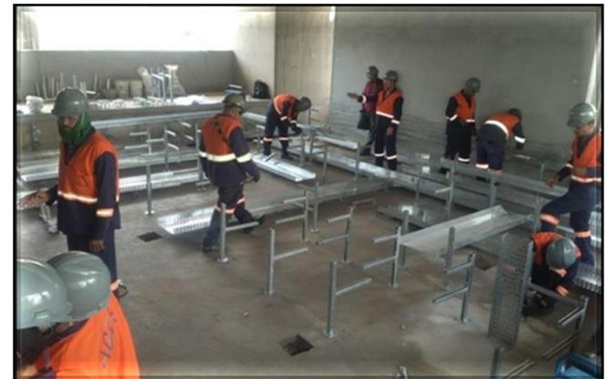
Obra Civil – Em execução o piso da plataforma e a manutenção do canteiro. Sistemas – Instalação do bandejamento na Sala de Equipamentos Eletrônicos (SEE).
