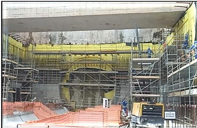
Impermeabilização das paredes e revestimento secundário do corpo da estação.
