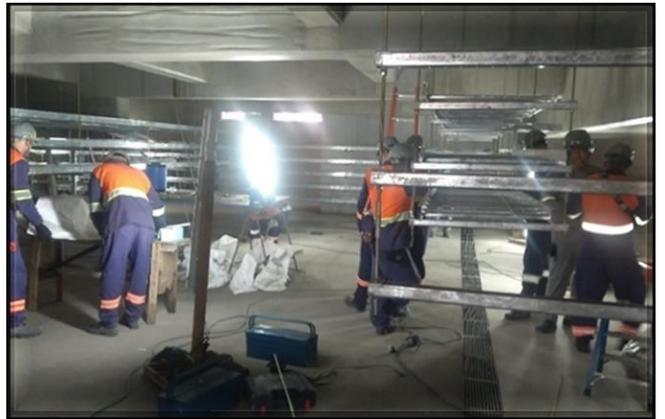
Obra Civil – Em andamento a inspeção ambiental, limpeza e manutenção de canteiro. Sistemas – Instalação do bandejamento da galeria de cabos e execução das bases dos aparelhos de mudança de via..
