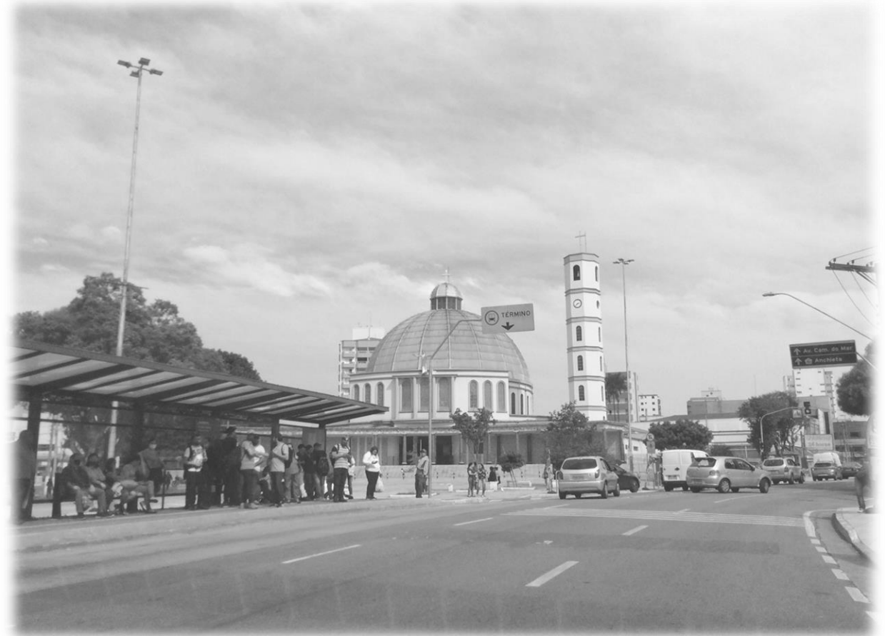
Localização da futura estação Rudge Ramos
