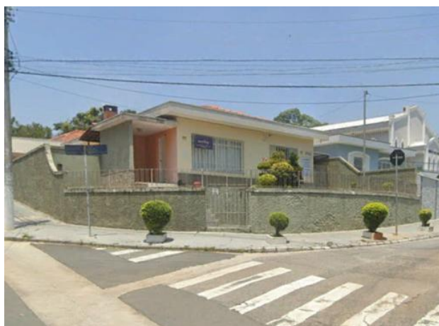
Foto 11.1-211: Vista do bloco passível de desapropriação na Rua Manoel Salgado.
