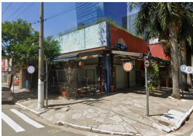
Foto 11.1-161: Vista do bloco 1 passível de desapropriação entre a Av. Brigadeiro Faria Lima e a Rua. Min. Jesuíno Cardoso.
