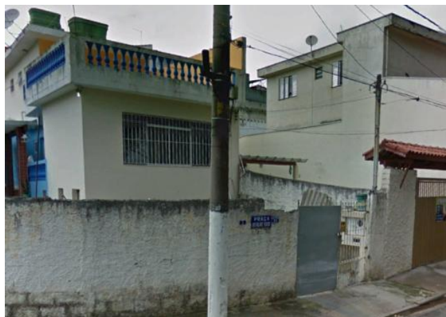
Foto 11.1-225: Vista do bloco passível de desapropriação na Praça Bartolomeu Ferrero.
