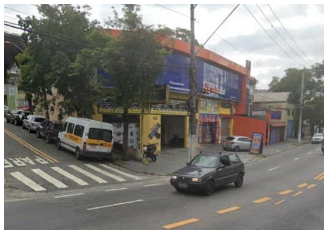
Foto 11.1-246: Vista do bloco 2 passível de desapropriação na Avenida Príncipe de Gales.
