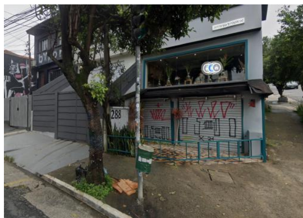
Foto 11.1-136: Vista do bloco passível de desapropriação na Rua Aspícula.
