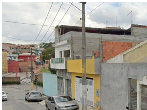
Foto 11.1-206: Vista do bloco passível de desapropriação na Rua Sebastião Mazzoni.
