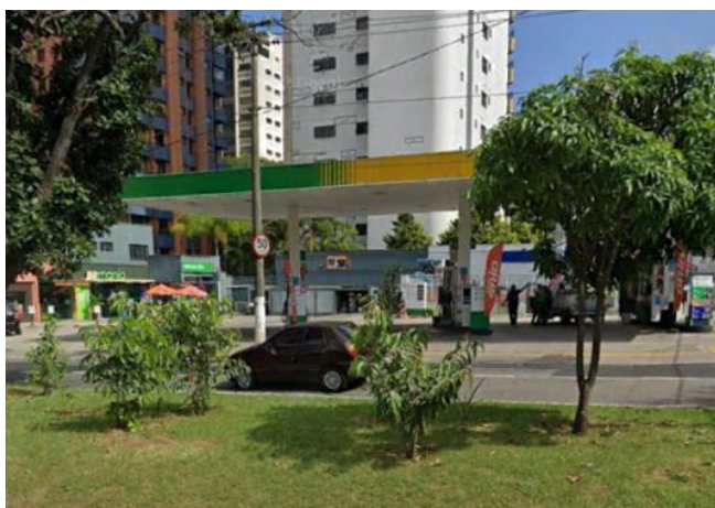
Foto 11.1-179: Vista do bloco 1 passível de desapropriação na Avenida Moreira Guimarães
