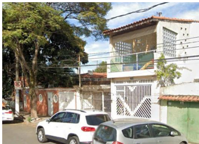
Foto 11.1-235: Vista do bloco passível de desapropriação na Rua Guilherme de Almeida.
