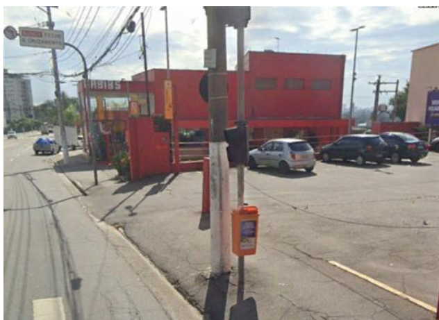
Foto 11.1-218: Vista do bloco 1 passível de desapropriação na Avenida do Taboão.
