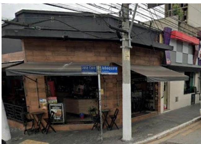
Foto 11.1-192: Vista do bloco passível de desapropriação entre a Av. Jabaquara.
