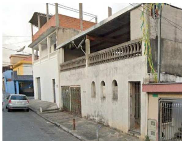
Foto 11.1-217: Vista do bloco passível de desapropriação na Rua José Antônio Valadares.
