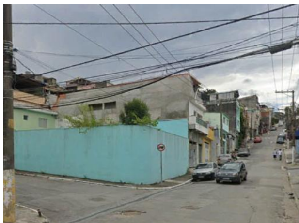
Foto 11.1-205: Vista do bloco passível de desapropriação na Rua Sebastião Mazzoni.
