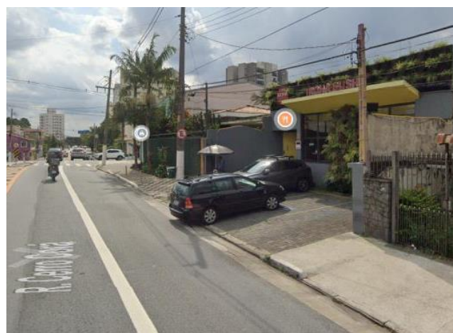
Foto 11.1-128: Vista do bloco 2 na Rua Cerro Corá.
