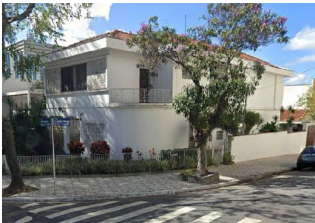
Foto 11.1-252: Vista do bloco 2 passível de desapropriação na Avenida Portugal.
