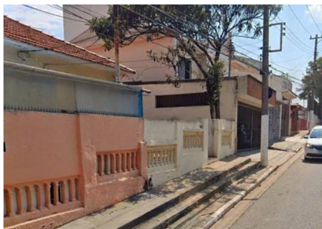
Foto 11.1-227: Vista do bloco passível de desapropriação na Rua Planalto.
