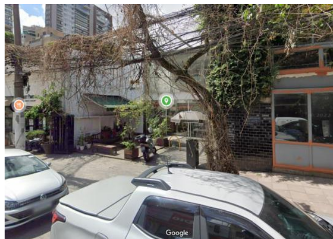
Foto 11.1-158: Vista do bloco 3 passível de desapropriação na Rua Dr. Mário Ferraz.
