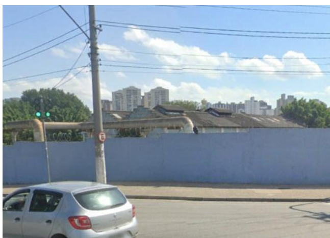
Foto 11.1-263: Vista do bloco passível de desapropriação na Avenida dos Estados.
