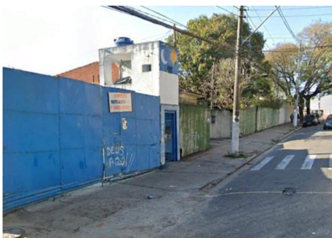
Foto 11.1-219: Vista do bloco 2 passível de desapropriação entre a Avenida Helvétia.
