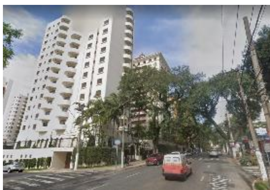
Foto 11.1-89. Área residencial verticalizada de alto padrão construtivo
