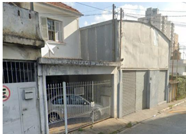
Foto 11.1-198: Vista do bloco passível de desapropriação na Rua Calógero Caia
