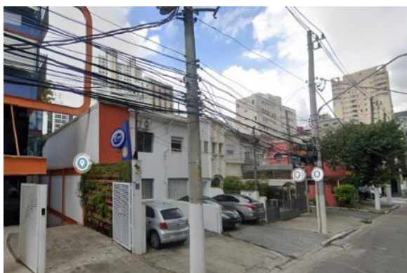
Foto 11.1-137: Vista do bloco 1 passível de desapropriação na Rua Girassol.
