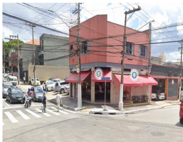
Foto 11.1-118: Vista do bloco 1 entre a Rua Francisco Alves e a Rua Tito.
