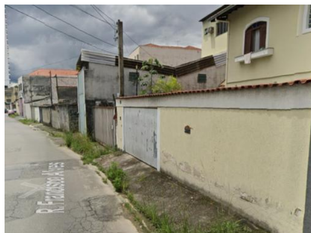
Foto 11.1-122: Vista do bloco passível de desapropriação na Rua Francisco Alves.
