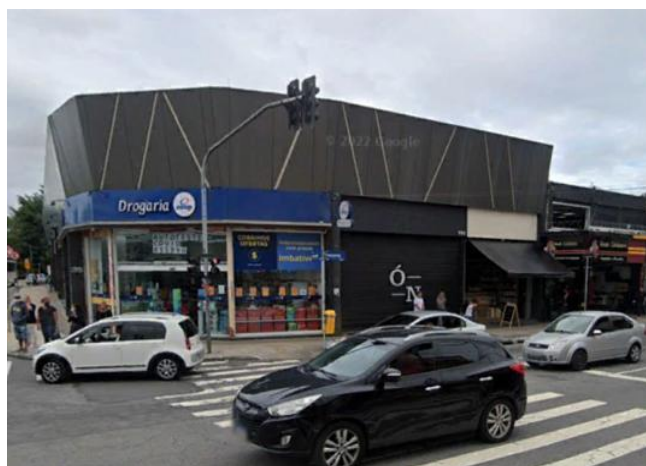
Foto 11.1-260: Vista do bloco 1 passível de desapropriação na Av. Industrial.
