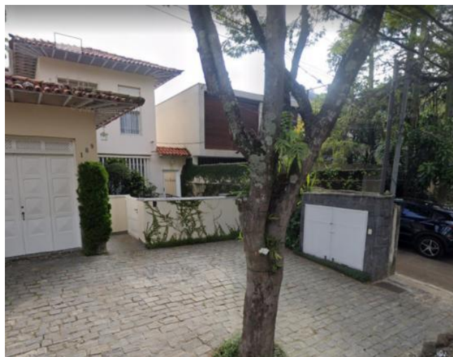
Foto 11.1-149: Vista do bloco passível de desapropriação na Rua Des. Mamede.
