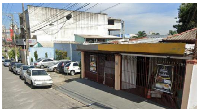
Foto 11.1-238: Vista do bloco 2 passível de desapropriação na Rua Afonsina.
