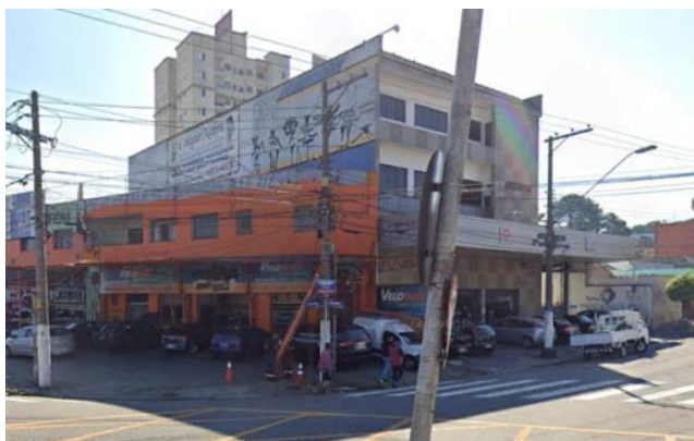
Foto 11.1-237: Vista do bloco 2 passível de desapropriação na Praça Palmares.
