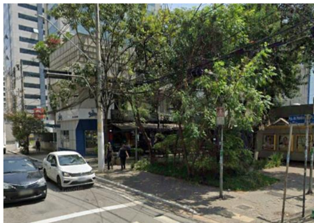
Foto 11.1-175: Vista do bloco passível de desapropriação na Avenida Ibirapuera.
