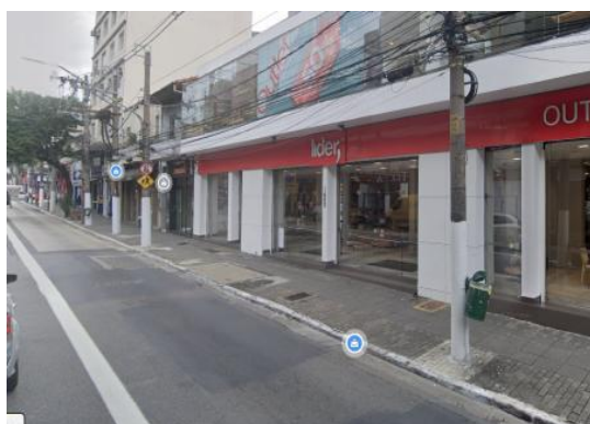
Foto 11.1-139: Vista do bloco 2 passível de desapropriação na rua Teodoro Sampaio.
