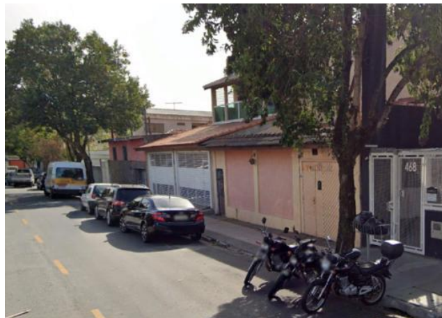
Foto 11.1-233: Vista do bloco passível de desapropriação na Rua Dr. Fausto Ribeiro de Carvalho.
