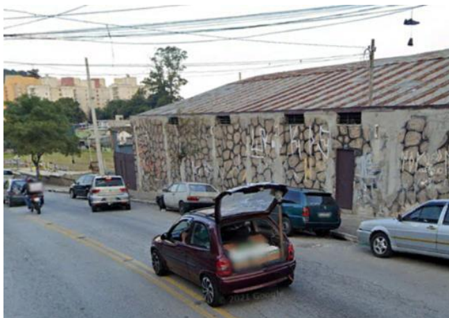
Foto 11.1-207: Vista do bloco 3 passível de desapropriação na Avenida Padre Arlindo Vieira.
