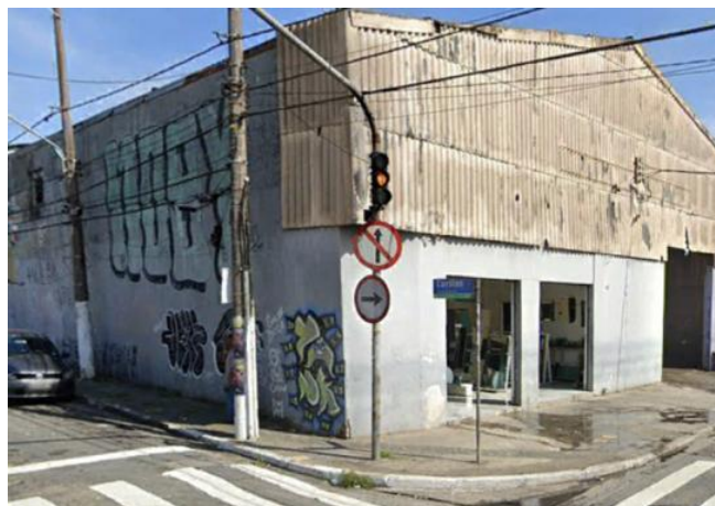
Foto 11.1-203: Vista do bloco 1 passível de desapropriação na Rua Simão Lopes.
