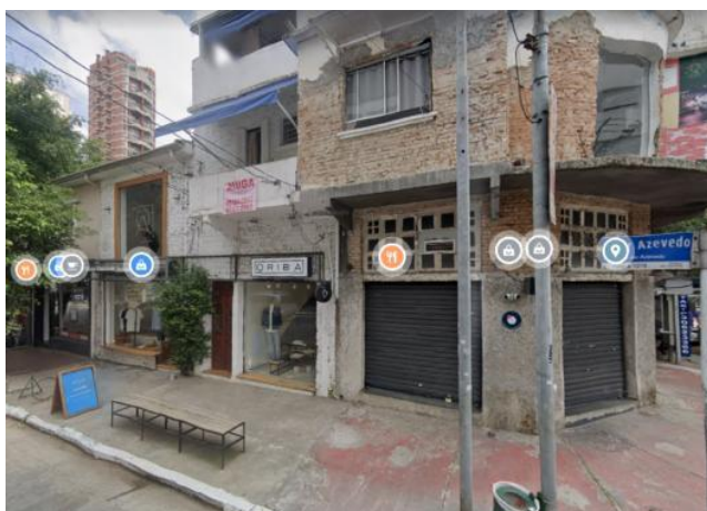
Foto 11.1-141: Vista do bloco passível de desapropriação na Rua Artur de Azevedo
