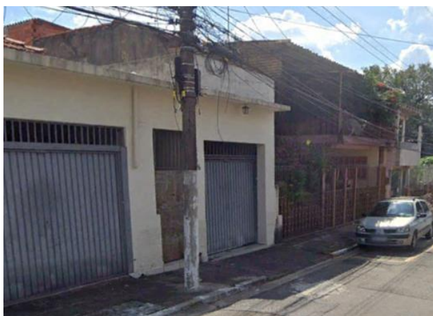
Foto 11.1-189: Vista do bloco passível de desapropriação na Rua Teresinha Gonçalves.
