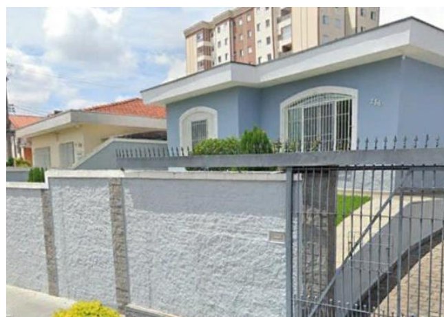
Foto 11.1-212: Vista do bloco passível de desapropriação na Rua Giovanni Carnovali.
