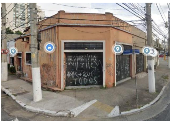
Foto 11.1-168: Vista do bloco 3 passível de desapropriação entre a Av. Santo Amaro e a Rua Silvânia.
