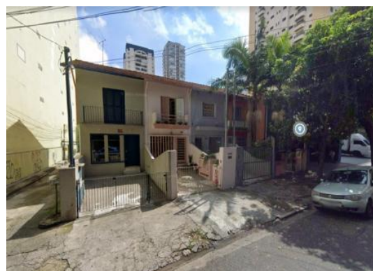
Foto 11.1-138: Vista do bloco 1 passível de desapropriação na Rua Joaquim Antunes
