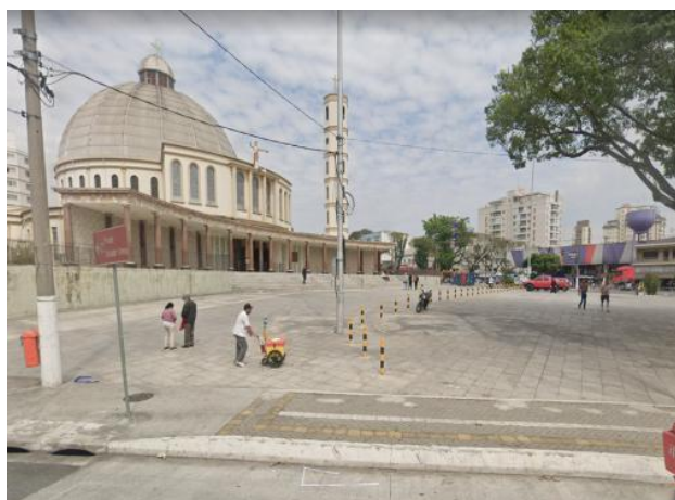
Foto 11.1-228: Vista do bloco 3 passível de desapropriação na Praça S. João Batista
