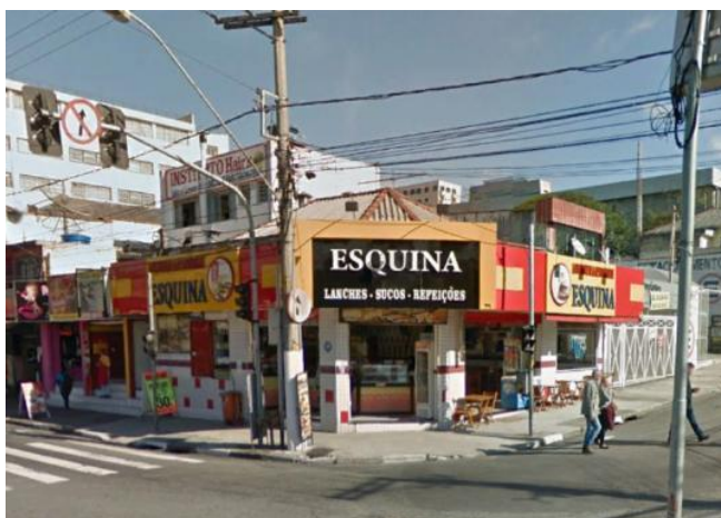
Foto 11.1-258: Vista do bloco 2 passível de desapropriação na Tv São João.
