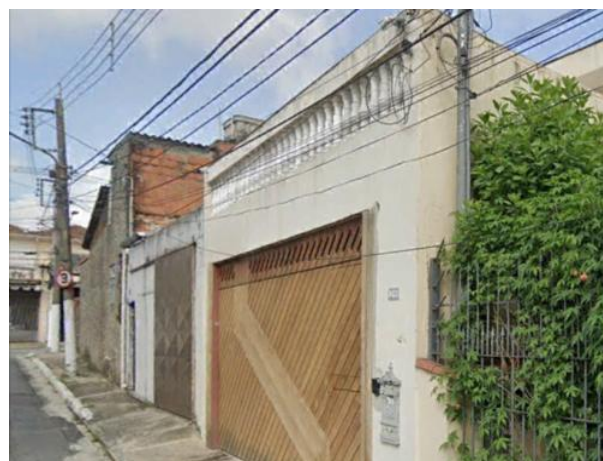
Foto 11.1-196: Vista do bloco passível de desapropriação na Rua Antônio Vieira da Cunha.
