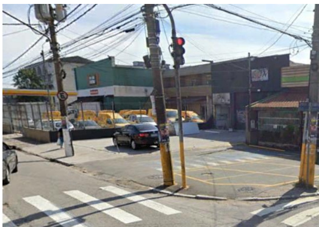
Foto 11.1-202: Vista do bloco 2 passível de desapropriação na Rua Simão Lopes.
