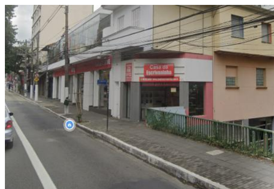
Foto 11.1-140: Vista do bloco 2 passível de desapropriação na rua Teodoro Sampaio.
