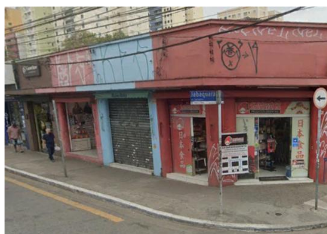
Foto 11.1-194: Vista do bloco passível de desapropriação na Avenida Jabaquara.
