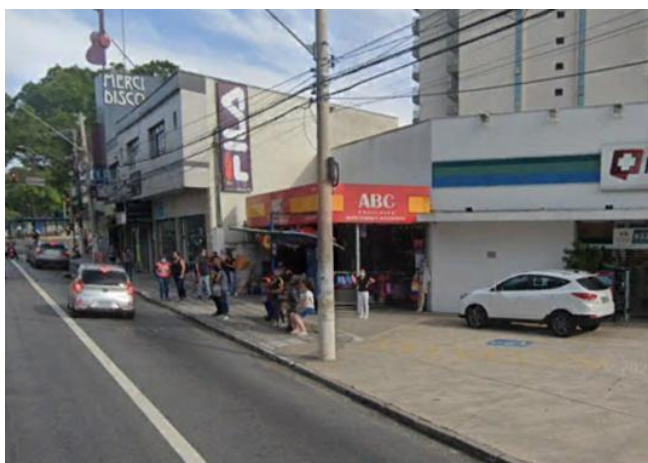
Foto 11.1-229: Vista do bloco 2 passível de desapropriação Avenida Dr. Rudge Ramos.
