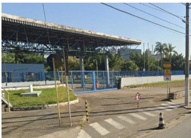
Foto 11.1-262: Vista do bloco passível de desapropriação na Avenida Antônio Cardoso.
