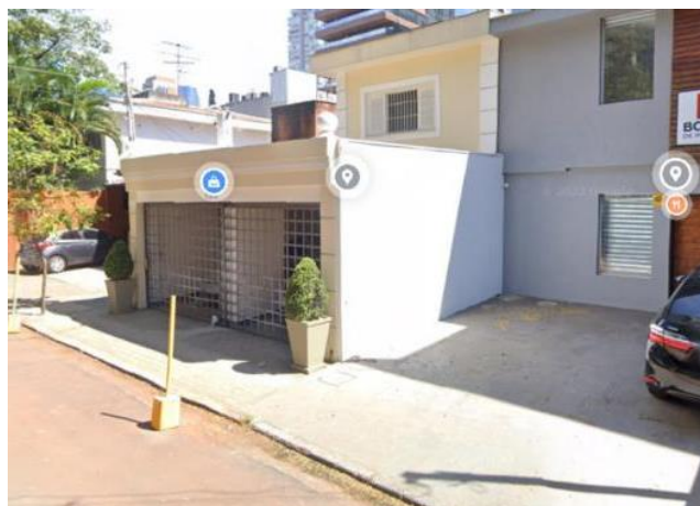
Foto 11.1-164: Vista do bloco 2 passível de desapropriação na Rua Min. Jesuíno Cardoso.
