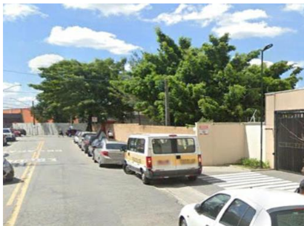
Foto 11.1-213: Vista do bloco passível de desapropriação na Rua Prof. Arnaldo João Semeraro.
