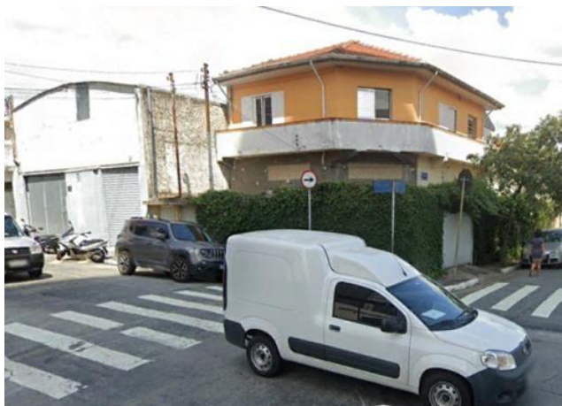
Foto 11.1-197: Vista do bloco passível de desapropriação na Rua Carlos Tiago Pereira.
