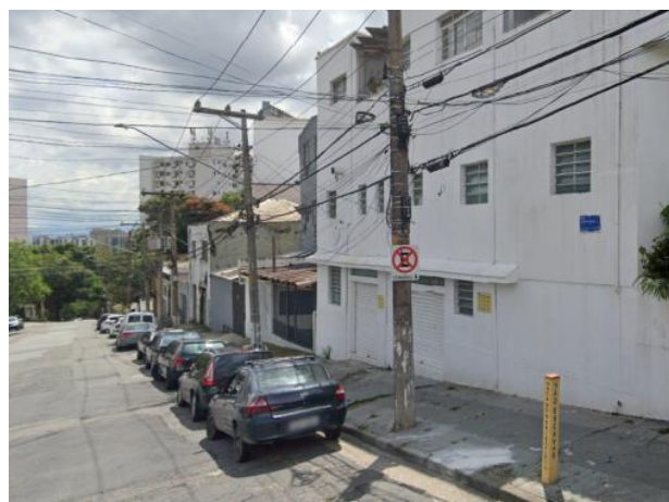
Foto 11.1-126: Vista do bloco 1 na Rua Antônio Borba.
