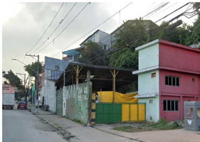
Foto 11.1-209: Vista do bloco 3 passível de desapropriação na Avenida Padre Arlindo Vieira.
