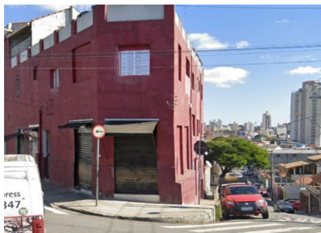
Foto 11.1-243: Vista do bloco passível de desapropriação na Avenida Novo Horizonte.
