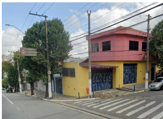
Foto 11.1-223: Vista do bloco passível de desapropriação na Avenida 31 de Março.
