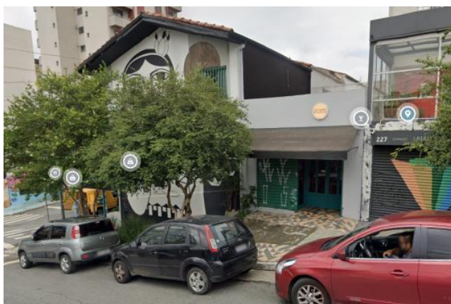
Foto 11.1-135: Vista do bloco passível de desapropriação na Rua Girassol.
