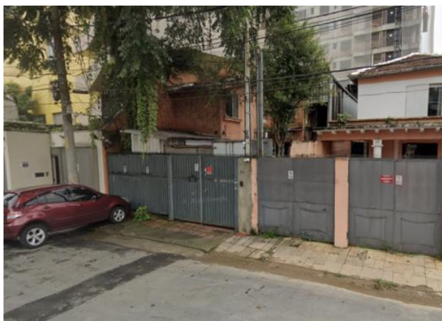
Foto 11.1-145: Vista do bloco 3 passível de desapropriação na Rua Teçaindá.
