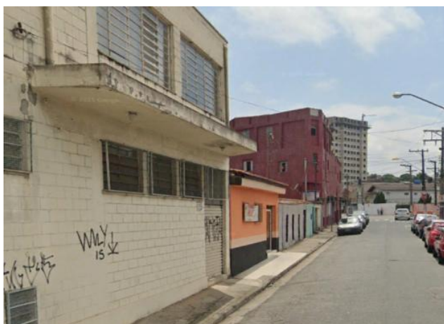
Foto 11.1-242: Vista do bloco passível de desapropriação na Rua Recife.
