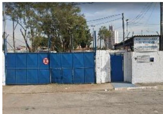
Foto 11.1-86. Pátio de Recolhimentos de Veículos
