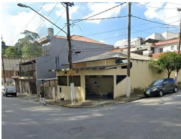
Foto 11.1-224: Vista do bloco passível de desapropriação na Praça Bartolomeu Ferrero.
