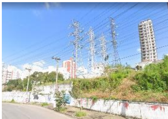
Foto 11.1-84. Torres de alta tensão
