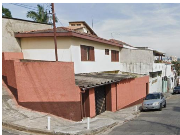
Foto 11.1-241: Vista do bloco passível de desapropriação na Rua Santa Clara.
