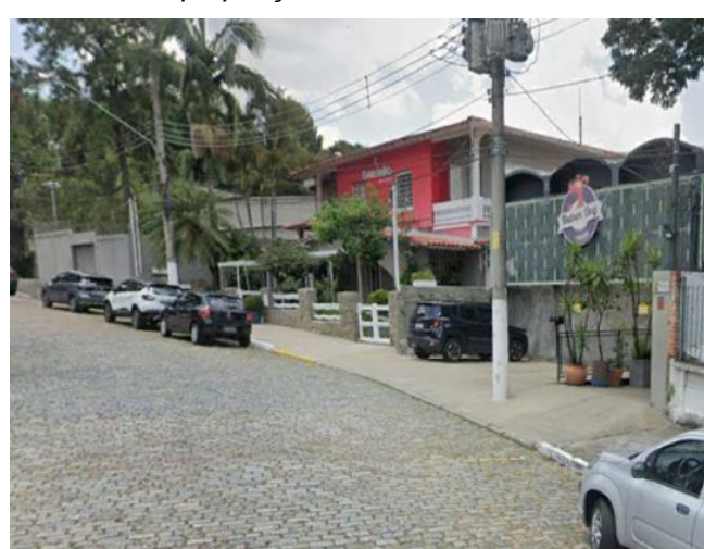
Foto 11.1-182: Vista do bloco 2 passível de desapropriação na Avenida Jamaris.
