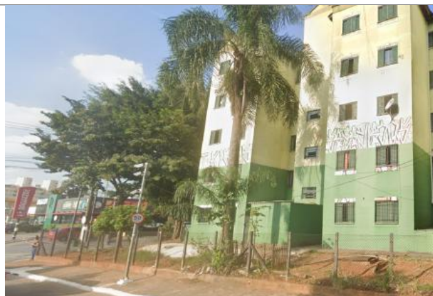
Foto 10.2-7 : Detalhamento da ZA na ADA na Estação Abraão de Moraes (edifício residencial).
