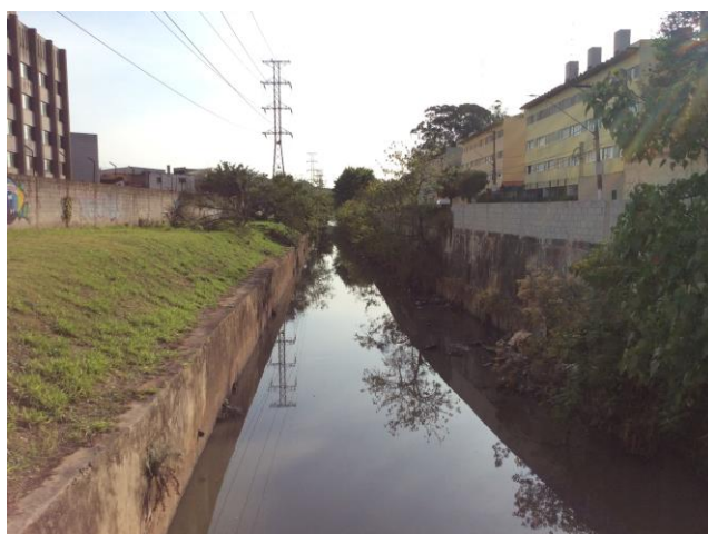
Foto 10.3-7 : Vista geral do Córrego do Taboão.
