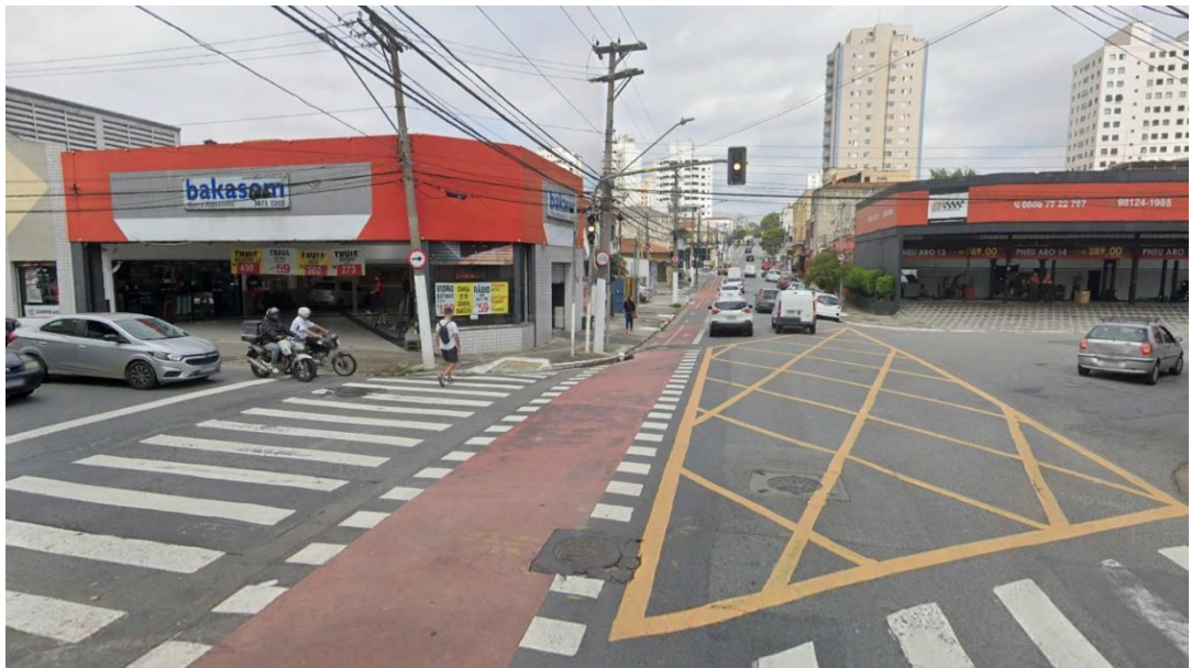
Figura 9.10-25: Interferência 7, Córrego Tiburtino canalizado em tubulação/galeria, na altura da R. Coriolano em São Paulo, e mapa de localização do ponto.
