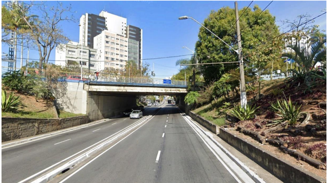
Figura 9.10-55: Interferência 37, Córrego do Cemitério/Carapetuba canalizado em tubulação/galeria, na altura da Av. Ramiro Colleoni em Santo André, e mapa de localização do ponto.
