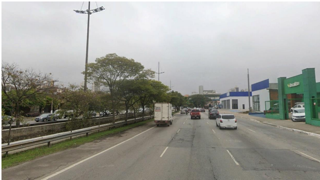
Figura 9.10-39: Interferência 21, Córrego Ipiranga canalizado a céu aberto, na altura da Av. Abraão de Moraes em São Paulo, e mapa de localização do ponto.
