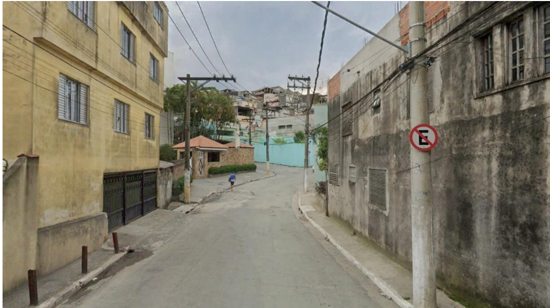
Figura 9.10-42: Interferência 24, Córrego Moinho Velho canalizado em tubulação/galeria, na altura da R. Sebastião Mazzoni em São Paulo, e mapa de localização do ponto.
