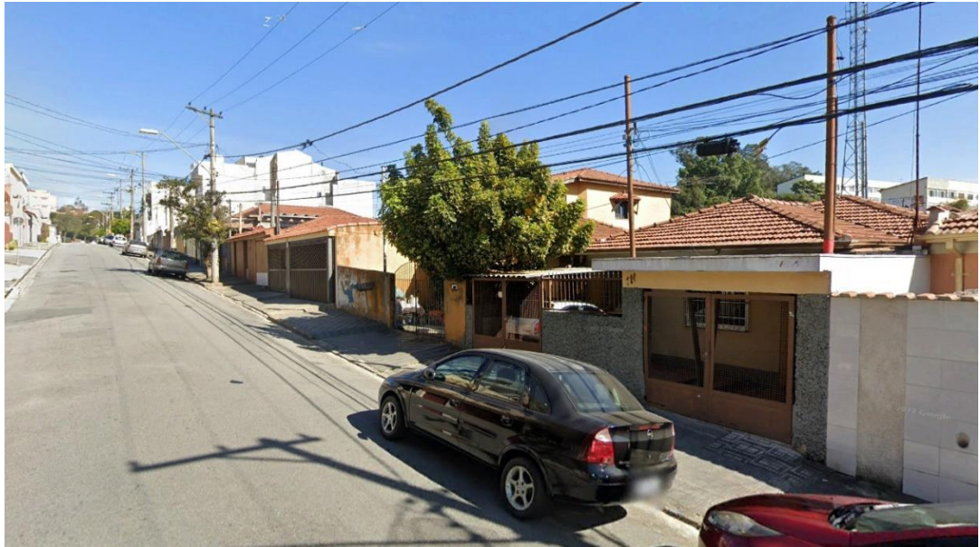
Figura 9.10-53: Interferência 35, Sem Nome 32 canalizado em tubulação/galeria, na altura da R. Corumba em Santo André, e mapa de localização do ponto.
