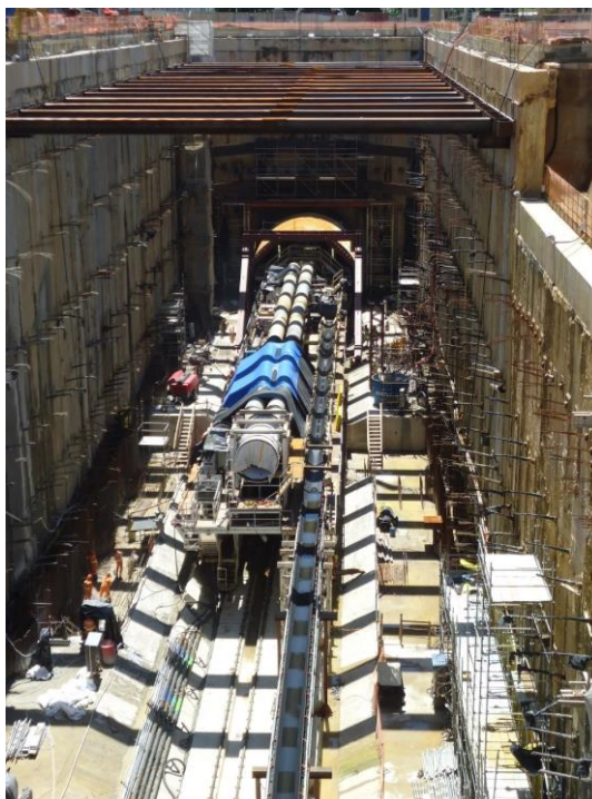
Figura 7.3-7: Montagem da tuneladora em uma estação escavada através de VCA.
