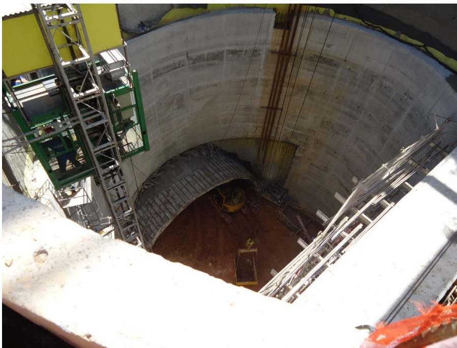
Figura 7.3-13: Detalhe do emboque do túnel de ligação.
