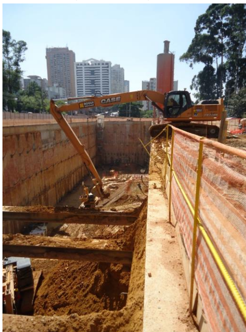
Figura 7.3-5: Vista da escavação de estação em VCA a partir da superfície.
