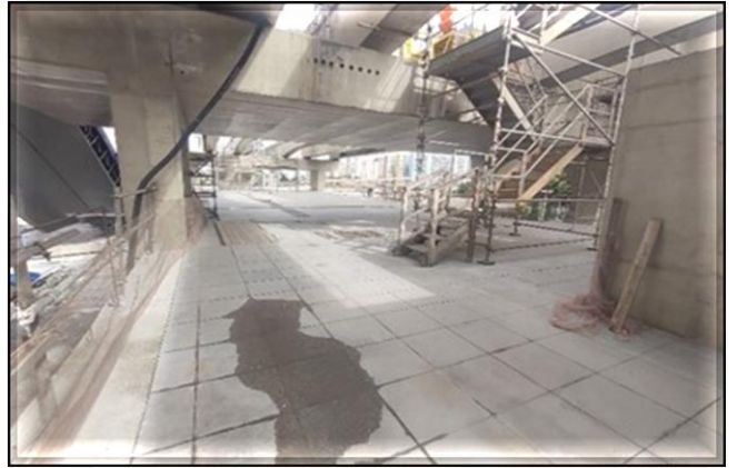
ETO/ Obra Civil – Execução do acabamento.
