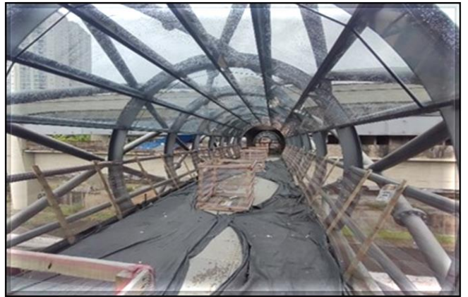
Acesso B/Obra Civil – Instalação dos vidros da passarela.
