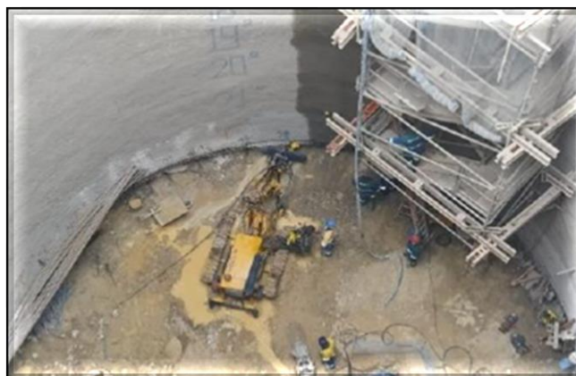
Escavação do poço.
