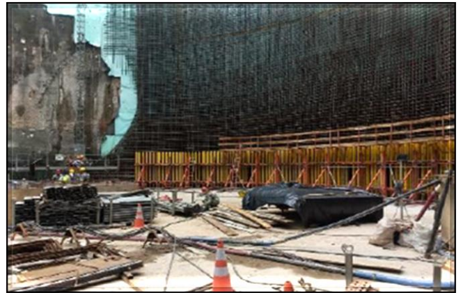
Laje de fundo do poço do corpo da estação concretada.
