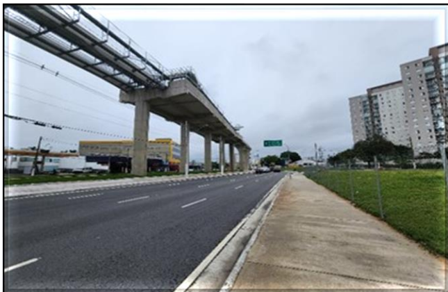
Obra Civil – Viário entregue em 19/10/2022. Sistemas – Aguarda liberação para operação comercial.
