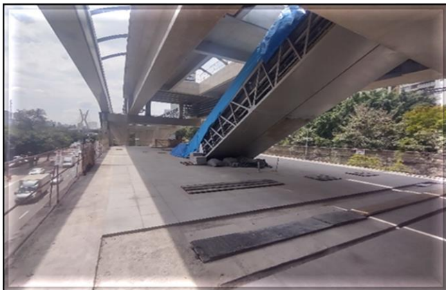
Corpo da Estação/Obra Civil – Execução do acabamento.
