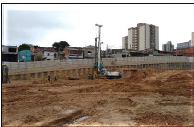
Estacas de contenção.
