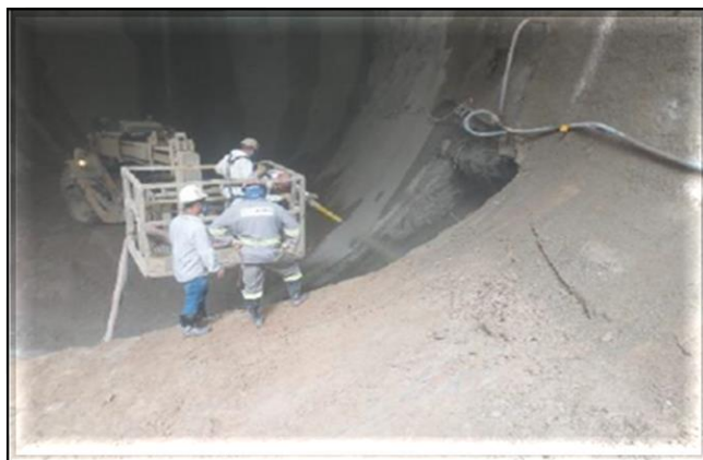
Escavação do túnel de ligação do corpo da estação.
