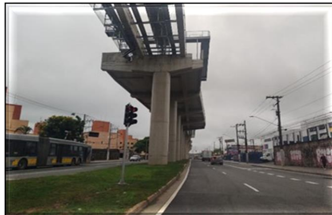
Obra Civil – Serviços concluídos. Sistemas – Aguarda liberação para operação comercial.
