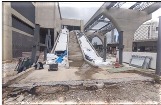
Acesso/ Sistemas – Montagem das escadas rolantes.
