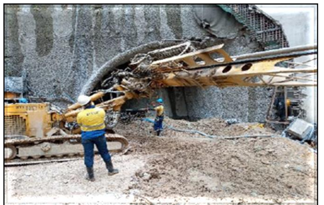
Tratamento do túnel de transição.
