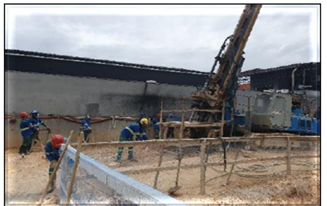
Tratamento de maciço com jet grouting .
