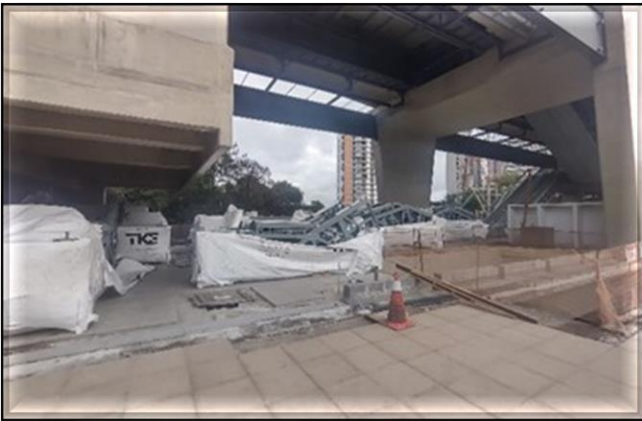
Corpo da Estação/Obra Civil – Posicionamento das escadas rolantes.
