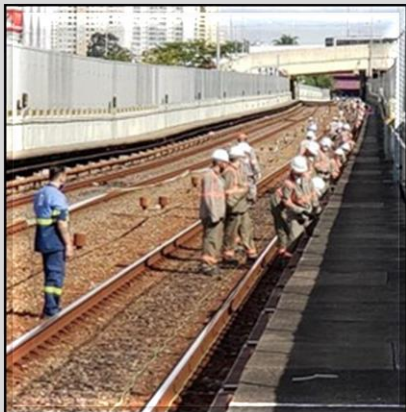
Lançamento de cabos do CBTC
