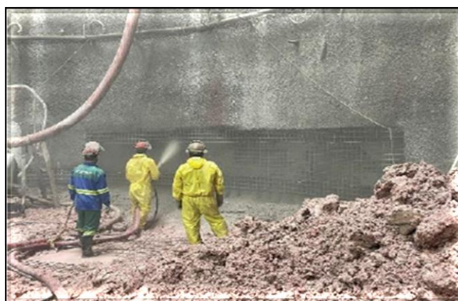
Escavação do poço.
