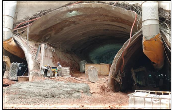
Escavação do túnel de transição.
