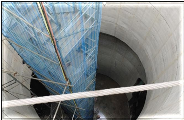
Revestimento secundário do poço finalizado..
