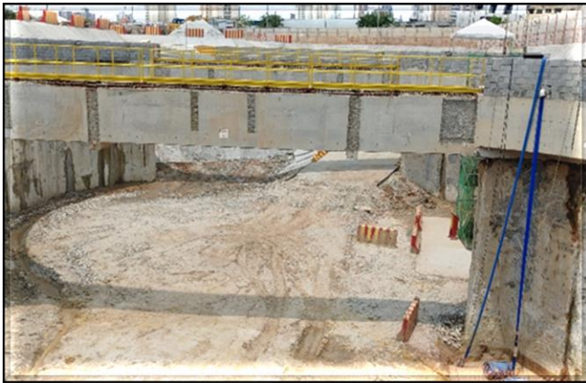
Escavação dos poços do corpo da estação.
