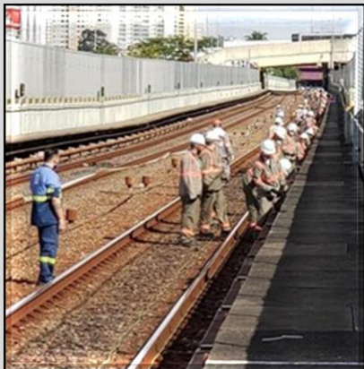
Lançamento de cabos do CBTC
