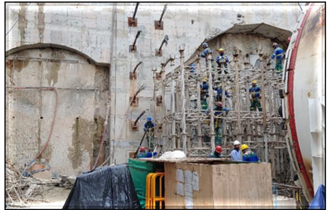
Corte da parede da vala para partida da Tunneladora.
