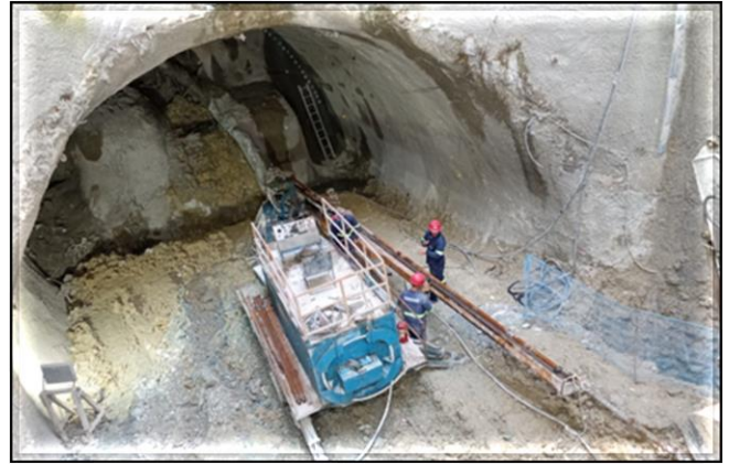
Escavação do túnel de ligação.
