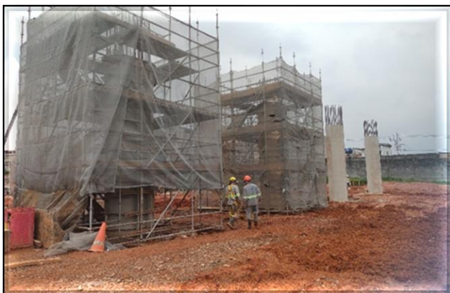
Em andamento a demolição dos galpões, retirada do entulho, execução das estações, blocos e pilares da via de estacionamento.
