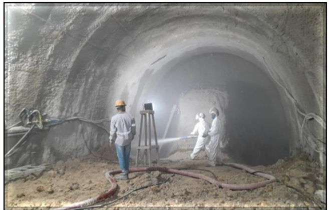
Escavação do túnel singelo.
