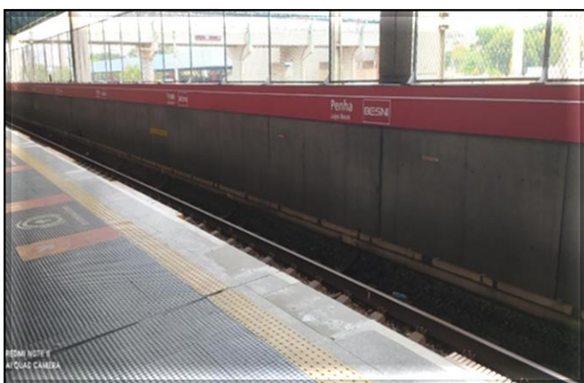
Reforço da borda da plataforma
