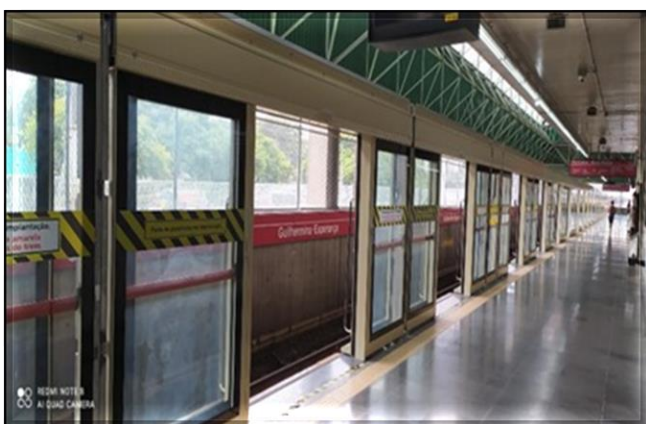
Montagem das fachadas nas vias 1 e 2
