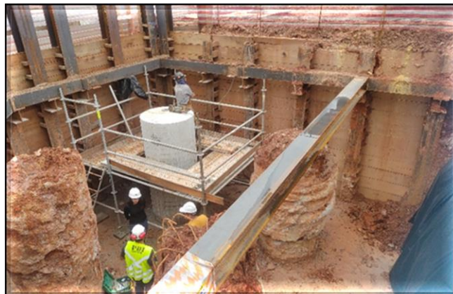
Em execução a fundação do corpo da estação.
