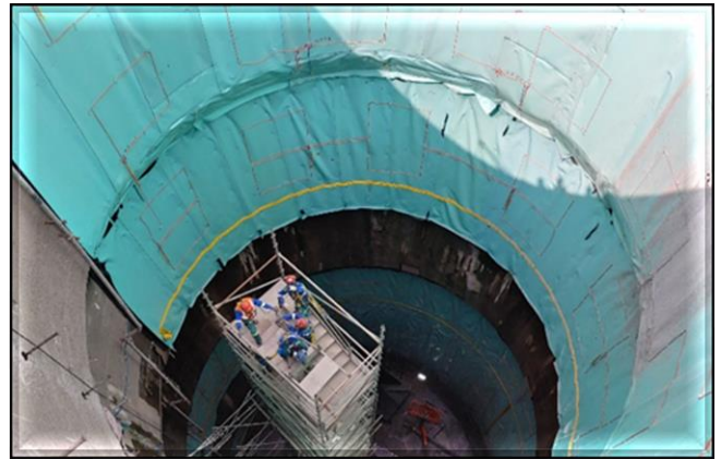
Impermeabilização da parede do poço.
