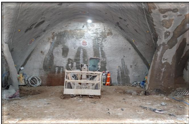
Escavação dos túneis do corpo da estação.
