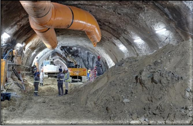
Escavação do túnel de via
