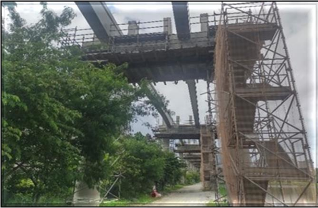
Vias do Monotrilho/Obra Civil – Execução da monolitização e tratamentos.
