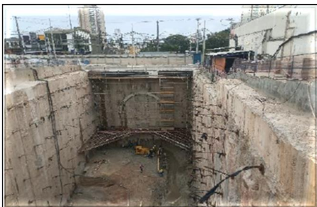
Escavação, tirantes e estroncamento da vala do corpo da estação.
