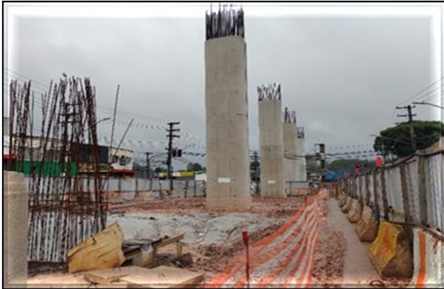
Obra Civil – Execução das fundações, pilares e capitéis da via elevada.
