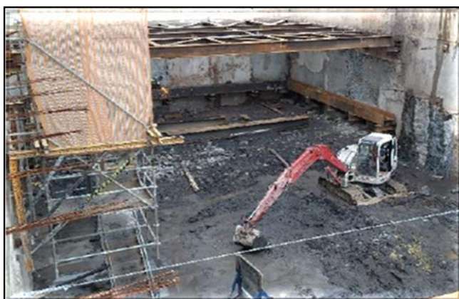
Escavação, tirantes e estroncamento da vala.
