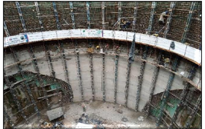
Parede do revestimento secundário do poço.
