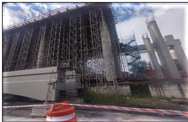
Obra Civil – Execução do track switch .
