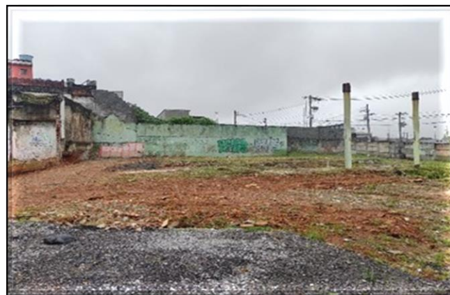
Em andamento limpeza do terreno e mobilização do canteiro.
