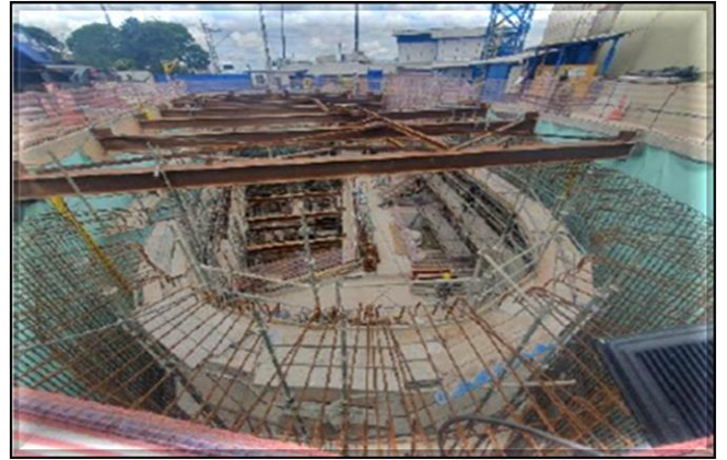
Estrutura de concreto do acesso secundário
