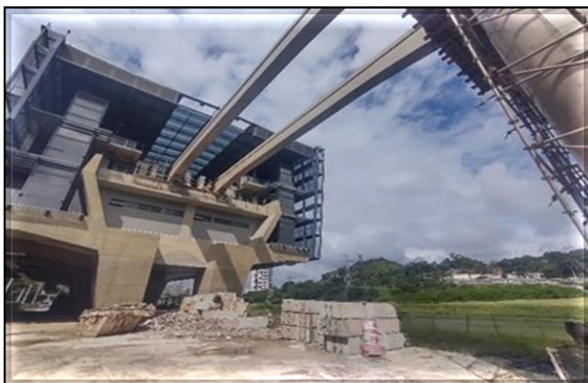
Corpo da Estação/ Obra Civil – Execução da monolitização das vigas-guia.
