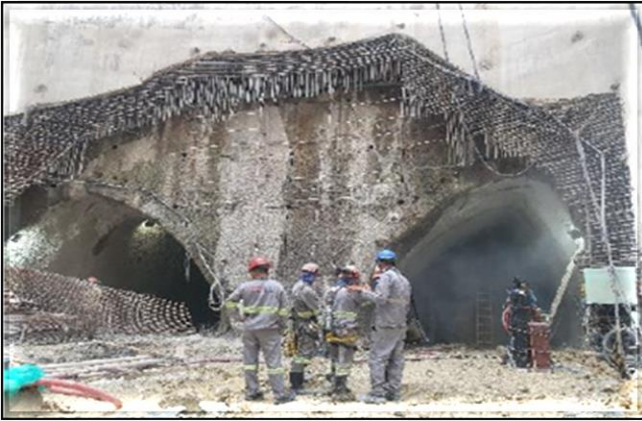
Escavação do túnel de via
