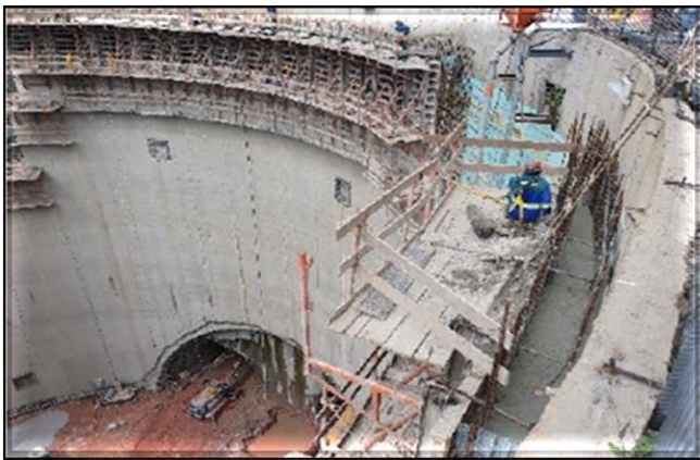
Revestimento secundário do poço do corpo da estação.
