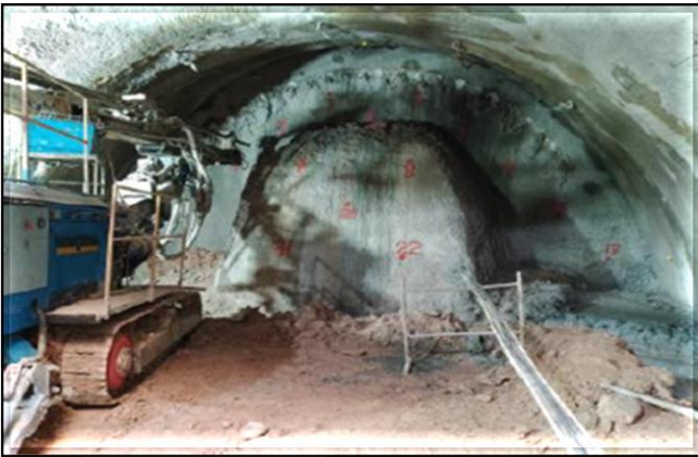
Escavação do túnel de ligação.
