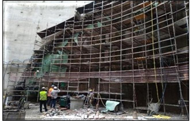
Corte do revestimento primário do poço para escavação do túnel.
