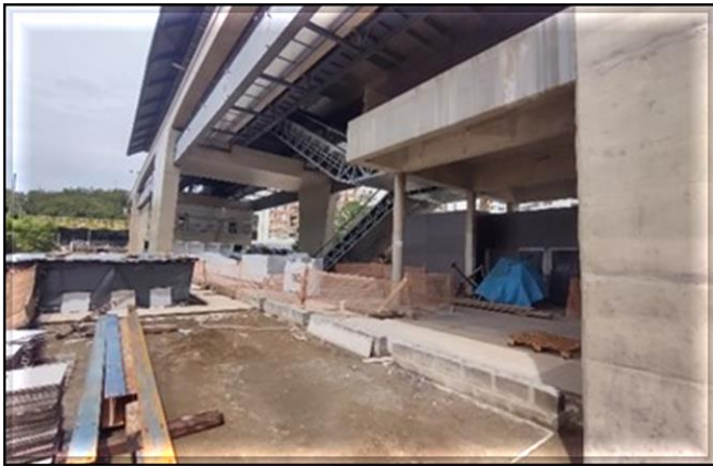
Corpo da Estação/Obra Civil – Obra civil paralisada. Dez Escadas Rolantes posicionadas.
