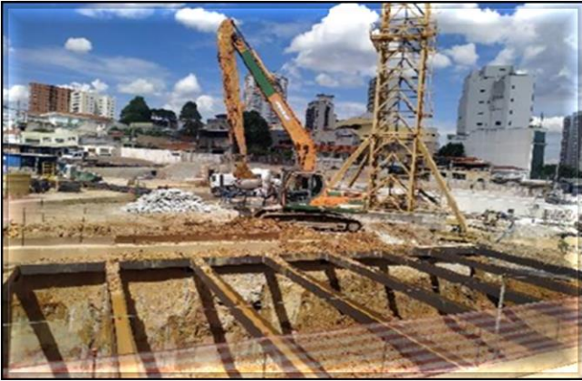
Estruturas de concreto e escavação do corpo da estação.
