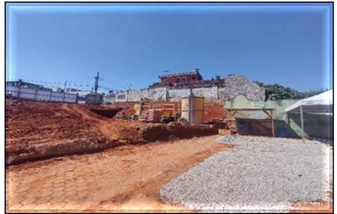
Em andamento limpeza do terreno, mobilização do canteiro e grampeamento do talude.
