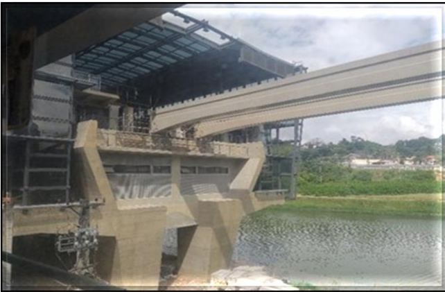
Corpo da Estação/ Obra Civil – Obra civil paralisada. Oito Escadas Rolantes posicionadas.
