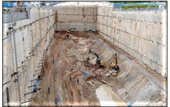
Execução de tirantes e viga de coroamento.
