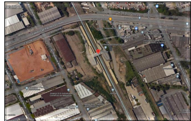
Processo licitatório para contratação da obra civil e implantação de sistemas publicado no DOE em 24/09/2022.
