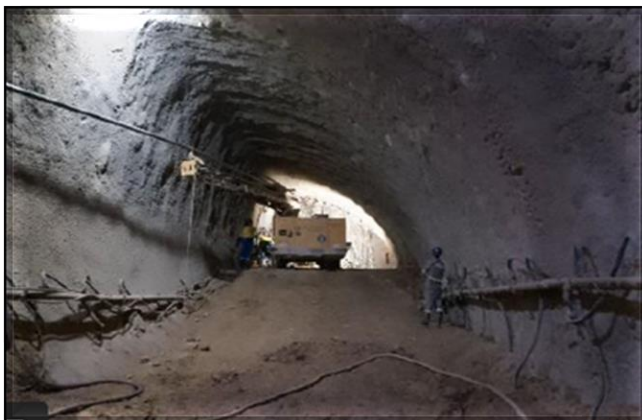
Escavação dos túneis de via do corpo da estação.
