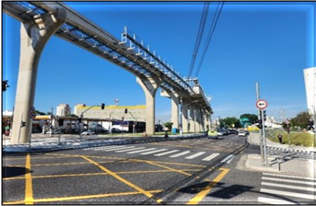
Obra Civil – Viário entregue em 19/10/2022. Sistemas – Emitida a liberação para operação.
