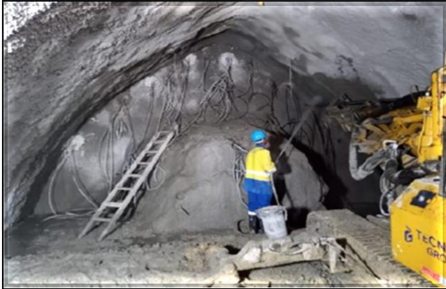
Escavação do túnel de via
