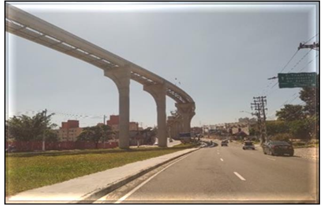
Obra Civil – Serviços concluídos. Sistemas – Emitida a liberação para operação.
