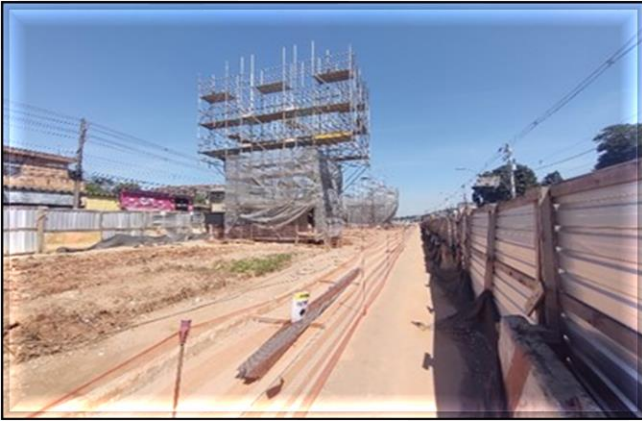
Obra Civil – Execução das fundações, pilares e capitéis da via elevada.
