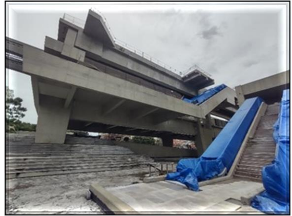
Corpo e Acesso da Estação/ Obra Civil – Obra civil paralisada. Quatro Escadas Rolantes posicionadas.
