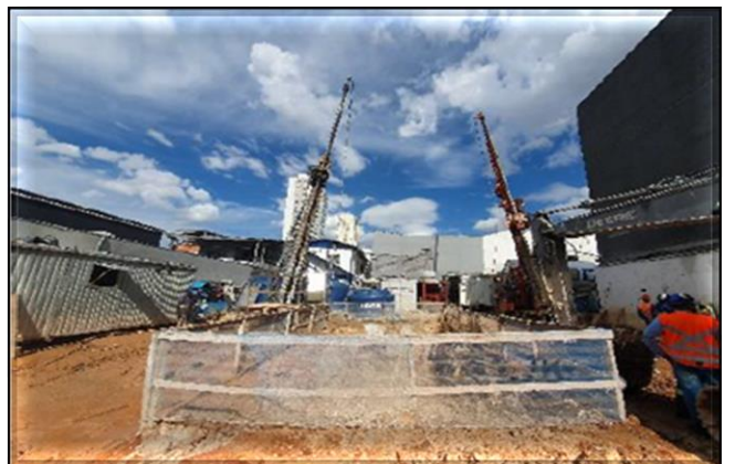
Tratamento de maciço com jet grouting .
