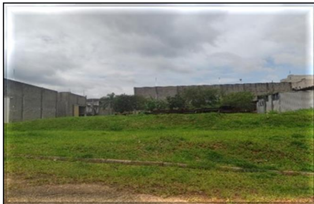
Em andamento a elaboração dos projetos executivos e obtenção de licença de instalação.
