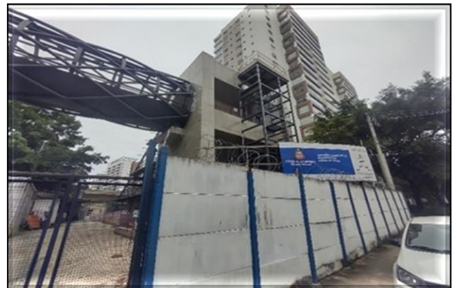
Acesso da Estação/ Obra Civil – Obra civil paralisada. Dez Escadas Rolantes posicionadas.
