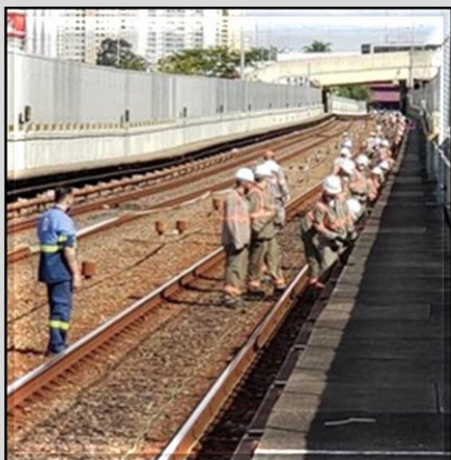
Lançamento de cabos do CBTC
