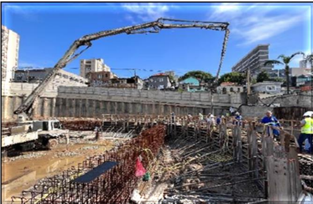
Viga de coroamento.
