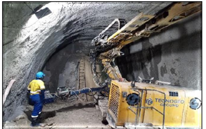
Tratamento do túnel de transição.
