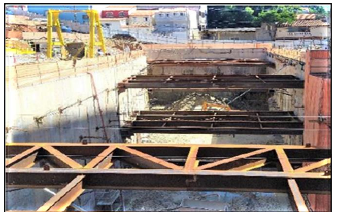
Escavação, tirantes e estroncamento da vala.
