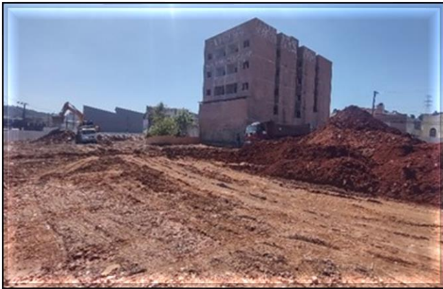
Em andamento limpeza do terreno e mobilização do canteiro.
