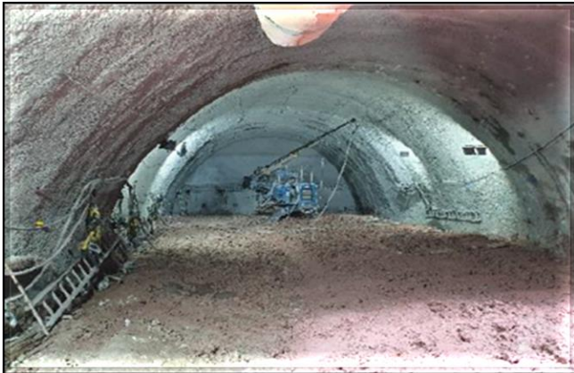
Escavação do túnel de ligação.
