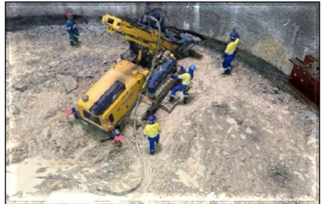
Escavação do poço.
