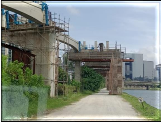
Vias do monotrilho/ Obra Civil – Obra civil paralisada.
