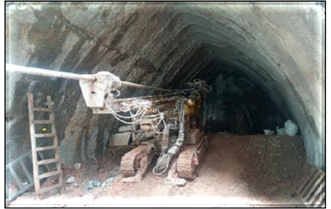
Escavação do túnel de transição.
