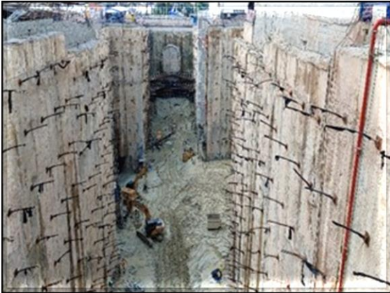
Escavação e tirantes da vala do corpo da estação.
