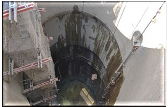
Escavação do poço.
