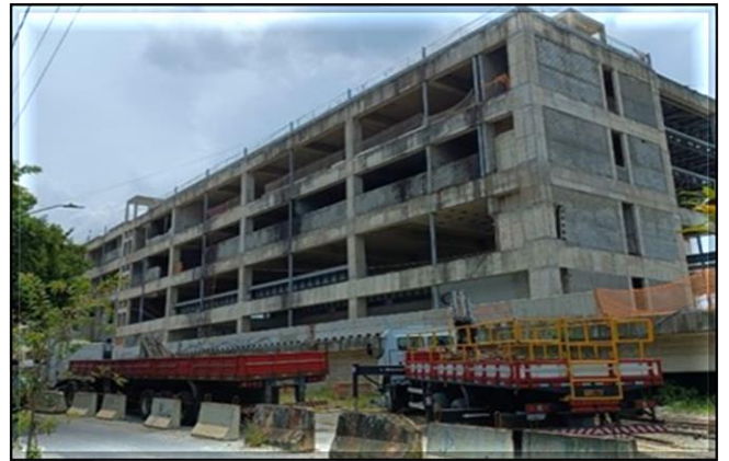
Bloco A/Obra Civil – Obra civil paralisada.
