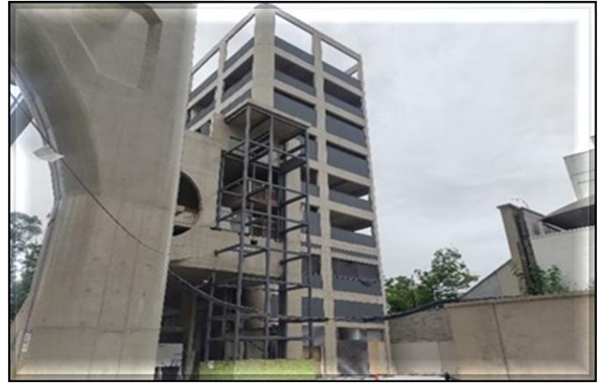
Corpo da Estação/ Obra Civil – Obra civil paralisada. Oito Escadas Rolantes posicionadas.
