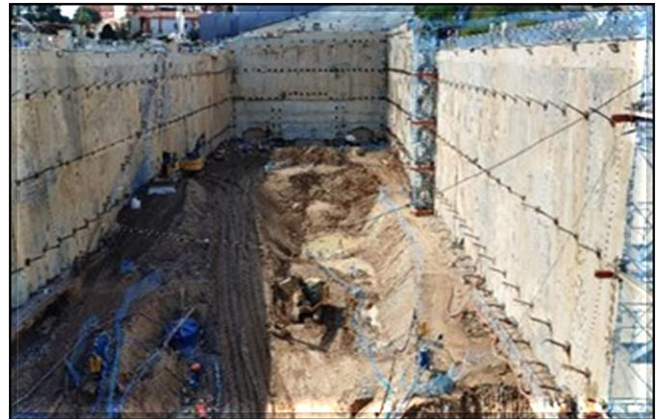
Escavação e tirantes.
