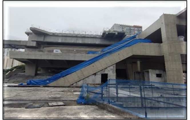
Corpo e Acesso da Estação/ Obra Civil – Obra civil paralisada. Quatro Escadas Rolantes posicionadas.
