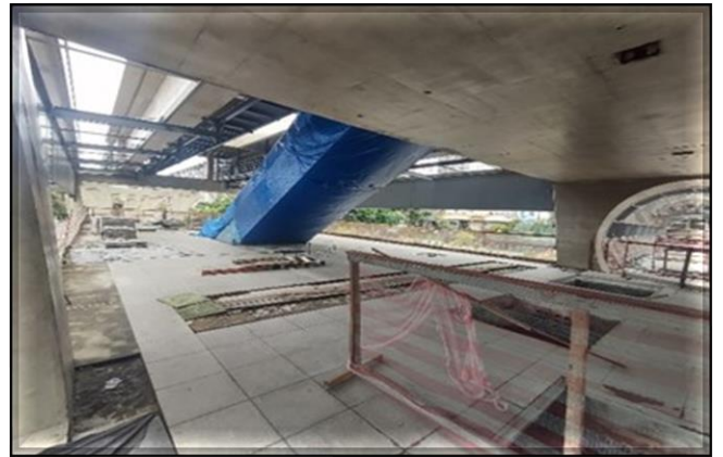
Acesso da Estação/ Obra Civil – Obra civil paralisada. Seis Escadas Rolantes posicionadas.
