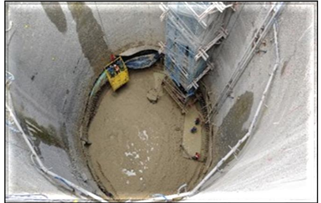
Laje de fundo do poço.
