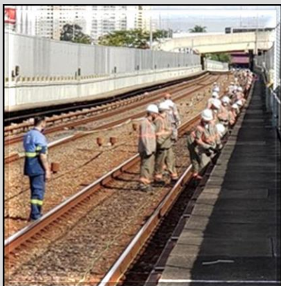
Lançamento de cabos do CBTC
