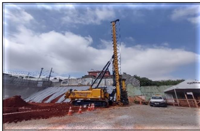
Em andamento limpeza do terreno, mobilização do canteiro e cravação de perfis metálicos.
