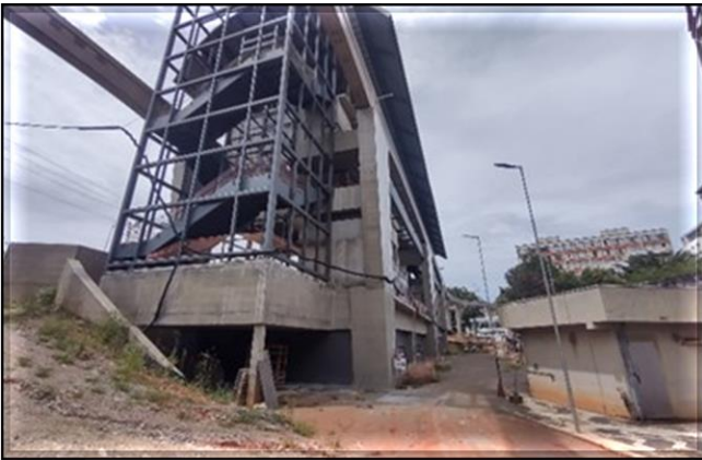
Corpo da Estação/Obra Civil – Obra civil paralisada. Dez Escadas Rolantes posicionadas.
