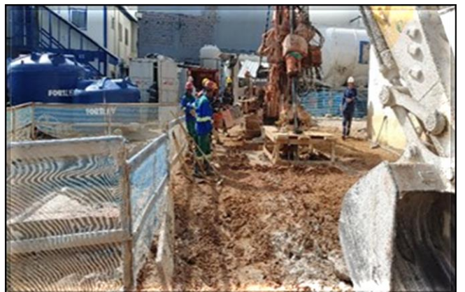
Tratamento de maciço com jet grouting .
