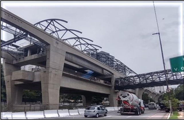
Acesso da Estação/ Obra Civil – Obra civil paralisada. Seis Escadas Rolantes posicionadas.
