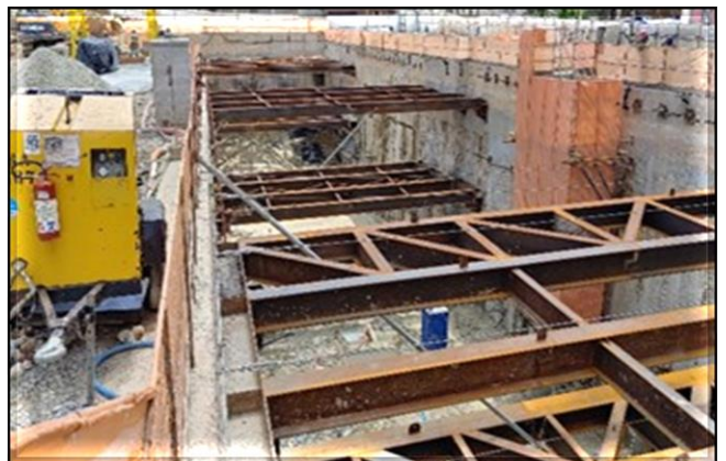
Escavação, tirantes e estroncamento da vala.
