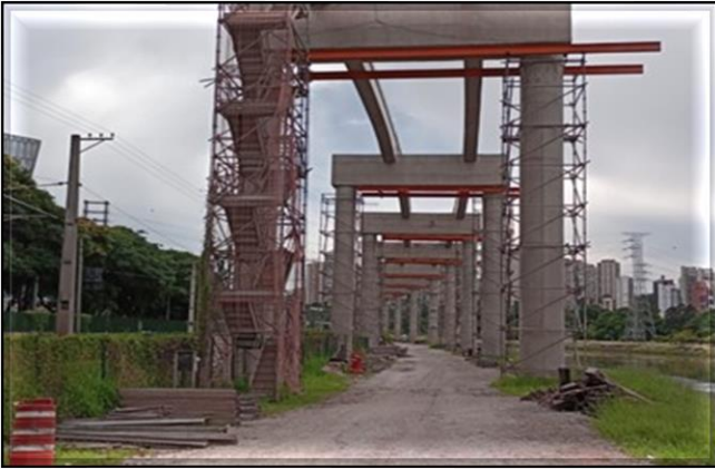
Vias do monotrilho/ Obra Civil – Obra civil paralisada.
