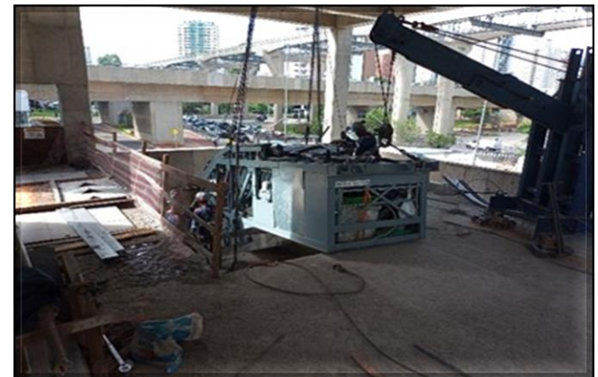
Acesso da Estação/ Obra Civil – Obra civil paralisada. Doze Escadas Rolantes posicionadas.
