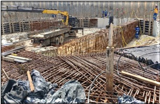
Viga de coroamento.
