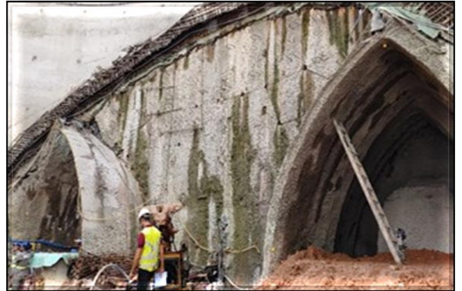
Escavação do túnel de transição.
