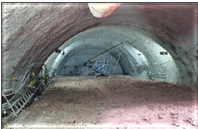
Escavação do túnel de ligação.
