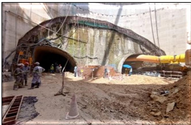
Escavação do túnel de transição.
