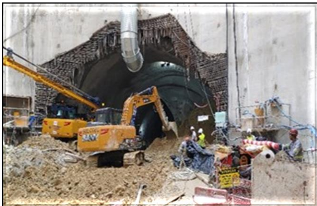
Escavação do túnel de via
