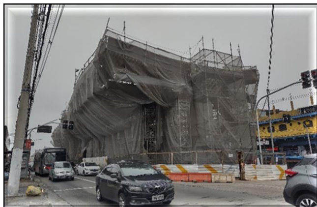
Obra Civil – Execução das fundações, pilares e capitéis da via elevada, montagem do cimbramento, forma e armação da laje dos track switches.
