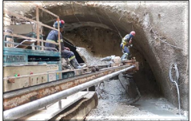
Escavação do túnel de ligação.
