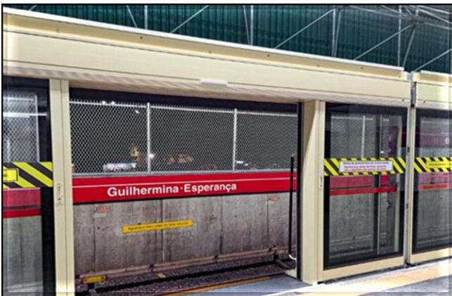
Iniciada a montagem das portas
