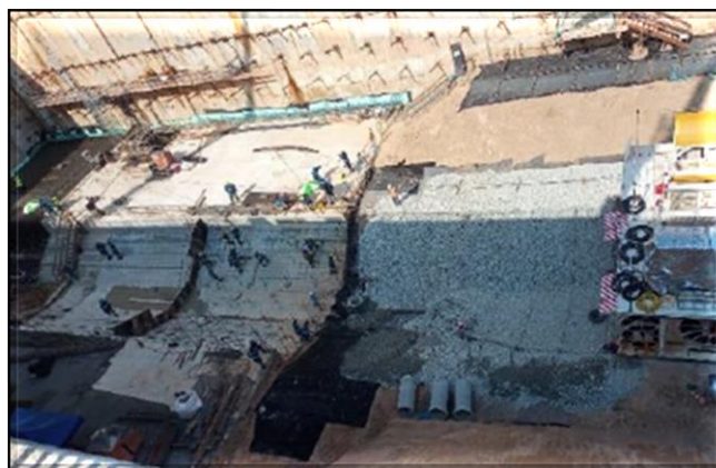
Laje de fundo da vala.
