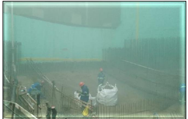
Impermeabilização da parede do poço.
