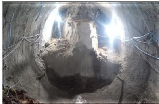
Escavação do túnel de transição.
