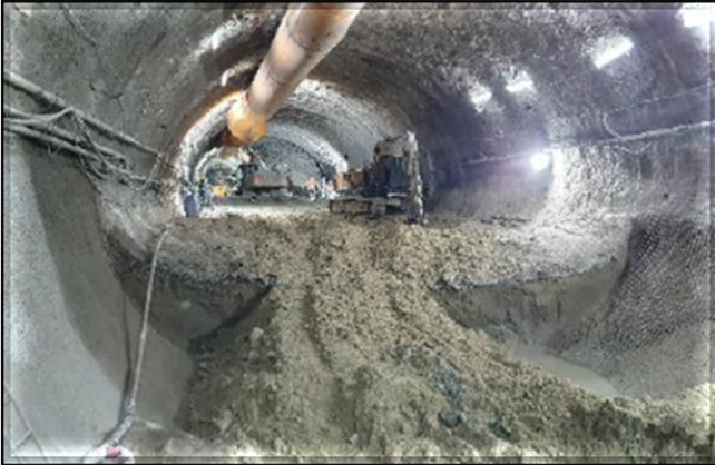
Escavação do túnel de via
