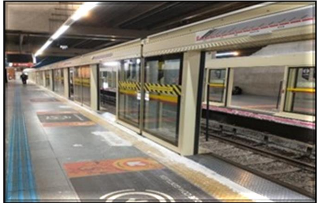
Fachada das portas de plataforma | Instaladas 4/4 fachadas. (em testes).
