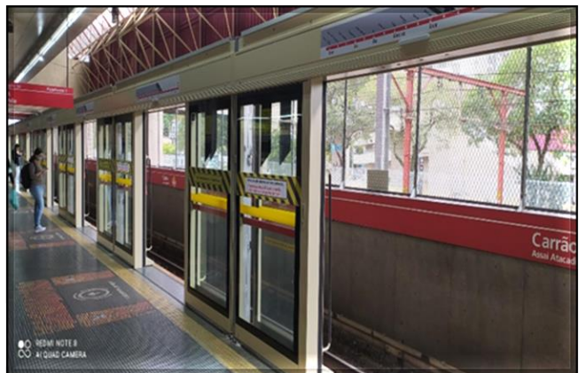
Instalada a fachada da via 1
