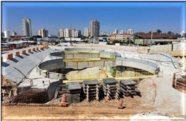
Escavação dos poços do corpo da estação.
