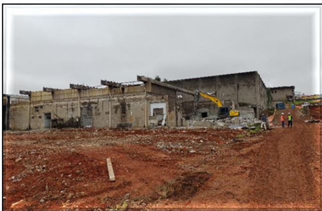
Em andamento a demolição dos galpões e retirada do entulho.
