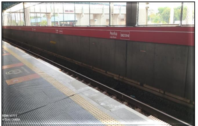
Reforço da borda da plataforma
