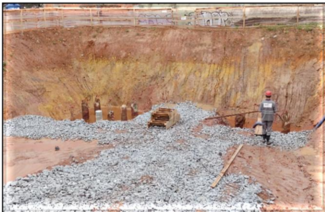
Em andamento a execução da fundação do corpo do acesso norte.
