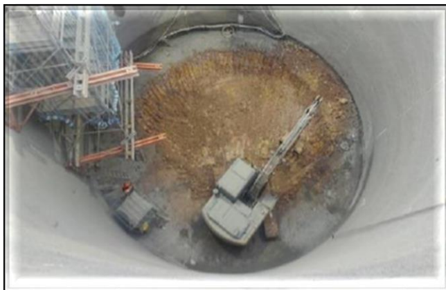
Escavação do poço.
