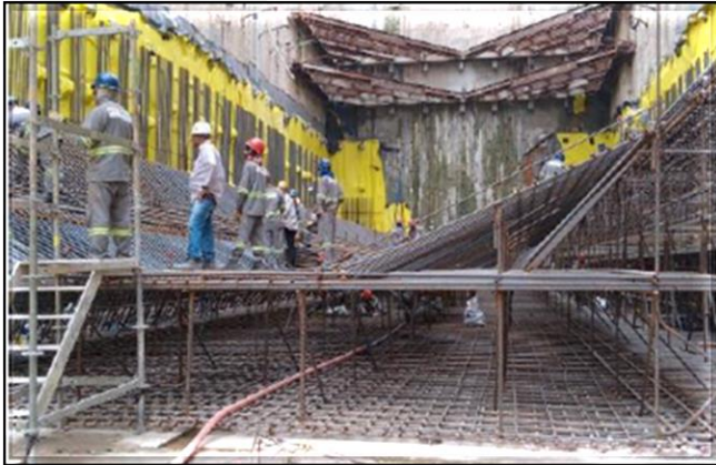
Impermeabilização e laje de fundo do corpo da estação.
