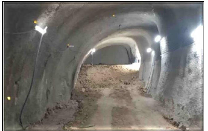
Escavação do túnel singelo.
