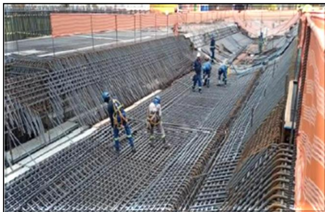
Laje de fundo da vala do corpo da estação.
