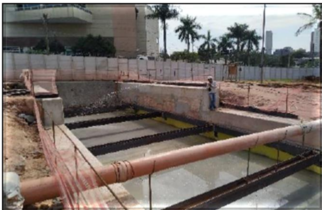
Laje de cobertura da vala do acesso secundário.
