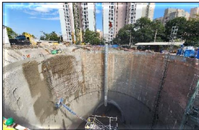
Reforço do poço do corpo da estação.
