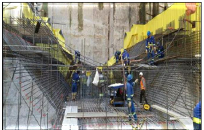
Escavação e lastro da laje de fundo da vala.
