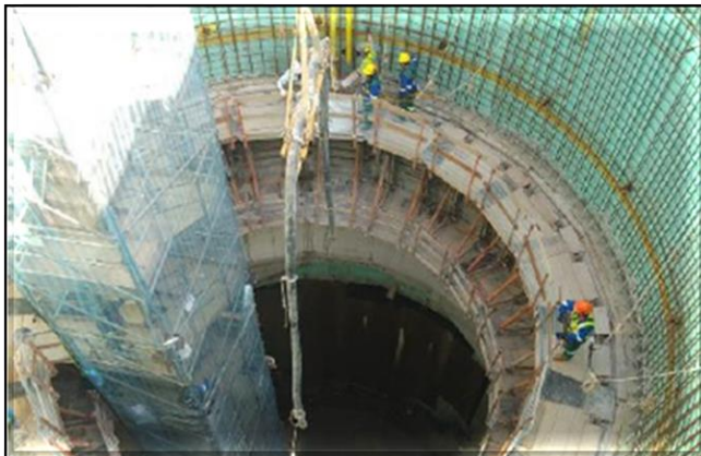
Revestimento secundário do poço.
