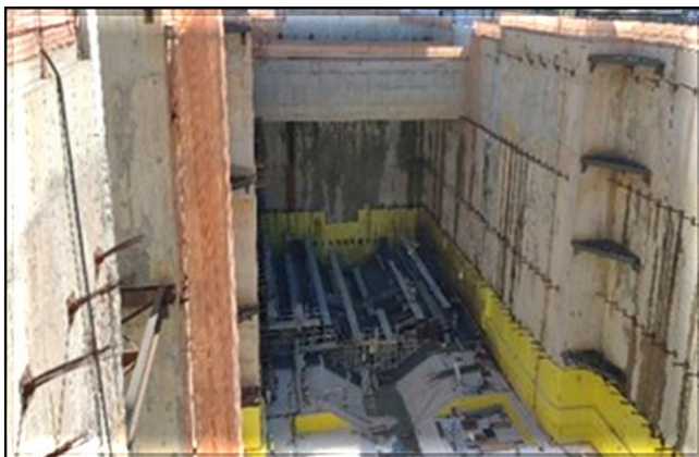
Escavação, tirantes e laje de fundo da vala do corpo da estação.
