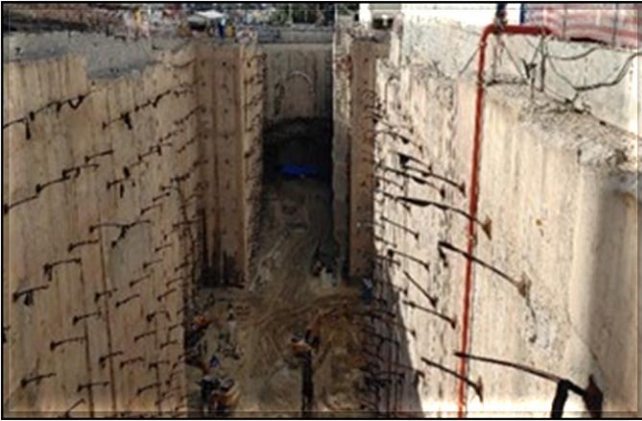
Escavação e tirantes da vala do corpo da estação.
