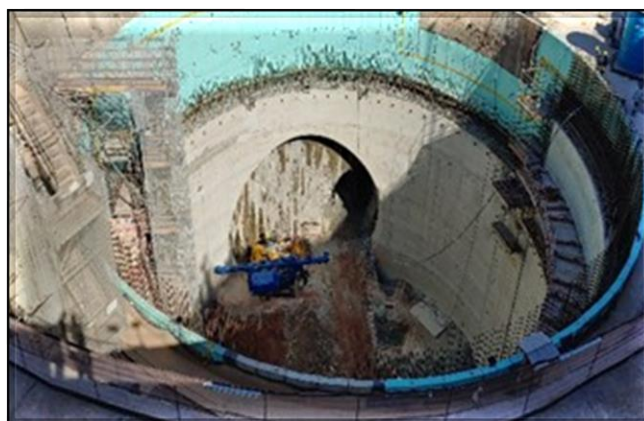
Escavação do túnel de corpo da estação.
