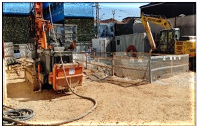
Tratamento de maciço com jet grouting .
