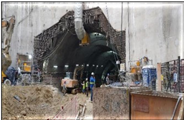
Escavação do túnel de via
