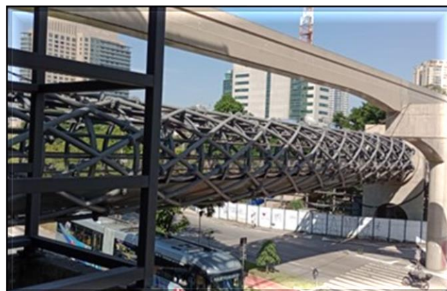
Corpo da Estação/ Obra Civil – Em andamento a contratação direta do escopo remanescente.
