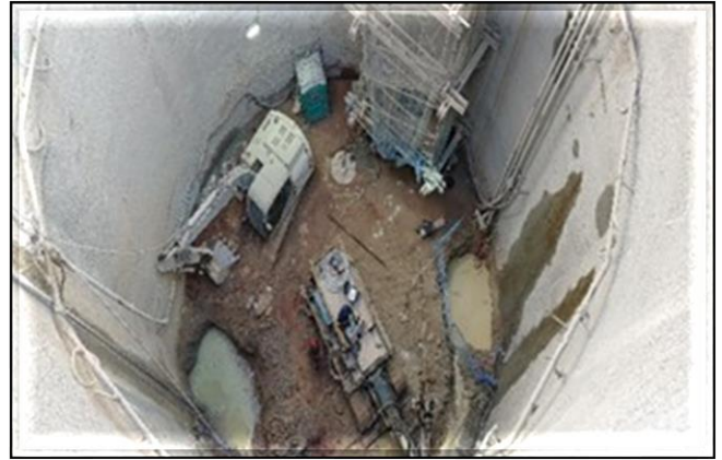
Escavação do túnel de ligação.
