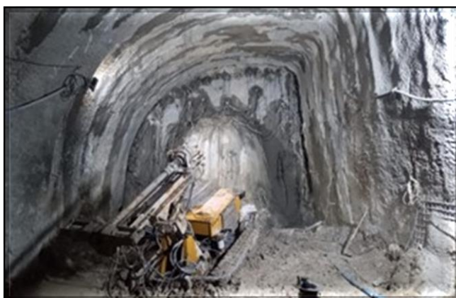
Escavação do túnel de transição.
