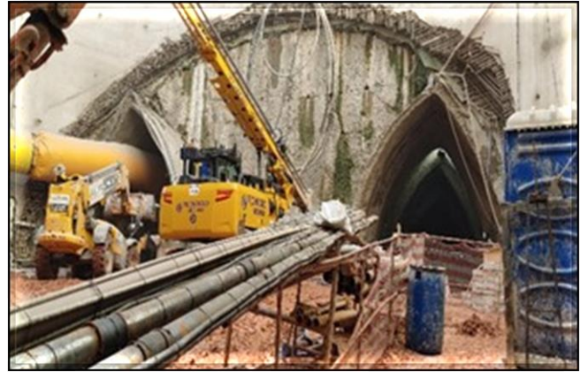
Escavação do túnel de transição.
