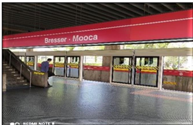
Fachada das portas de plataforma | Instaladas 2/2 fachadas.
