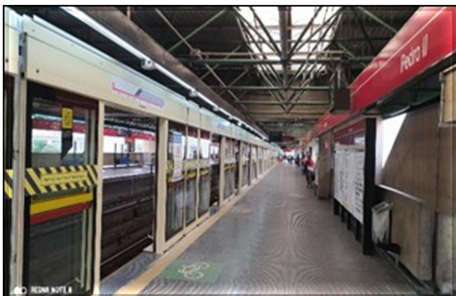
Via 2 – Fachada em instalação..
