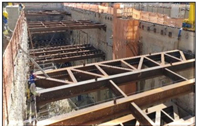
Escavação, tirantes e estroncamento da vala.
