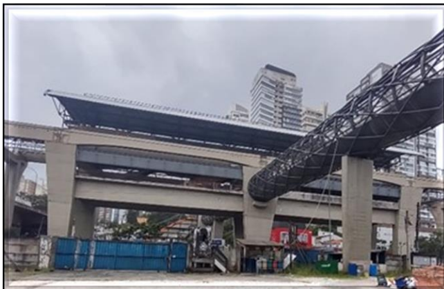
Acesso da Estação/ Obra Civil – Em andamento a contratação direta do escopo remanescente.
