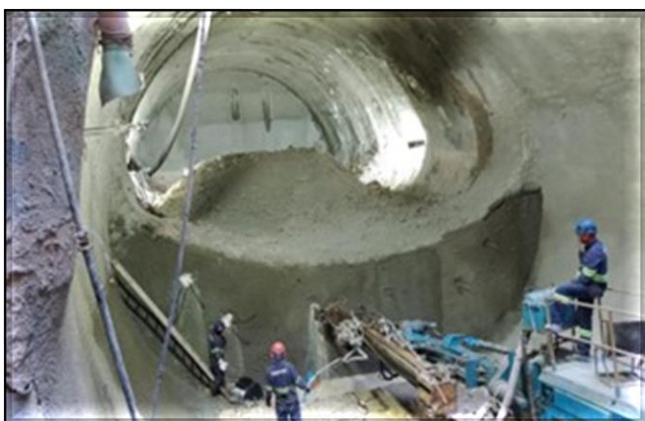
Escavação do túnel de ligação.
