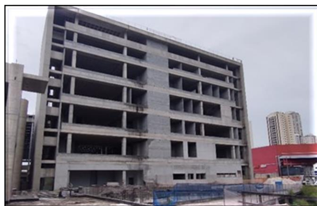
Bloco A/Obra Civil – Em andamento a contratação direta do escopo remanescente.
