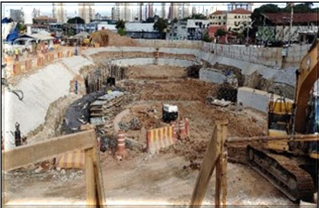
Viga de coroamento do poços do corpo da estação.
