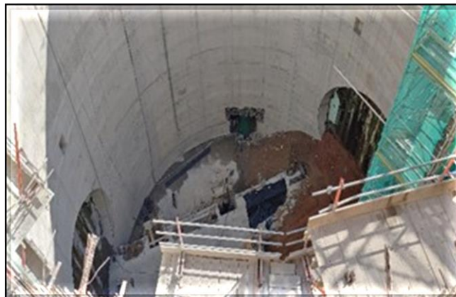
Aterro para escavação do túnel de corpo da estação.
