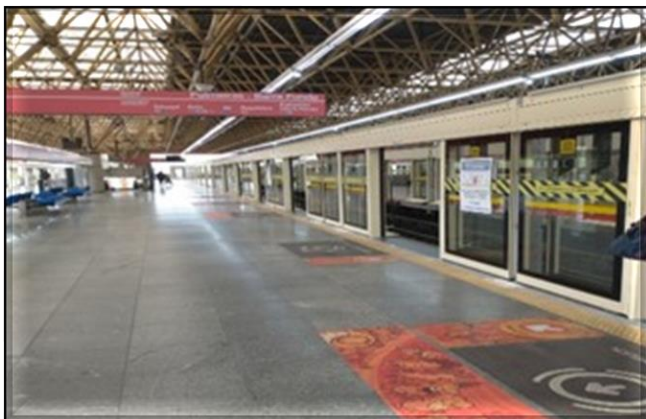
Fachada das portas de plataforma | Instaladas 4/4 fachadas.
