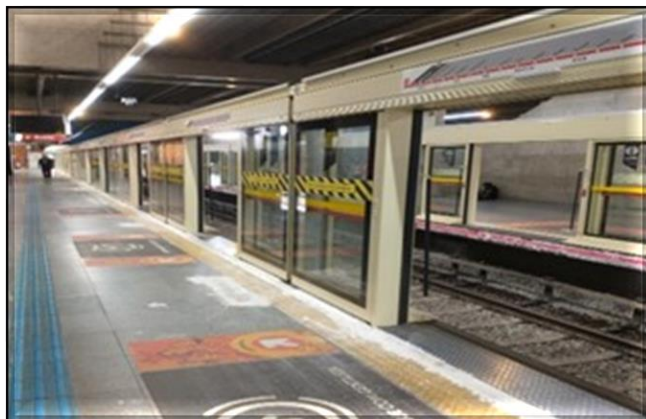
Fachada portas de plataforma | Instaladas 4/4 fachadas.
