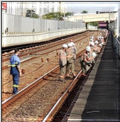
Lançamento de cabos do CBTC
