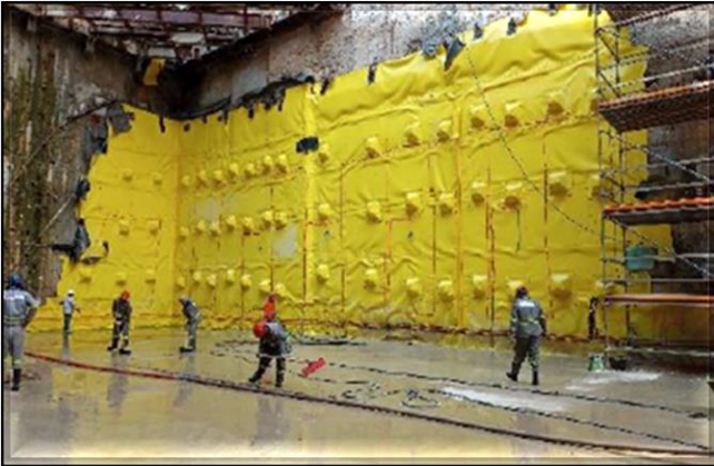
Escavação, impermeabilização e laje de fundo do corpo da estação.
