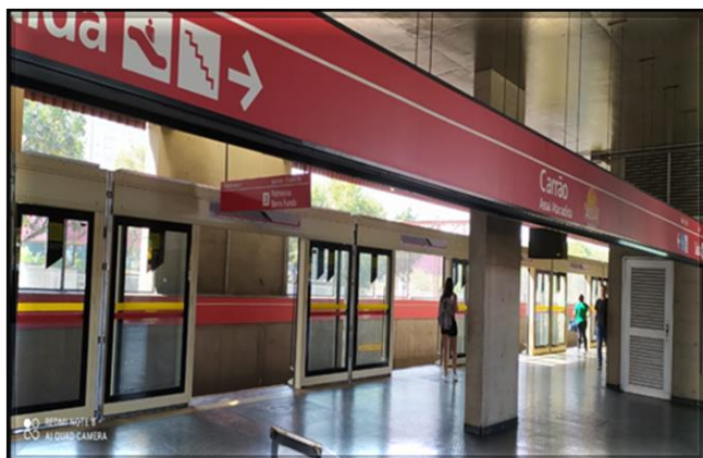
Iniciada a instalação da fachada na via 1
