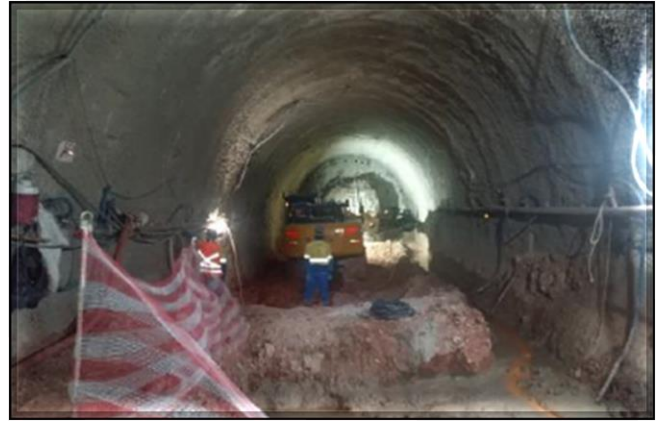
Escavação do túnel.
