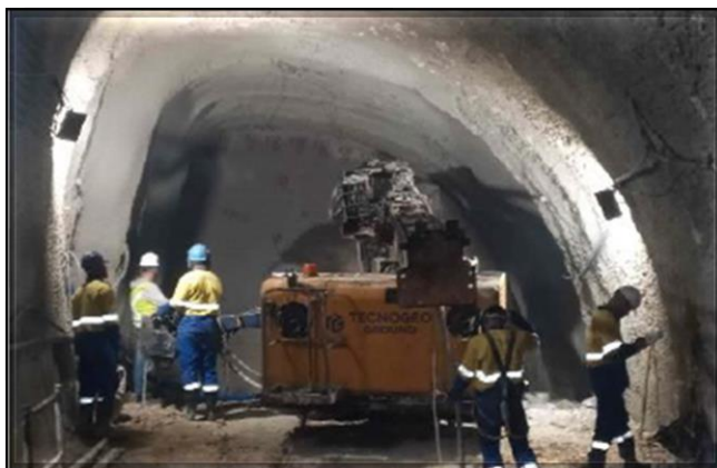
Escavação do túnel.
