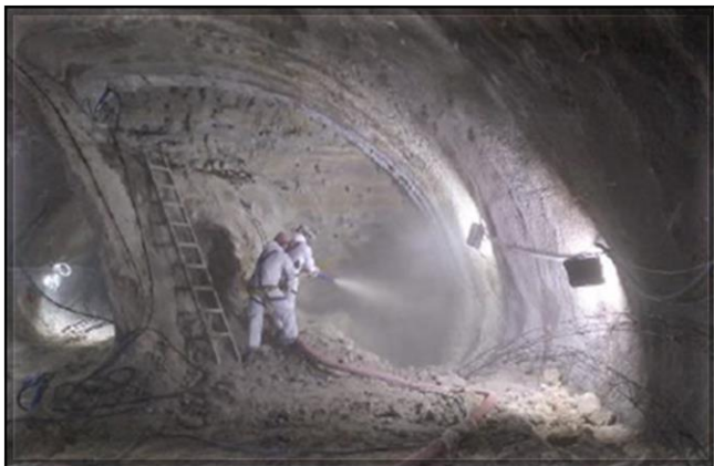
Escavação do túnel de via
