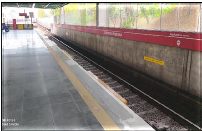
Reforço da borda da plataforma
