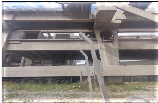
Obra Civil – Assinado o contrato em 31/08/2023 para a execução do escopo remanescente.
