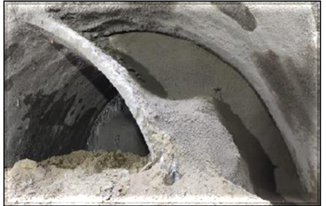
Escavação do túnel de ligação.
