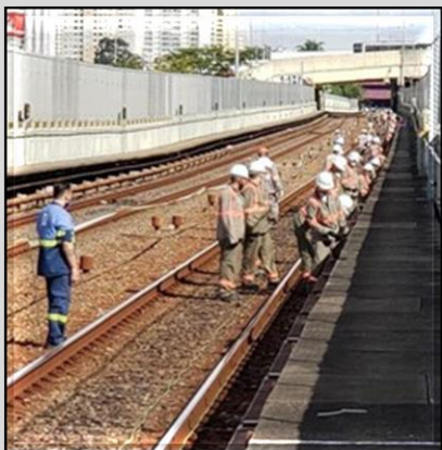
Lançamento de cabos do CBTC
