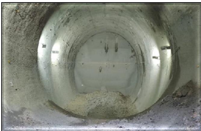
Escavação do túnel de ligação finalizada.
