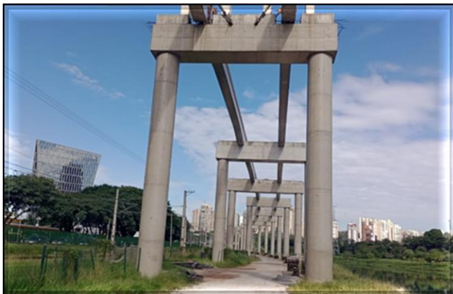
Vias do Monotrilho/ Obra Civil – Assinado o contrato em 31/08/2023 para a execução do escopo remanescente.
