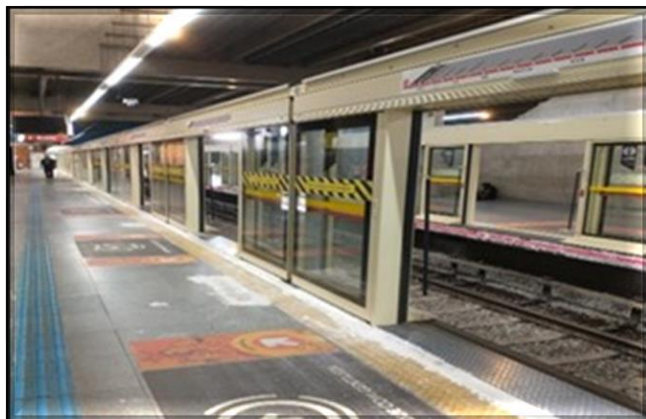
Fachada portas de plataforma | Instaladas 4/4 fachadas.
