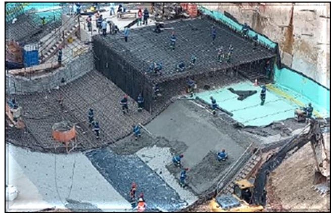
Escavação, tirantes, impermeabilização e laje de fundo.
