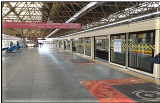
Fachada das portas de plataforma | Instaladas 4/4 fachadas.
