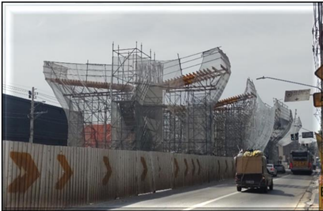
Obra Civil – execução das fundações, pilares e capitéis da via elevada, montagem do cimbramento da laje do Track Switches .
