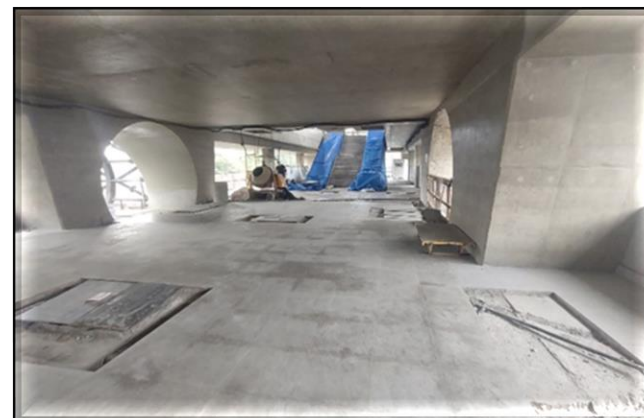
Obra Civil – Assinado o contrato em 31/08/2023 para a execução do escopo remanescente. Sistemas – Posicionamento da escada Rolante no Acesso 1
