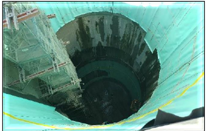
Impermeabilização da parede do poço.
