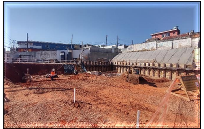
Em andamento a execução das estacas raízes do Acesso Sul e do Edifício Técnico.
