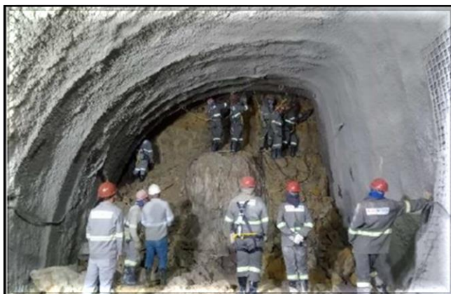
Escavação do túnel.
