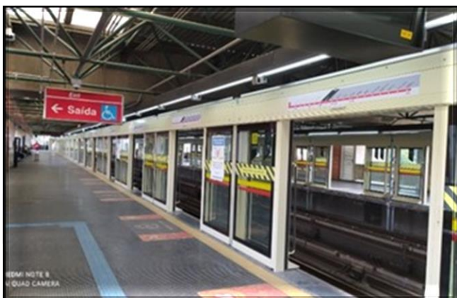
Fachadas das portas de plataforma | Em Instalação 2/2.
