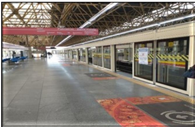
Fachada das portas de plataforma | Instaladas 4/4 fachadas.
