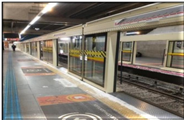
Fachada portas de plataforma | Instaladas 4/4 fachadas.
