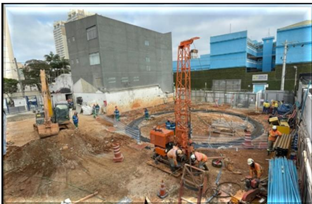
Viga de borda para escavação do poço.
