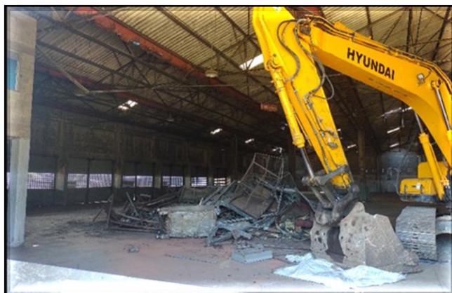
Em andamento a limpeza técnica da área.
