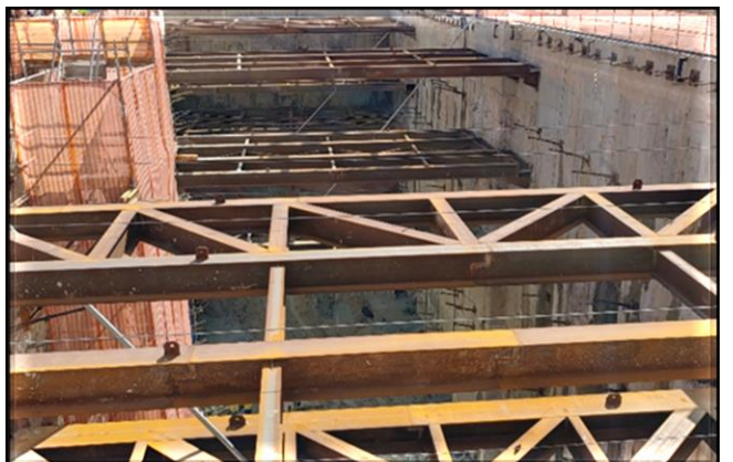
Escavação, tirantes da vala.
