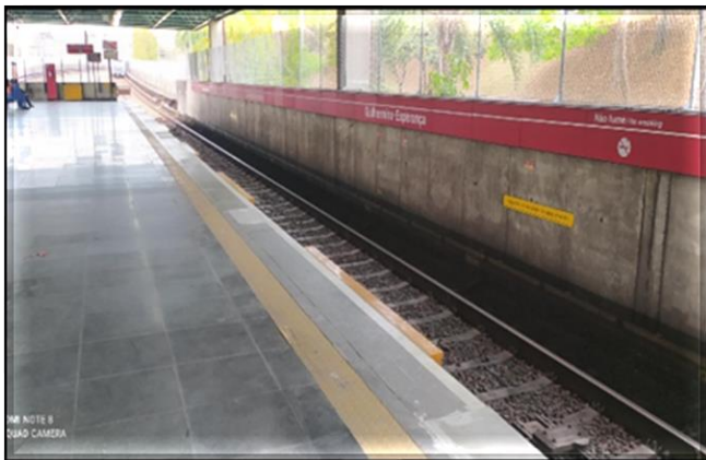
Reforço da borda da plataforma
