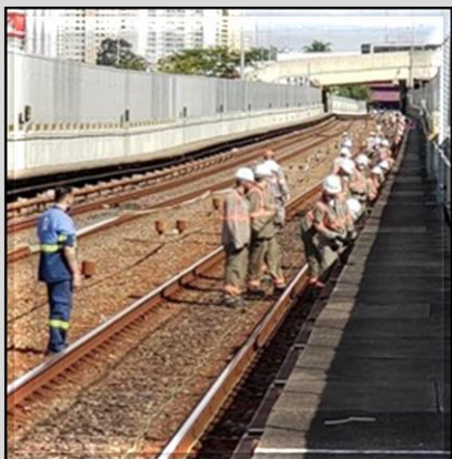
Lançamento de cabos do CBTC
