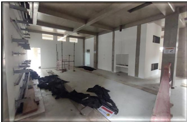
Obra Civil – Em andamento a contratação direta do escopo remanescente.
