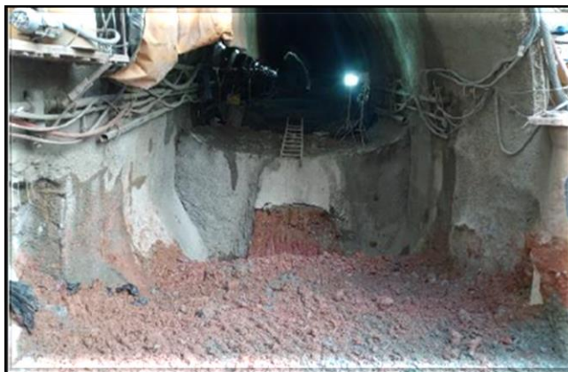
Escavação do túnel.
