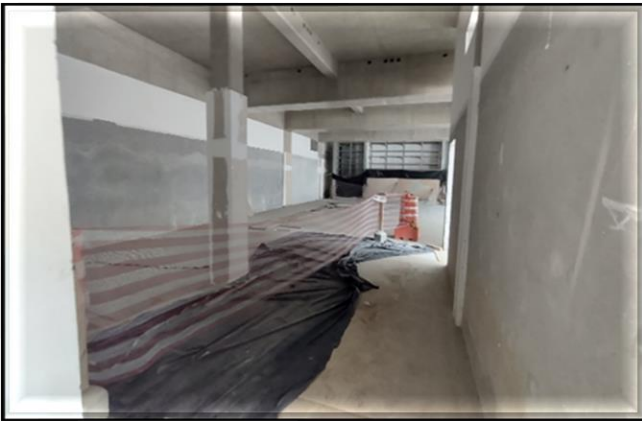
Obra Civil – Em andamento a contratação direta do escopo remanescente.
