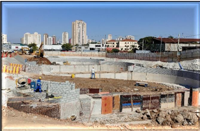
Vigas de travamento e escavação dos poços do corpo da estação.
