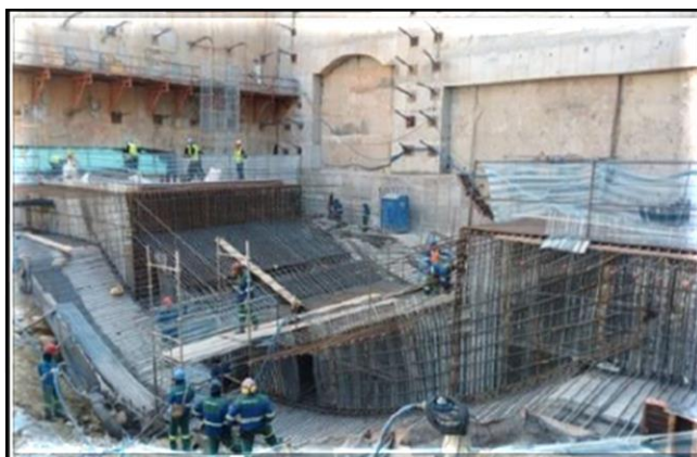
Escavação, tirantes, impermeabilização e laje de fundo.
