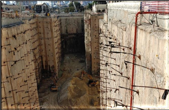
Escavação e tirantes da vala do corpo da estação.
