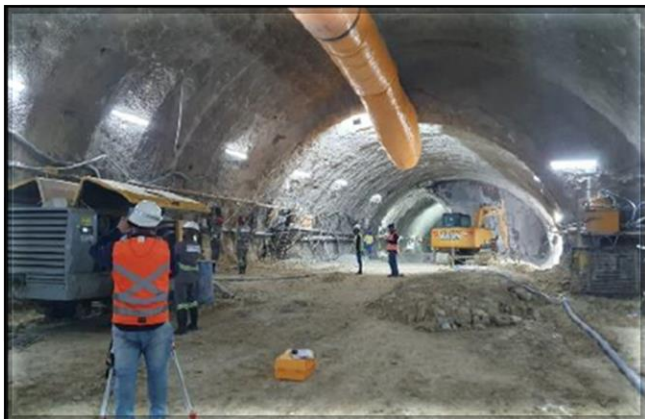
Escavação do túnel de via
