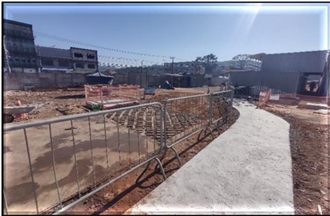
Em andamento instalação do canteiro no Acesso Sul.
