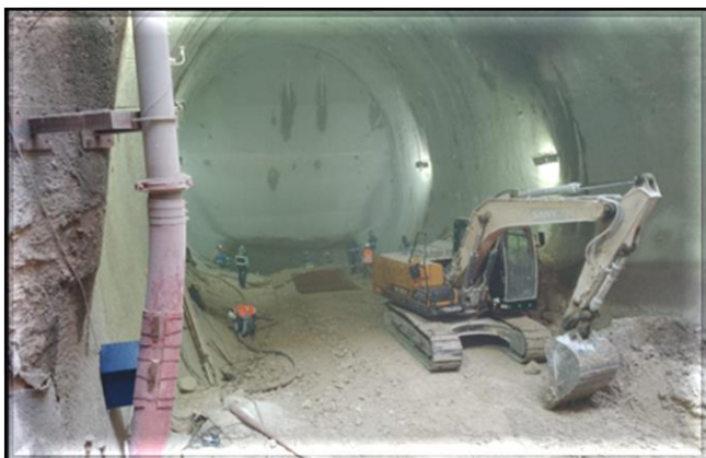
Escavação do túnel de ligação.
