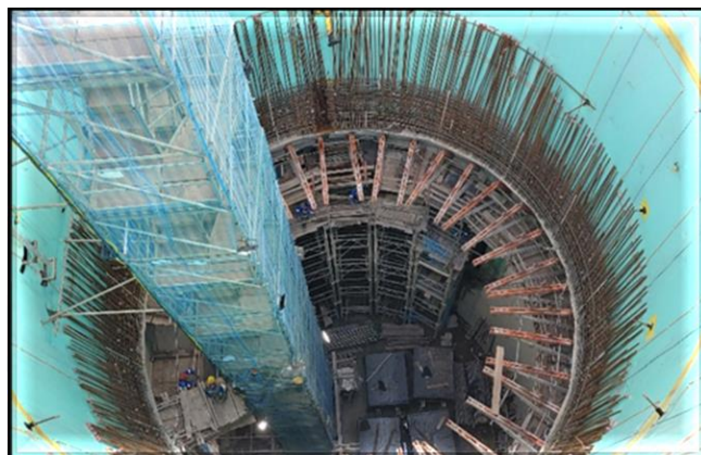
Revestimento secundário do poço.
