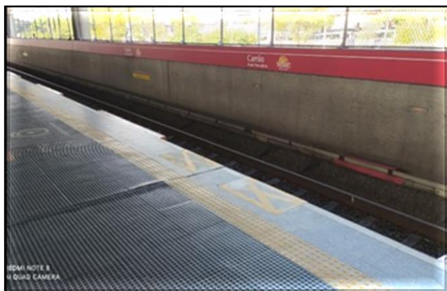
Reforço da borda da plataforma
