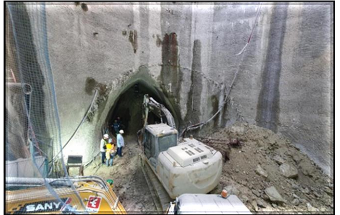
Escavação do túnel de ligação.
