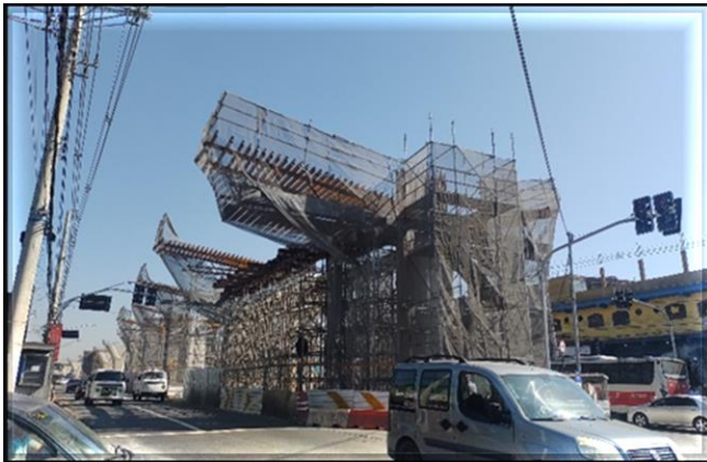
Obra Civil – execução das fundações, pilares e capitéis da via elevada, montagem do cimbramento da laje do Track Switch .
