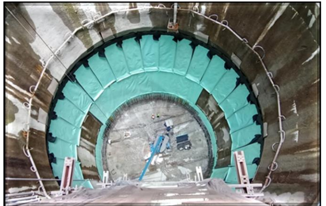
Impermeabilização da parede do poço.
