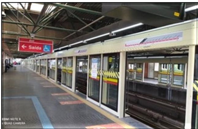
Fachadas das portas de plataforma | Em Instalação 2/2.
