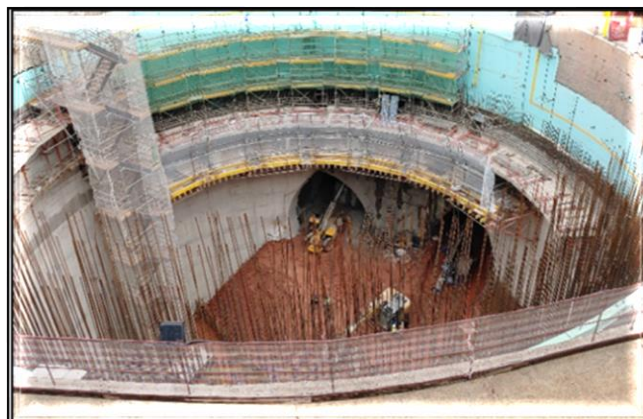
Revestimento secundário do poço e escavação do túnel de via do corpo da estação.
