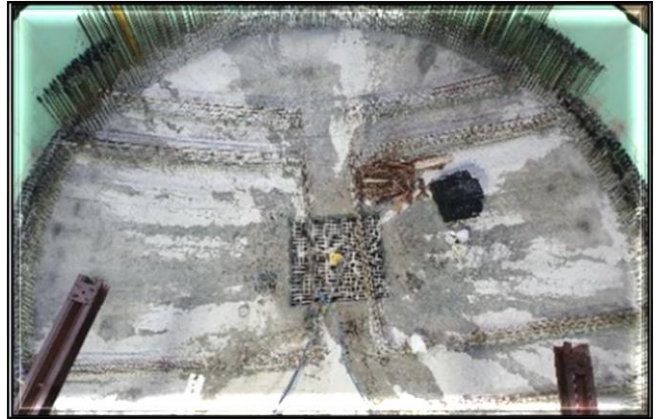
Laje de fundo concretada.
