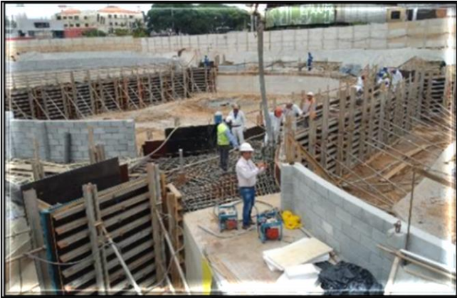
Vigas de travamento do poços do corpo da estação.
