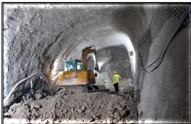
Escavação do túnel.
