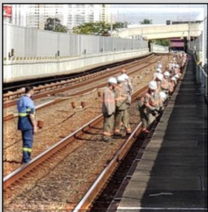
Lançamento de cabos do CBTC
