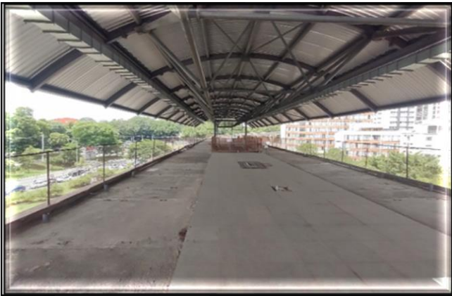
Corpo da Estação/Obra Civil – Em andamento a contratação direta do escopo remanescente.
