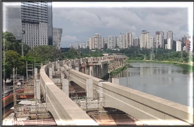
Vias do monotrilho/ Obra Civil – Em andamento a contratação direta do escopo remanescente
