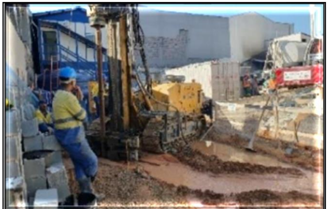
Instalação de PBS para rebaixamento de lençol freático
