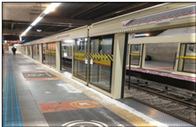
Fachada portas de plataforma | Instaladas 4/4 fachadas.
