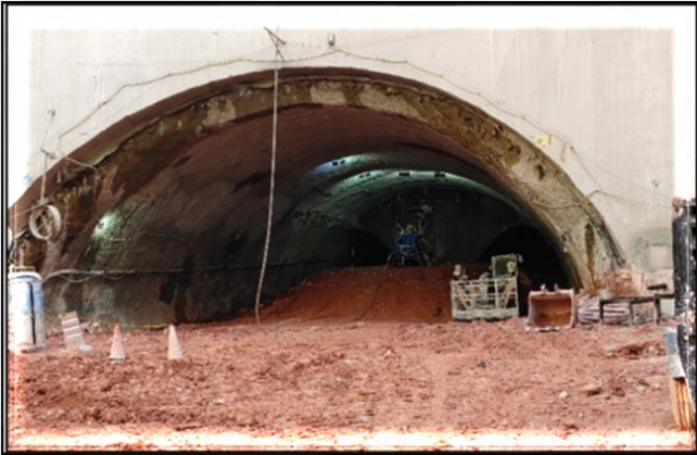
Escavação dos túneis de via do corpo da estação.
