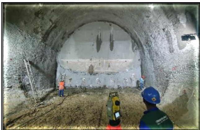
Escavação do túnel de ligação.
