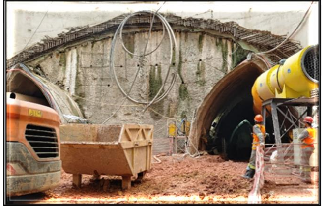
Escavação do túnel.
