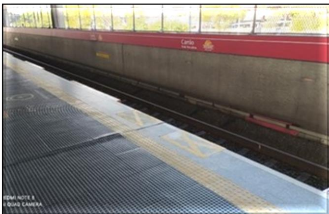
Reforço da borda da plataforma.
