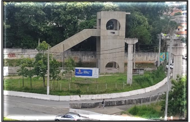
Corpo e Acesso da Estação/ Obra Civil – Em andamento a contratação direta do escopo remanescente.
