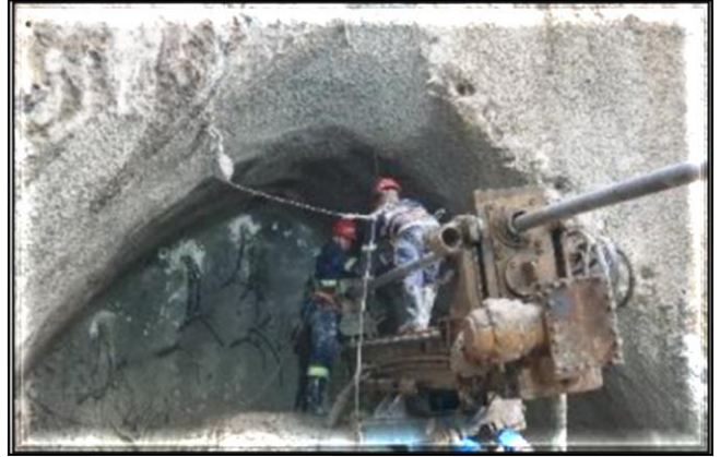
Escavação do túnel de ligação.
