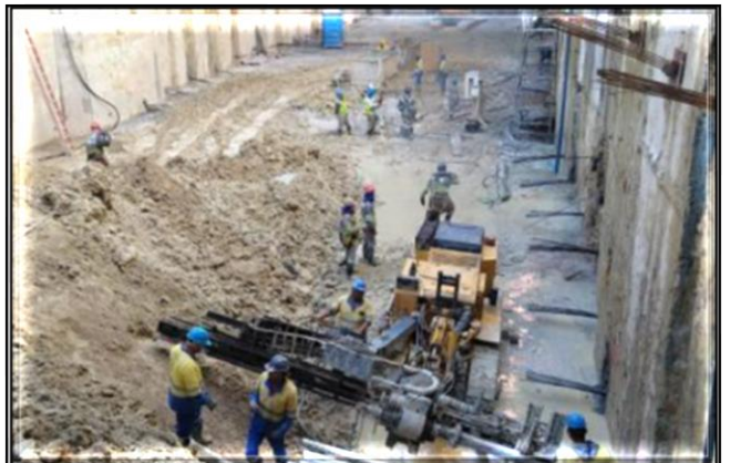
Escavação, tirantes e estroncamento da vala.
