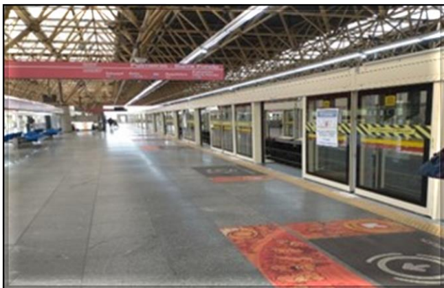
Fachada das portas de plataforma | Instaladas 4/4 fachadas.
