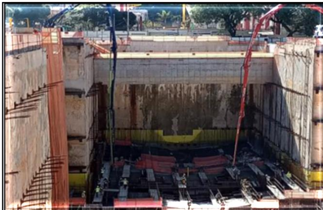
Escavação, tirantes e laje de fundo da vala do corpo da estação.
