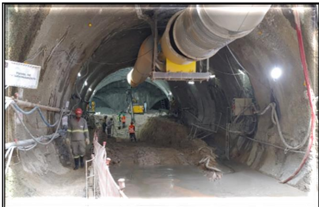
Escavação do túnel de via
