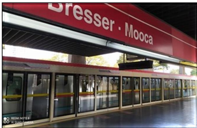
Portas de plataforma em operação.
