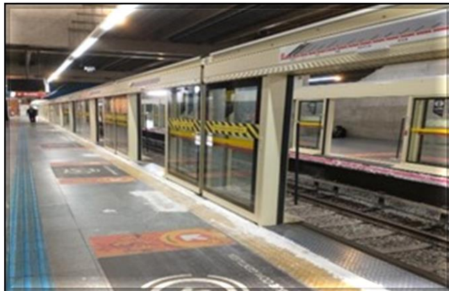
Fachada portas de plataforma | Instaladas 4/4 fachadas.
