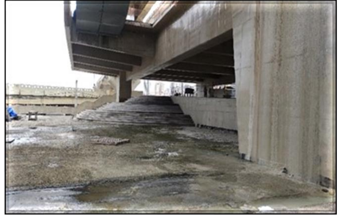
Corpo e Acesso da Estação/ Obra Civil – Obra civil paralisada. 04 Escadas Rolantes posicionadas.
