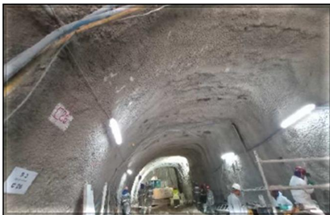
Escavação do túnel de transição.
