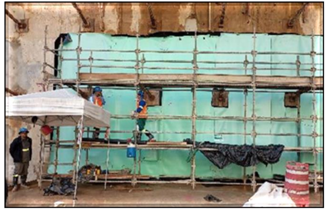
Escavação, tirantes, impermeabilização e lastro para laje de fundo.
