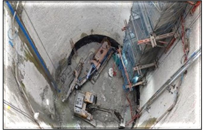
Laje de fundo do poço.
