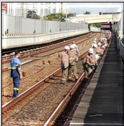
Lançamento de cabos do CBTC
