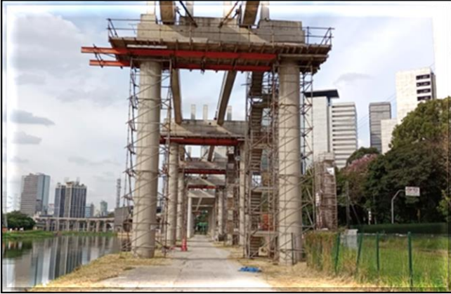
Vias do monotrilho/ Obra Civil – Obra civil paralisada.
