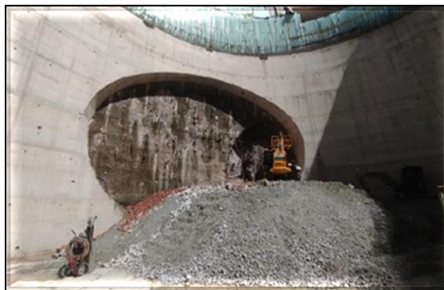
Estrutura de concreto do revestimento secundário do poço do corpo da estação.
