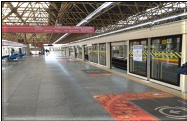
Fachada das portas de plataforma | Instaladas 4/4 fachadas.
