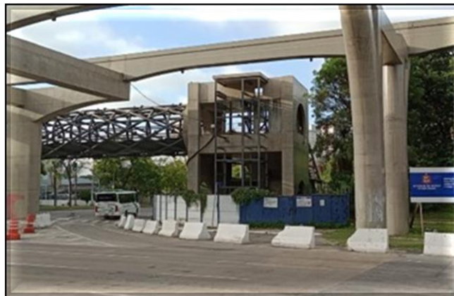
Corpo da Estação/ Obra Civil – Obra civil paralisada. 08 Escadas Rolantes posicionadas.
