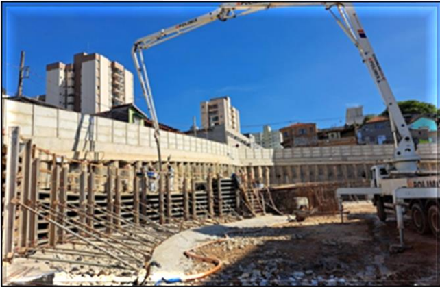
Viga de coroamento.
