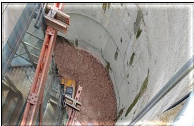
Escavação do túnel de ligação.
