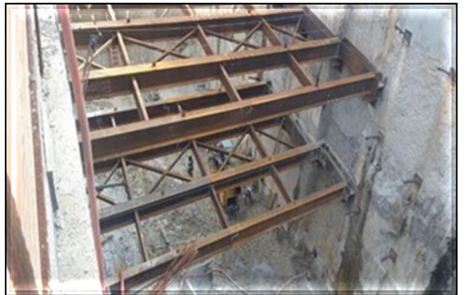
Escavação, tirantes e estroncamento da vala.
