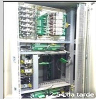
Gabinete de terminação de cabos
