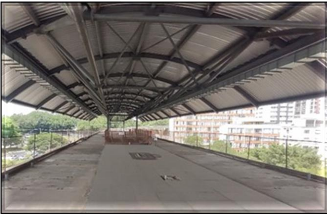
Corpo da Estação/Obra Civil – Obra civil paralisada. 11 Escadas Rolantes posicionadas.
