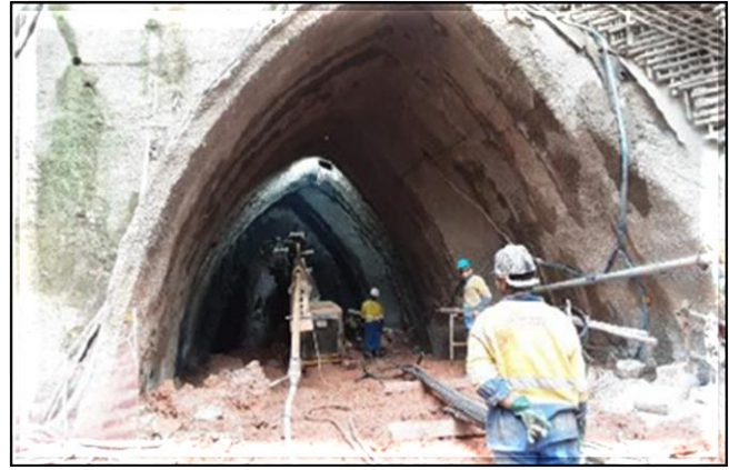
Escavação do túnel de transição.
