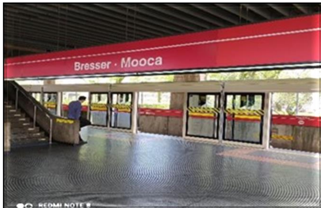
Fachada das portas de plataforma | Instaladas 2/2 fachadas.
