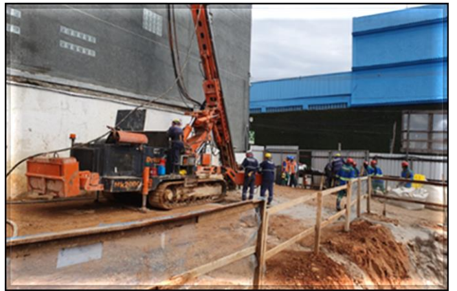
Tratamento de maciço com jet grouting .
