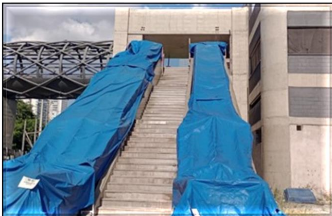
Acesso da Estação/ Obra Civil – Obra civil paralisada. 06 Escadas Rolantes posicionadas.
