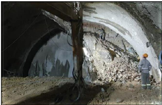
Escavação do túnel de via
