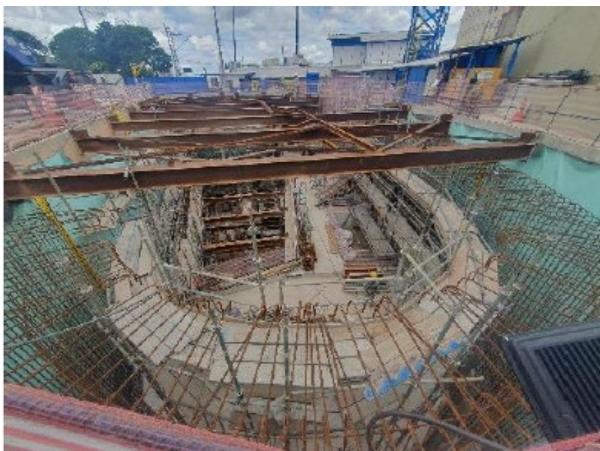
Estrutura de Concreto do acesso secundário da estação Orfanato.
