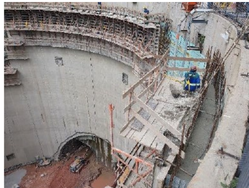
Revestimento Secundário do Corpo da estação Vila Formosa.
