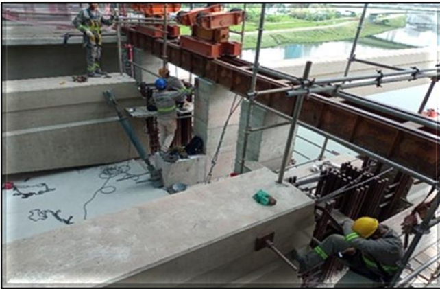
Corpo da Estação/ Obra Civil – Execução da monolitização das vigas-guia.
