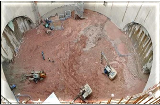
Escavação dos túneis do corpo da estação.
