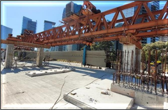
Vias do Monotrilho/Obra Civil – Tratamento do concreto dos pilares do track-switch
