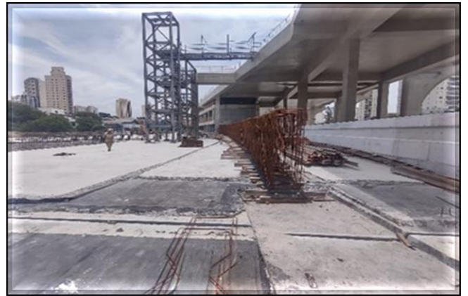
Obra Civil – Execução das vias.
