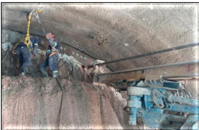
Escavação do túnel de ligação.
