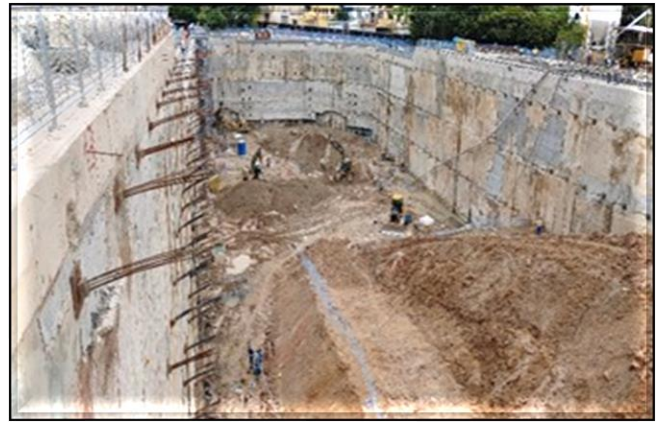
Escavação da vala.
