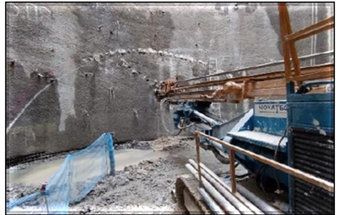
Tratamento para emboque do túnel de ligação.
