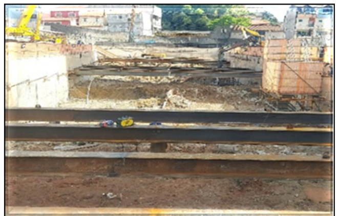
Escavação e tirantes da vala.
