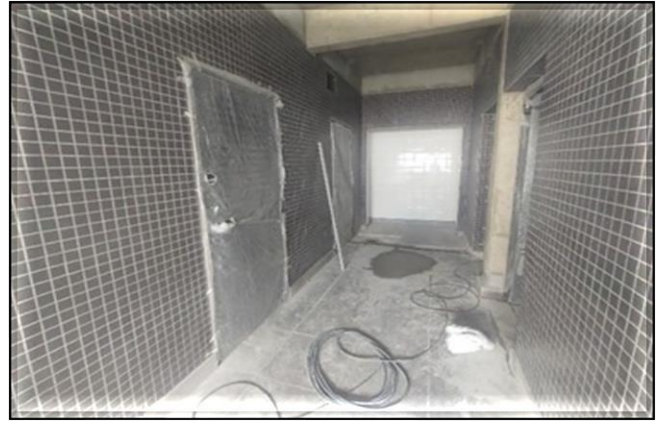
Corpo da Estação/Obra Civil – Execução do acabamento.
