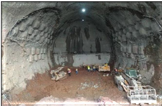
Tratamento para emboque do túnel do corpo da estação.
