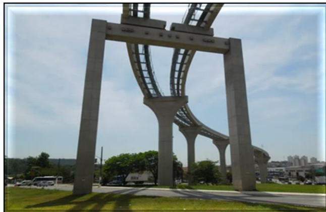
Obra Civil – Serviços concluídos. Sistemas – Em andamento os testes com os trens.
