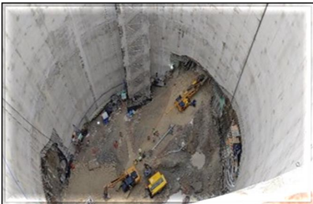
Instrumentação para emboque do túnel de estacionamento.
