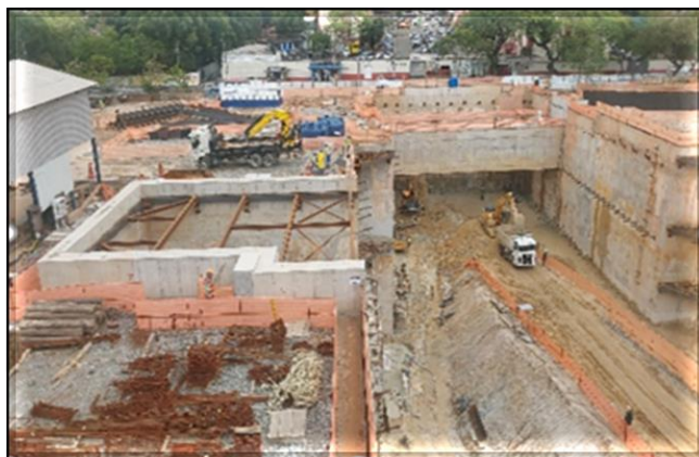
Escavação, tirantes e estroncas da vala do corpo da estação.
