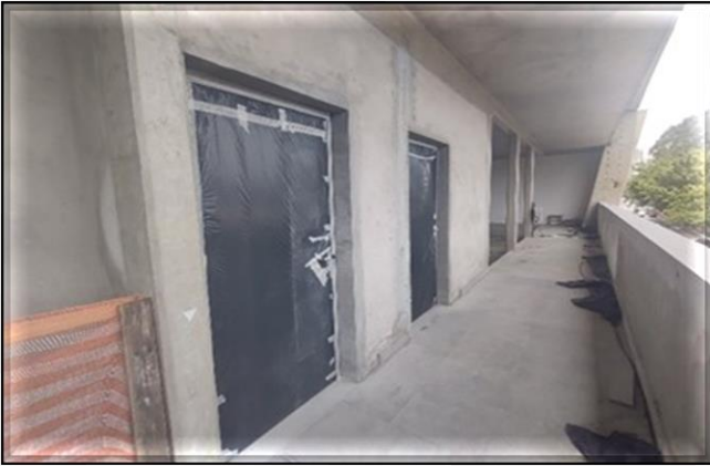
Corpo da Estação/Obra Civil – Execução do acabamento.
