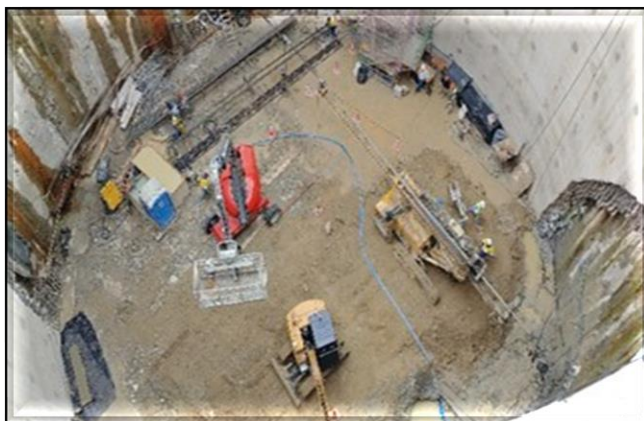
Laje de fundo do Poço concretada.
