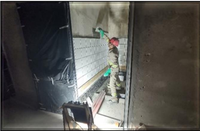
Corpo da Estação/Obra Civil – Execução do revestimento da área operacional.
