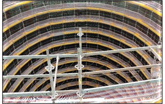
Laje de fundo do poço concretada. Parede do revestimento secundário do poço.
