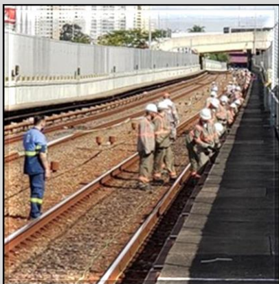
Lançamento de cabos do CBTC
