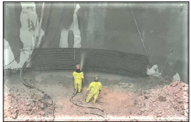
Escavação do poço.
