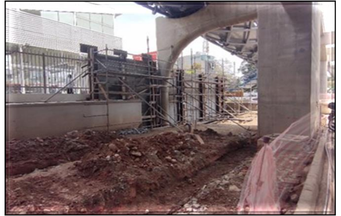
Corpo da Estação/Obra Civil – Execução das pastilhas de revestimento.
