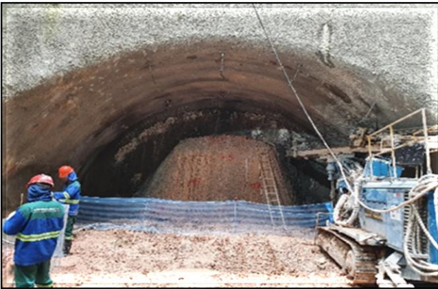
Escavação do túnel de ligação.
