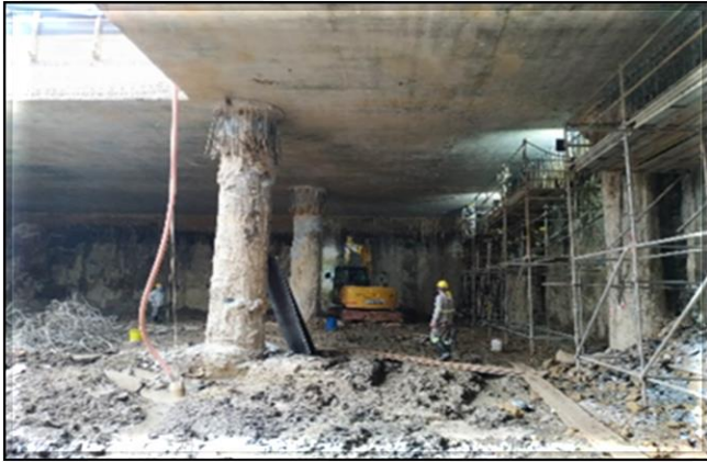
Estruturas de concreto e escavação do corpo da estação.
