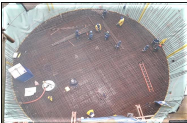
Armação da laje de fundo do poço.
