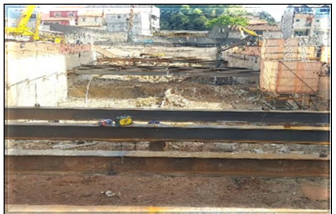
Escavação e tirantes da vala.
