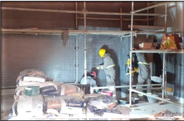
Corpo da Estação/Obra Civil – Revestimento do bicicletário.
