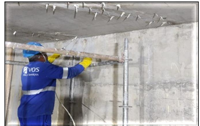
Corpo da Estação/Obra Civil-Interligação – Tratamento do concreto
