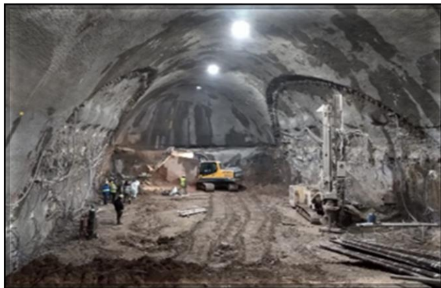
Tratamento para emboque do túnel do corpo da estação.
