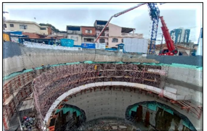
Parede do revestimento secundário do poço.
