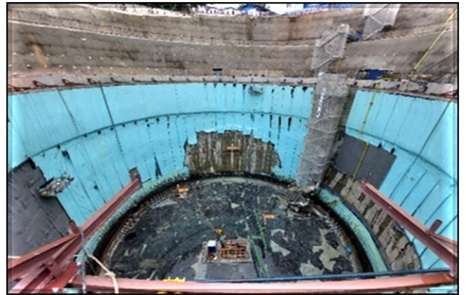
Impermeabilização do poço do corpo da estação.
