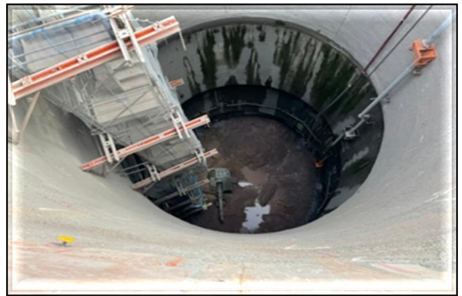
Escavação do poço.
