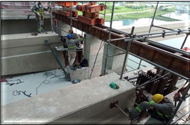
Corpo da Estação/ Obra Civil – Execução da protensão das vigas-guia.
