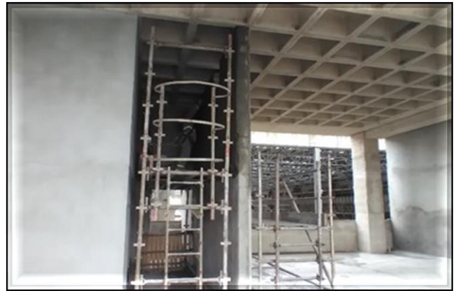
Obra Civil – Execução do acabamento do Bloco B.
