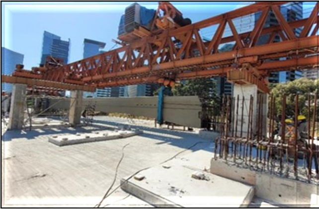
Vias do Monotrilho/Obra Civil – Lançamento das vigas-guia no track-switch
