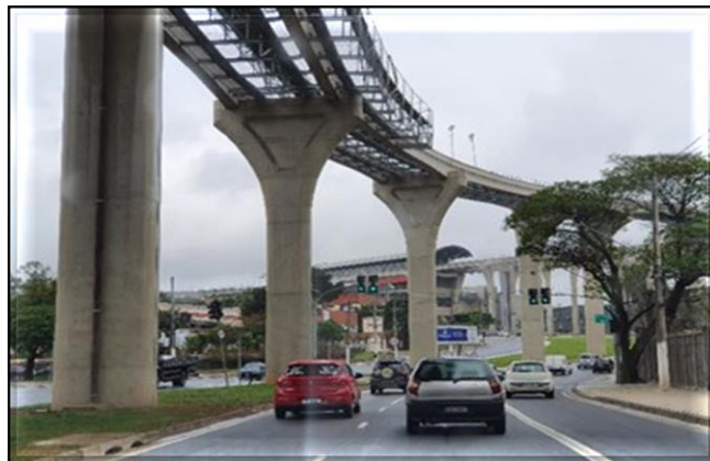
Obra Civil – Serviços concluídos. Sistemas – Em andamento os testes com os trens.
