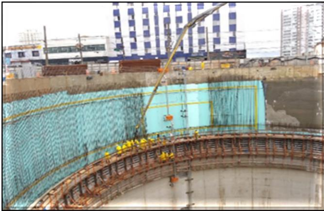
Parede do revestimento secundário do poço do corpo da estação.
