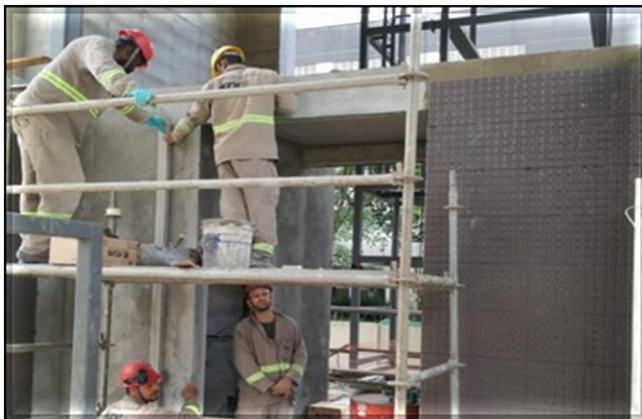
Corpo da Estação- Acesso A/ Obra Civil – Acabamento dos sanitários.
