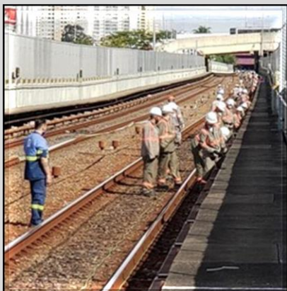
Lançamento de cabos do CBTC
