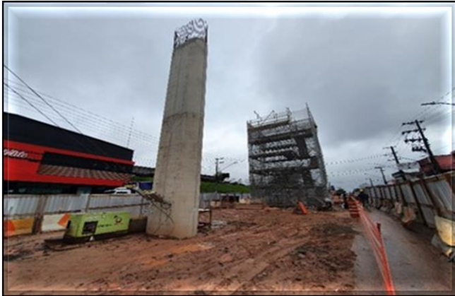
Obra Civil – Execução das fundações e pilares da via elevada.
