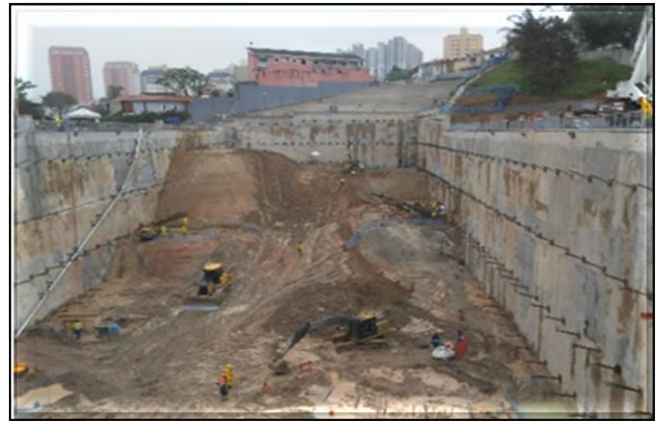
Escavação da vala.
