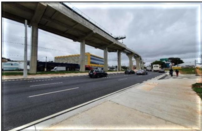
Obra Civil – Viário entregue em 19/10/2022. Sistemas – Em andamento os testes com os trens.
