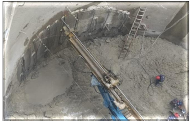
Tratamento para emboque do túnel de ligação.
