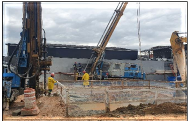
Tratamento de maciço com jet grouting .
