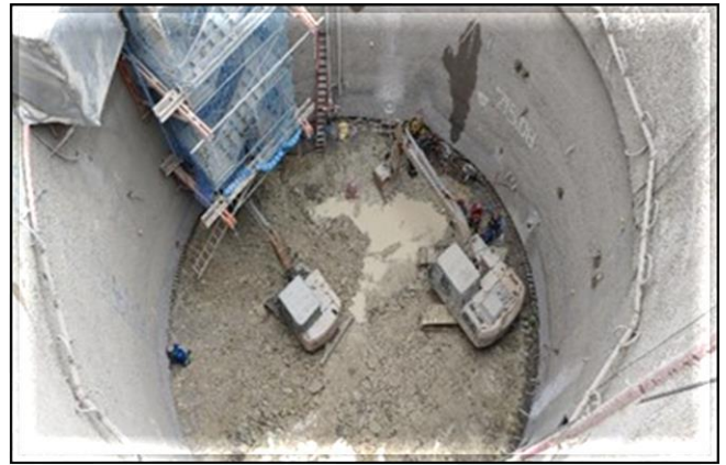
Escavação do poço.
