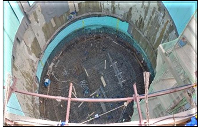
Laje de fundo do poço do corpo da estação.
