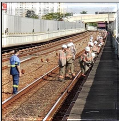
Lançamento de cabos do CBTC
