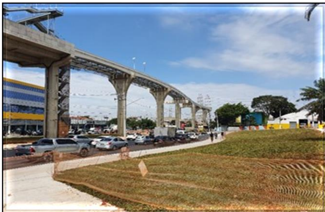
Obra Civil – Viário parcialmente liberado. Sistemas – Em andamento os testes com os trens.
