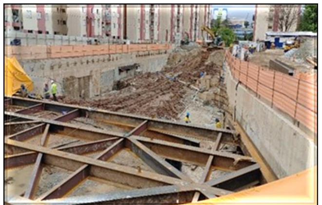
Escavação e estronamento da vala.
