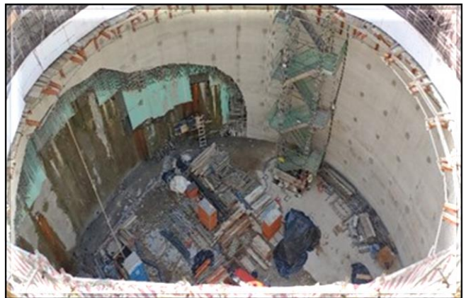
Parede do revestimento secundário do poço.
