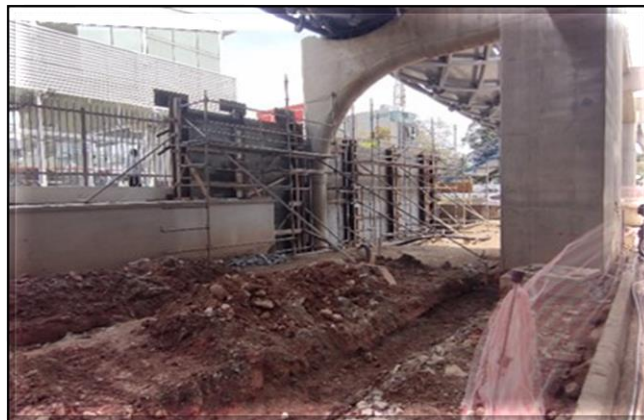
Corpo da Estação/Obra Civil – Execução banco de dutos e muro de divisa.
