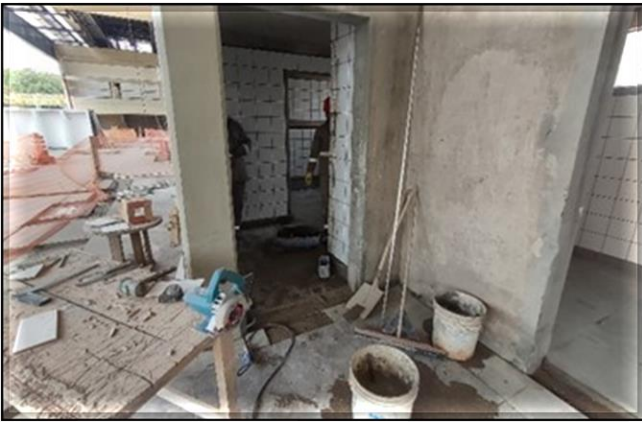
Corpo da Estação/Obra Civil – Revestimento dos sanitários públicos.
