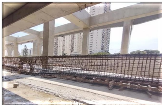
Obra Civil – Execução da armação das vigas-guia.
