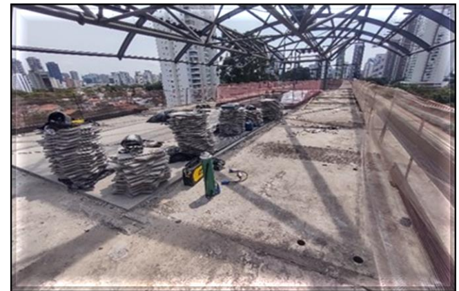
Corpo da Estação/Obra Civil – Instalação dos suportes da cobertura.
