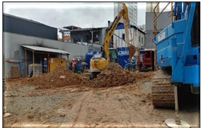
Regularização do terreno.
