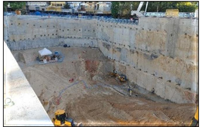
Escavação da vala.
