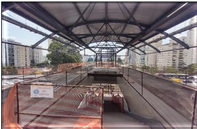
Corpo da Estação/Obra Civil – Instalação das telhas da cobertura da plataforma.
