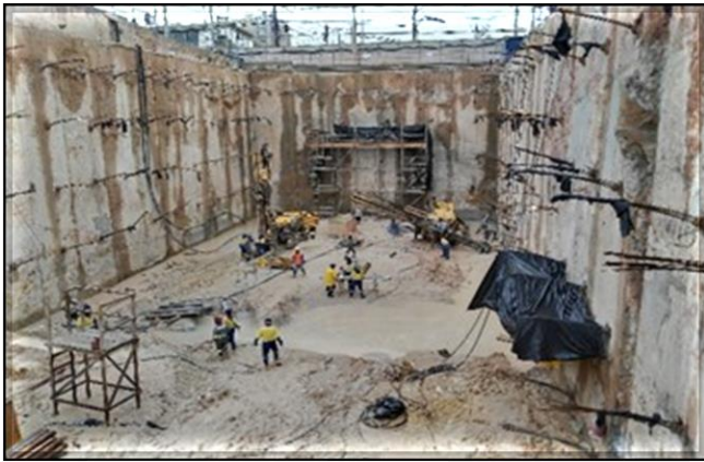
Escavação e execução de tirantes da vala do corpo da estação.
