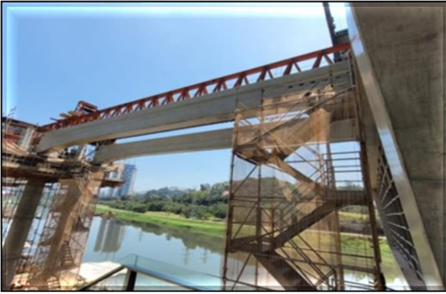
Vias do Monotrilho/Obra civil – Lançamento das vigas-guia.
