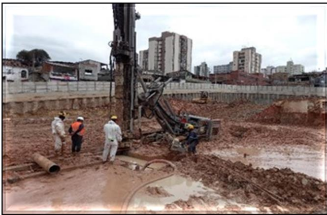
Parede de diafragma dos poços do corpo da estação
