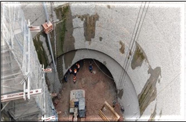
Escavação do túnel de ligação.
