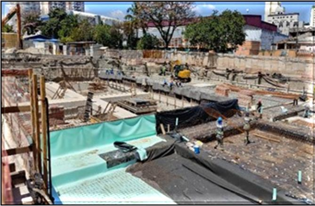
Estruturas da laje de cobertura do corpo da estação.
