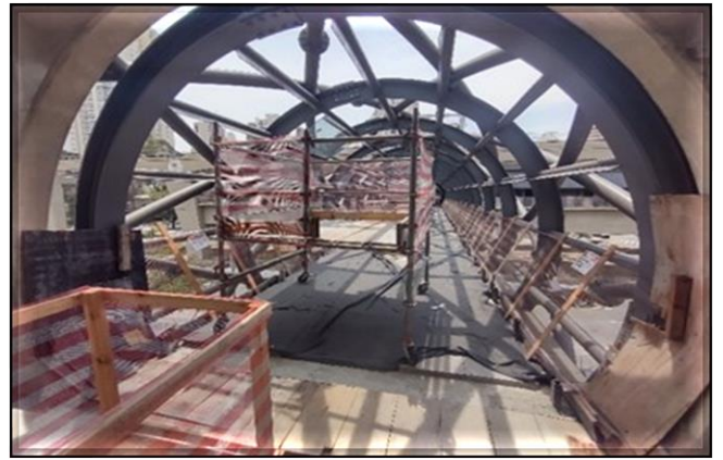
Corpo da Estação/Obra Civil – Executada a furação para instalação dos suportes dos vidros.
