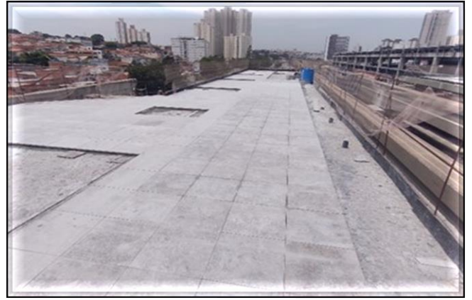
Corpo da Estação/Obra civil – Execução do piso de granito na plataforma.
