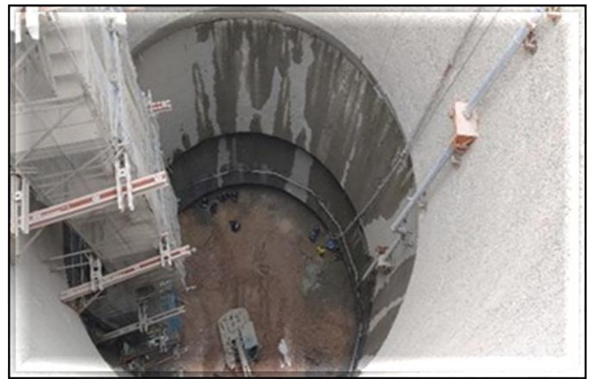
Escavação do poço.
