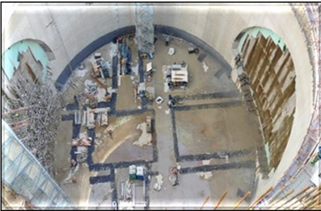
Parede do revestimento secundário do poço do corpo da estação.
