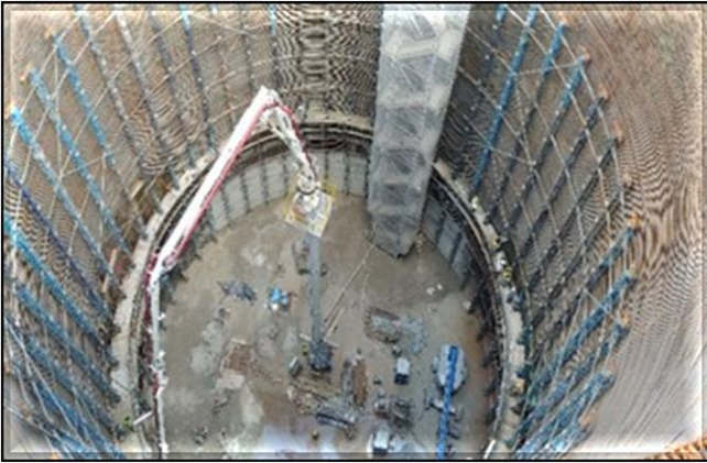
Parede do revestimento secundário do poço.
