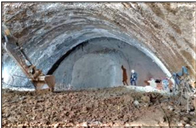
Escavação do túnel de ligação do corpo da estação.
