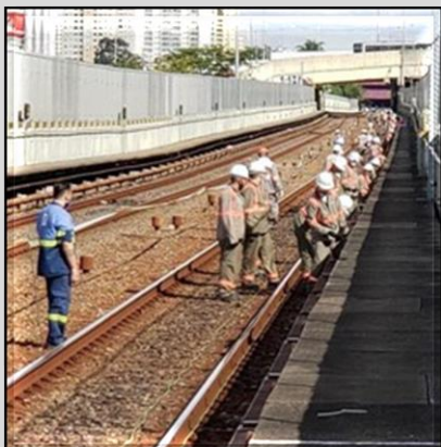
Lançamento de cabos do CBTC
