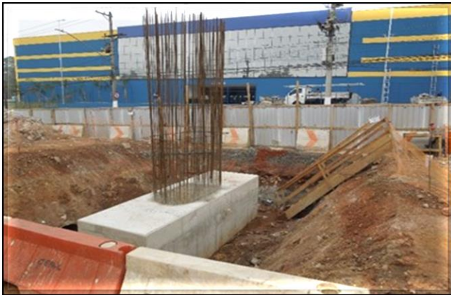
Obra Civil – Execução das fundações da via elevada.
