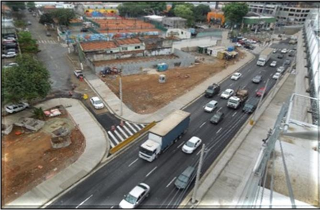
Obra Civil – Viário parcialmente liberado. Sistemas – Montagem e teste dos sistemas de sinalização
