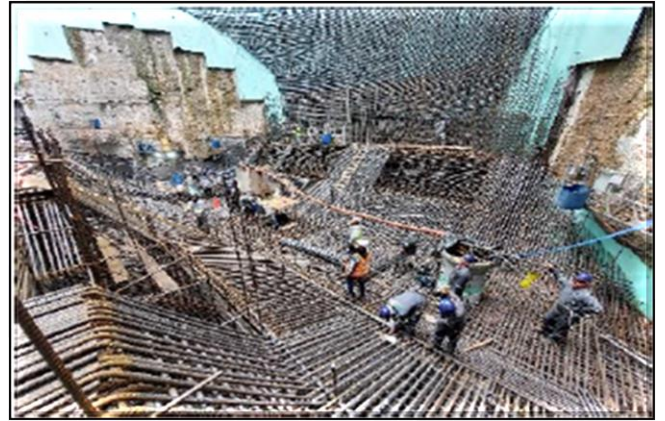
Laje de fundo e parede do revestimento secundário do poço.
