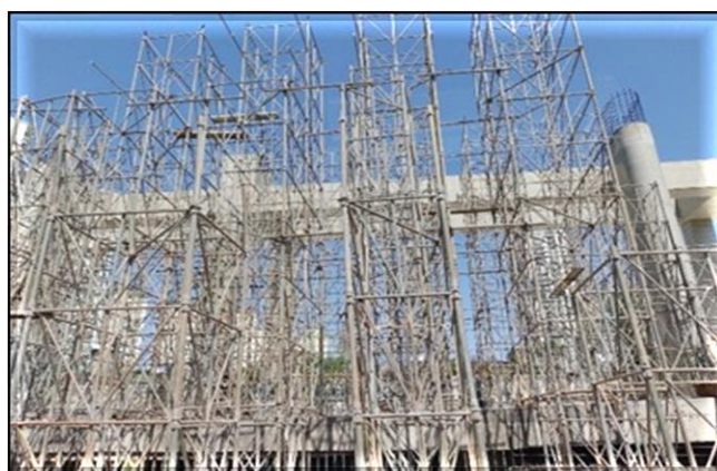
Obra Civil – Montagem do cimbramento para execução do deck-switch do equipamento de mudança de via.
