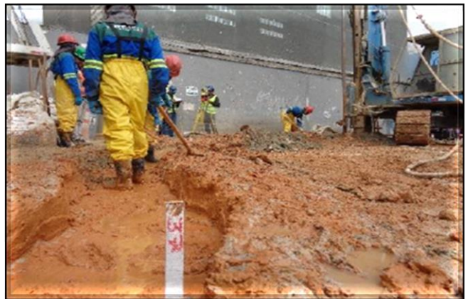
Execução de jet grouting (injeção de nata de cimento no solo).
