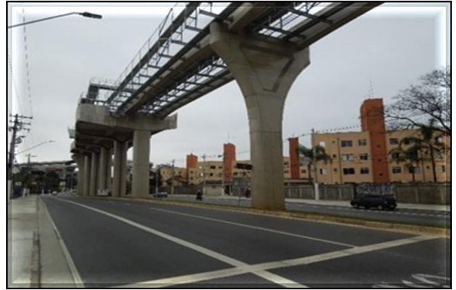
Obra Civil – Finalização do paisagismo. Sistemas – Em andamento os testes com os trens.
