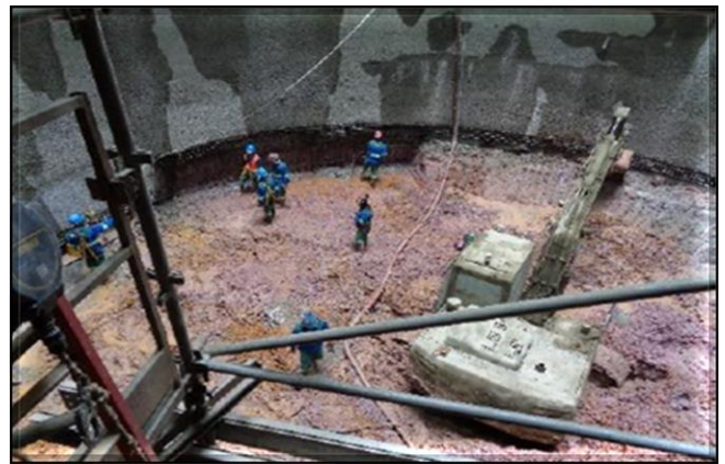
Escavação do poço.
