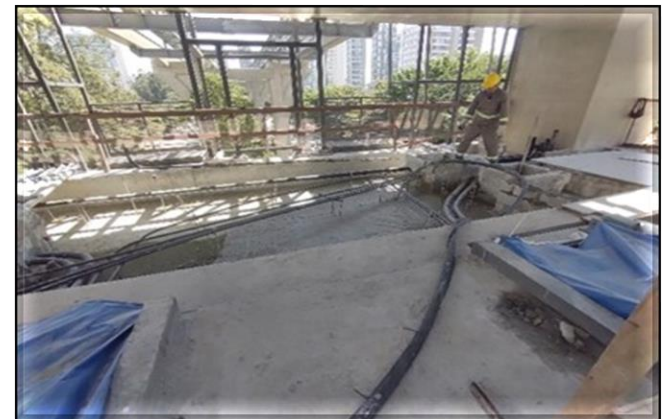
Corpo da Estação/ Obra Civil – Concretagem do mezanino.
