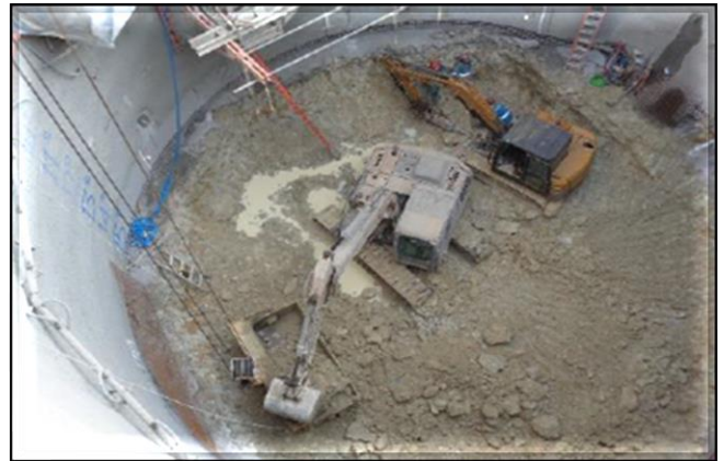
Escavação do poço.
