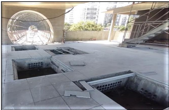
Corpo da Estação/ Obra Civil – Execução do acabamento
