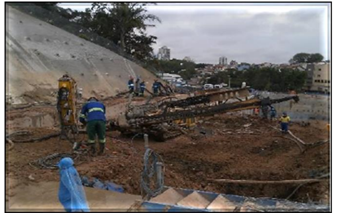
Execução de tirantes da vala.
