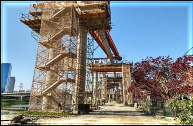
Vias do Monotrilho/Obra civil – Lançamento das vigas-guia.
