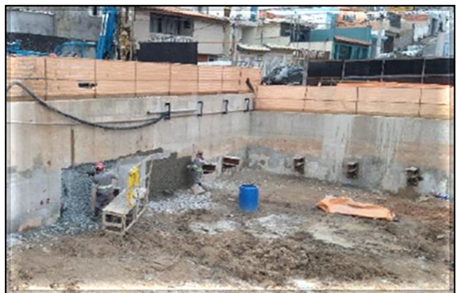
Escavação e estroncamento da vala.
