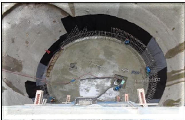
Laje de fundo do poço concretada.
