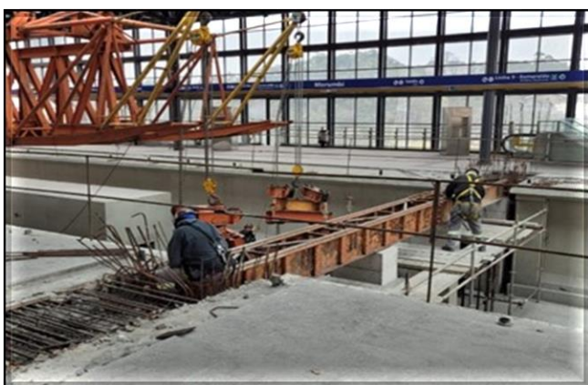
Corpo da Estação/ Obra Civil – Execução dos apoios das vigas-guia.
