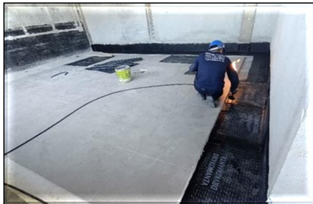
Edifício Técnico e Operacional/Obra Civil – Execução da impermeabilização dos vestiários.
