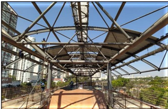
Corpo da Estação/ Obra Civil – Instalação das telhas da cobertura da plataforma.
