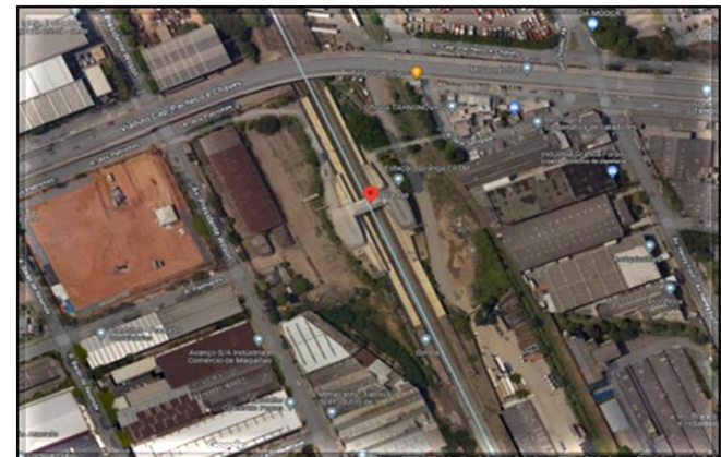
Processo licitatório para contratação da obra civil e implantação de sistemas em fase de valoração.
