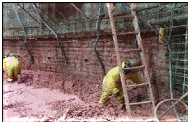
Escavação do poço.
