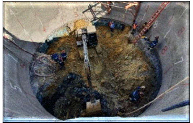
Escavação do poço.
