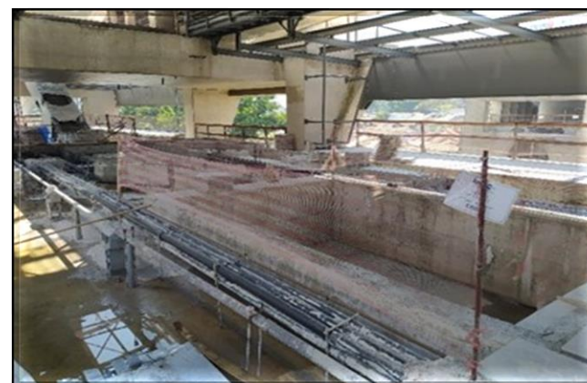
Corpo da Estação/Obra Civil – execução banco de dutos.
