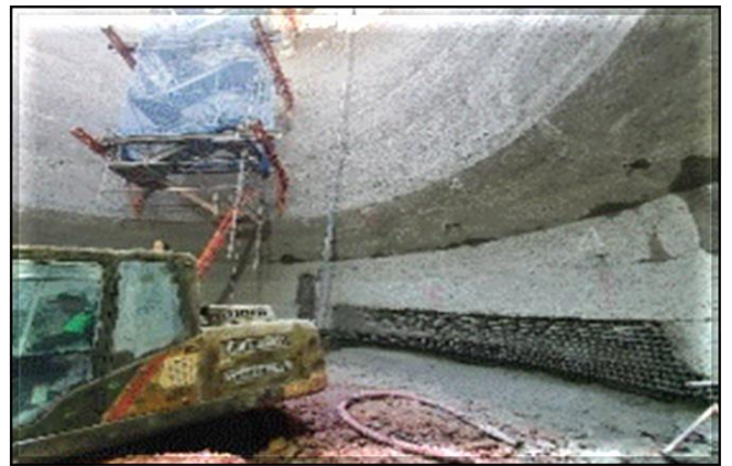
Escavação do poço.
