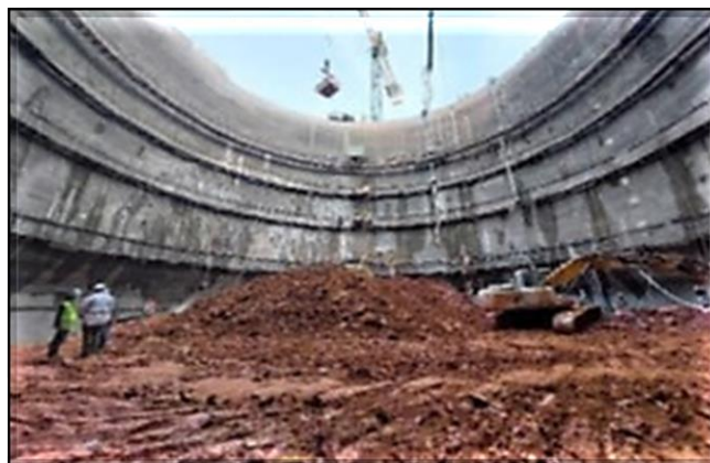
Escavação do poço do corpo da estação.
