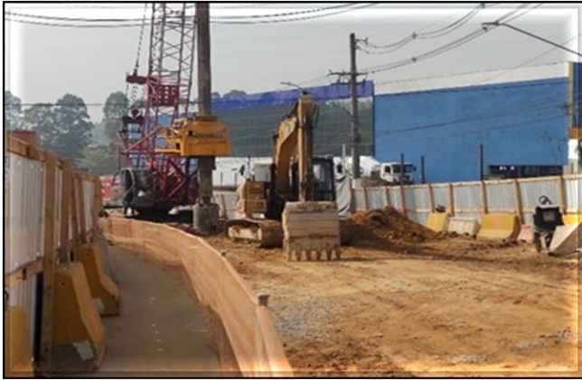
Obra Civil – Execução dos estações para fundação da via elevada.
