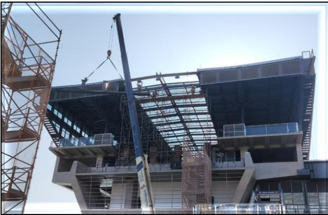
Corpo da Estação – Desmonte da cobertura para lançamento das vigas-guia
