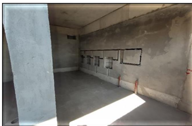
Edifício Técnico/Obra Civil – Execução da hidráulica.
