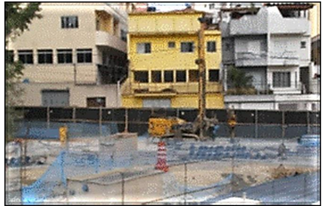
Execução de tirantes da vala.
