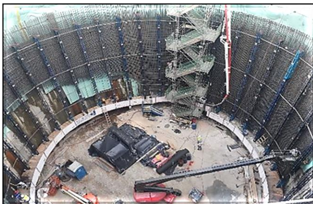
Armação e revestimento secundário do poço.
