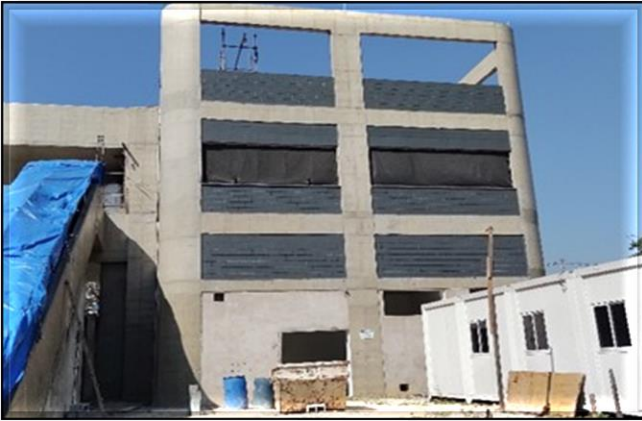
Edifício Técnico e Operacional/Obra Civil – Executada a pintura e tratamento da fachada.
