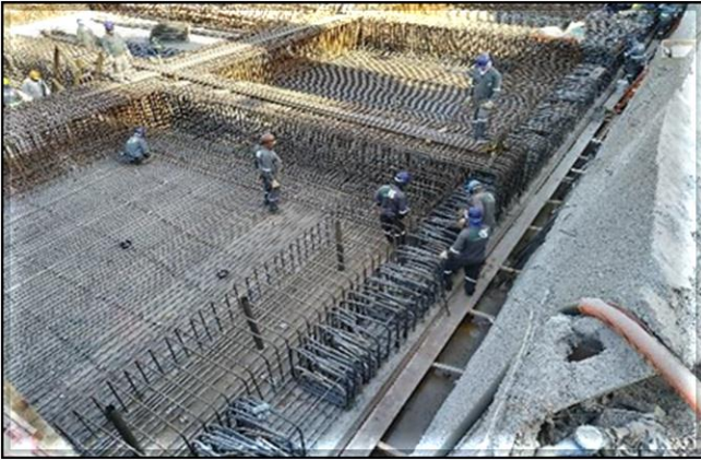
Vigas da laje de cobertura do corpo da estação.
