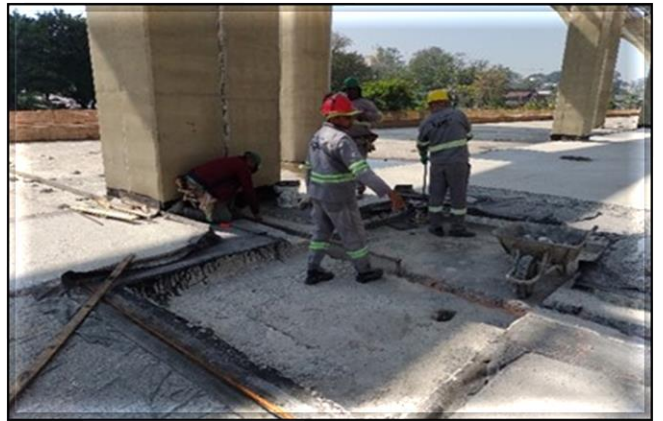
Obra Civil – Tratamento da impermeabilização nos pontos de dilatação.
