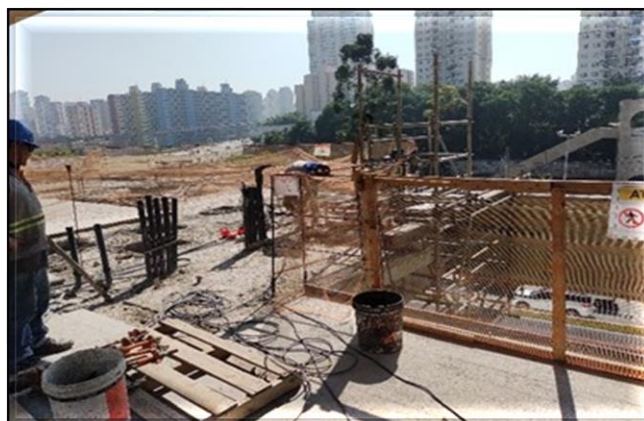
Corpo da Estação/Obra Civil – Regularização da caixa da escada do mezanino.
