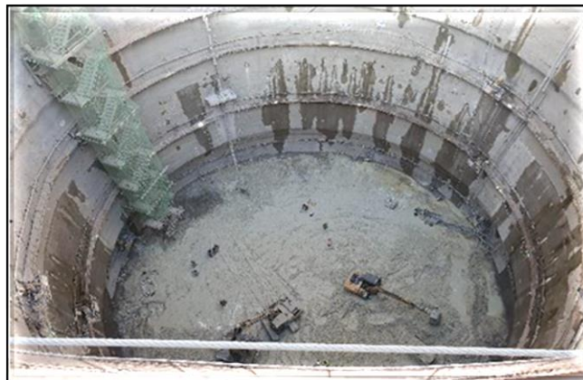
Escavação do poço do corpo da estação.
