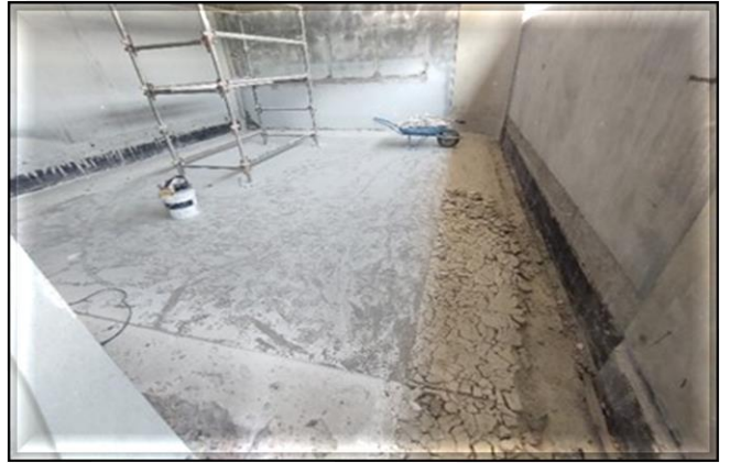
Edifício Técnico e Operacional/Obra Civil – Recuperação da impermeabilização dos vestiários.
