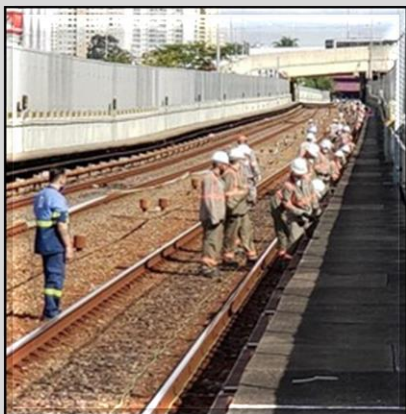
Lançamento de cabos do CBTC
