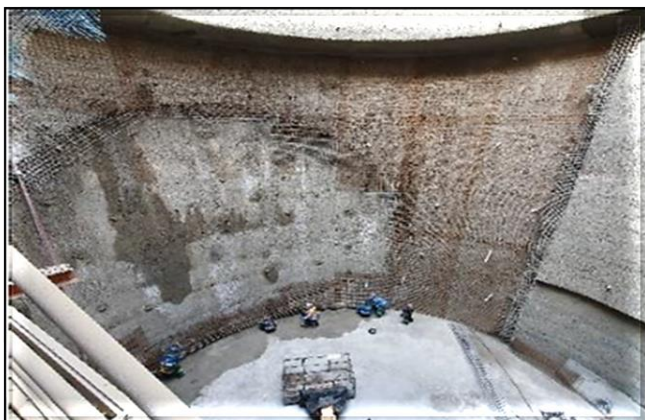
Escavação do poço.
