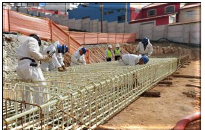
Parede diafragma da vala.
