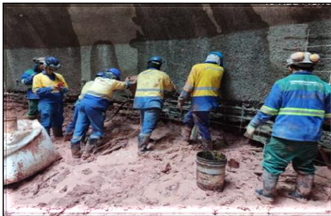
Escavação do poço.
