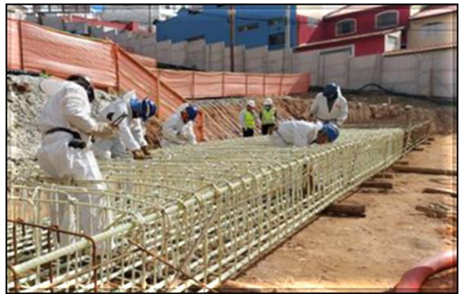
Parede diafragma da vala
