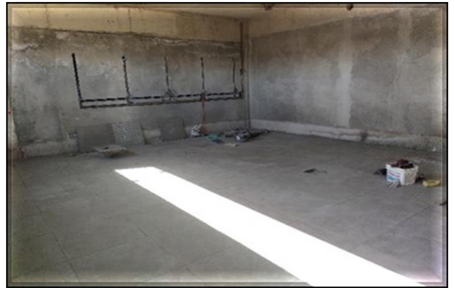
Edifício Técnico/Obra civil – Execução do piso porcelanato nos vestiários.
