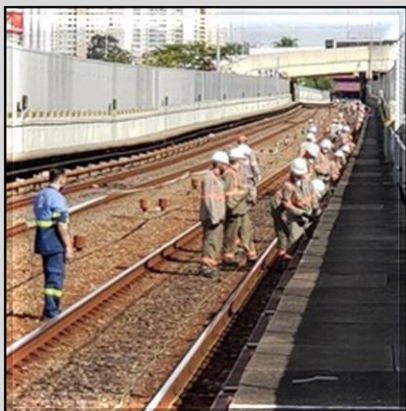
Lançamento de cabos do CBTC
