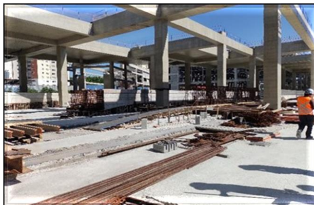
Obra Civil – Execução das vigas guia.
