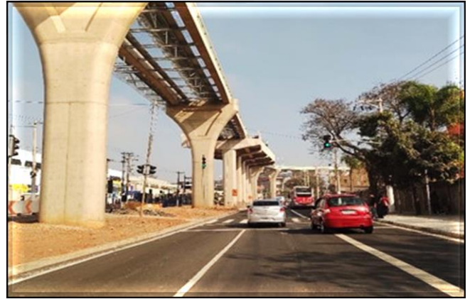
Obra Civil – Recomposição do viário. Sistemas – Montagem dos sistemas de rota de fuga e iluminação.
