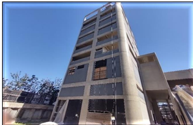
Edifício Técnico e Operacional/Obra Civil – Montagem de equipamento para pintura e tratamento da fachada.
