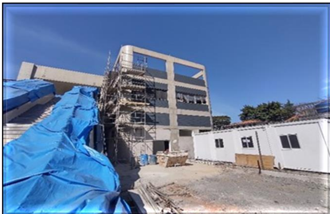
Edifício Técnico e Operacional/Obra Civil – Pintura e tratamento da fachada.
