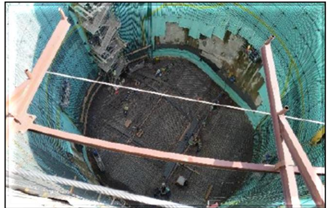
Armação da laje de fundo e do revestimento secundário do poço.
