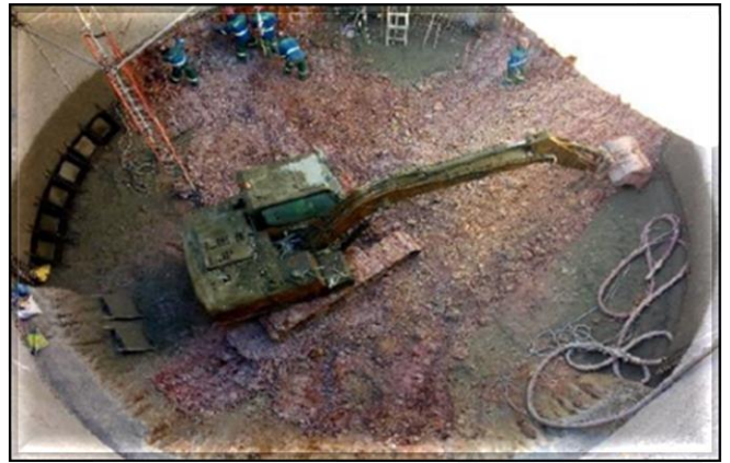
Escavação do poço.
