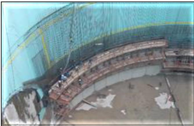
Revestimento secundário do poço do corpo da estação.
