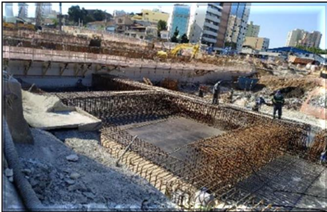
Vigas da laje de cobertura do corpo da estação.
