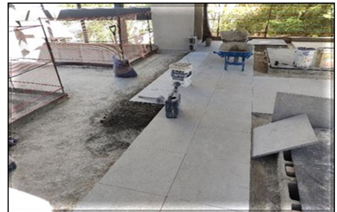
Acesso/Obra Civil – Execução do piso de granito
