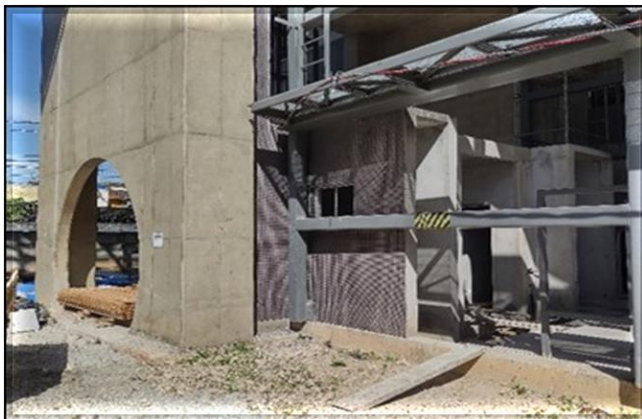
Acesso/Obra Civil – Execução do acabamento.
