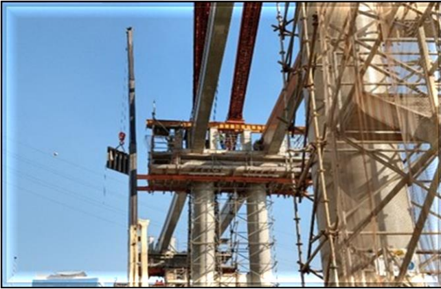
Vias do monotrilho/Obra Civil – Lote 08 - Montagem da forma de consolidação do apoio.
