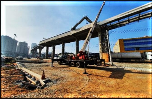
Obra Civil – Execução do novo viário. Sistemas – Montagem dos sistemas de alimentação elétrica.
