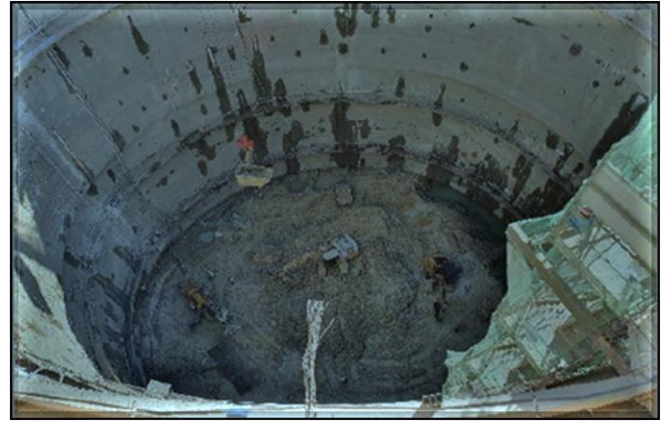
Escavação do poço do corpo da estação.
