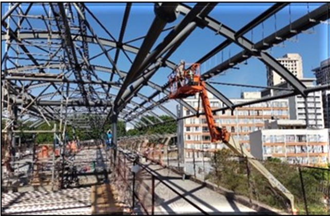
Corpo/Obra Civil – Execução de terraplenagem.
