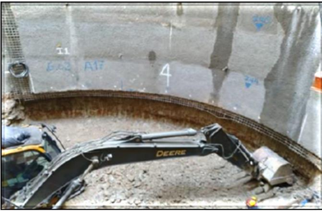
Escavação do poço.
