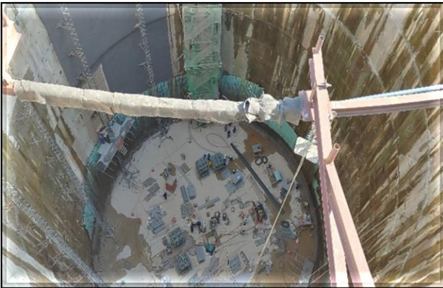
Impermeabilização e revestimento secundário do Poço.
