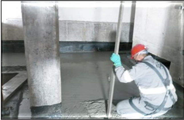
Edifício Técnico e Operacional/Obra Civil – Piso de concreto na região do reservatório.
