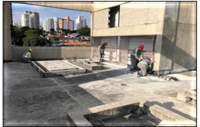
Edifício Técnico/Obra civil – Recuperação da impermeabilização.
