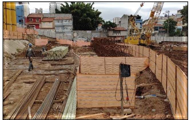
Parede diafragma da vala
