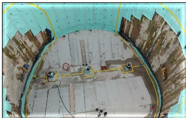
Impermeabilização do poço.
