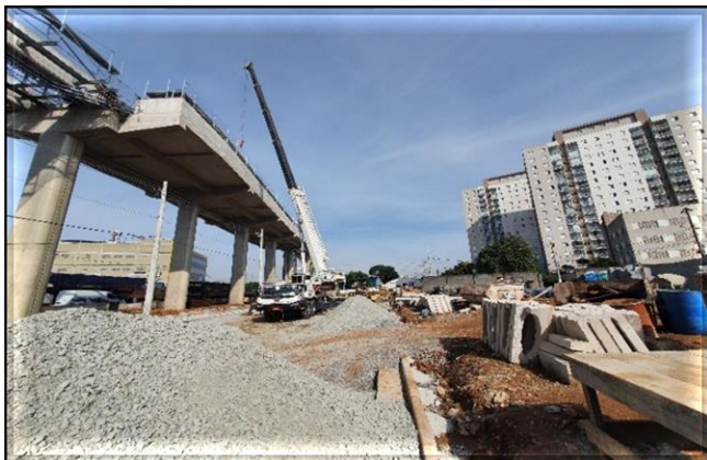
Obra Civil – Execução do novo viário. Sistemas – Montagem do bandejamento e passarela de emergência.
