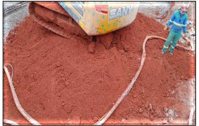
Escavação do poço.
