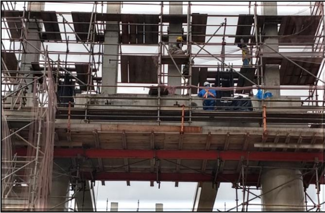
Vias do monotrilho/Obra Civil – Lote 08 protensão das vigas.
