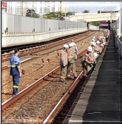
Lançamento de cabos do CBTC
