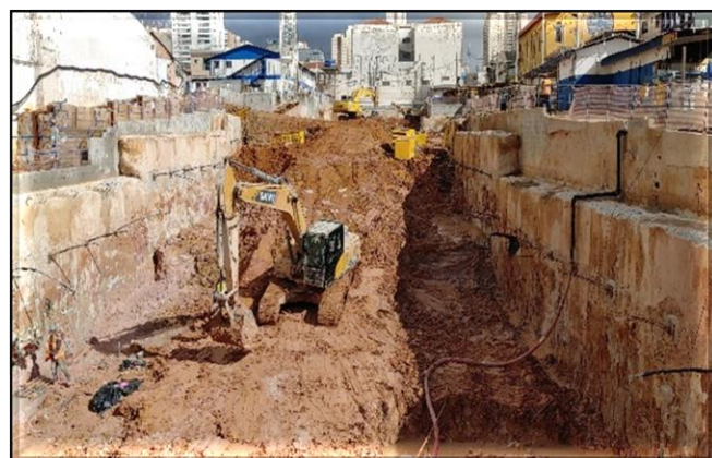
Escavação da vala do corpo da estação.
