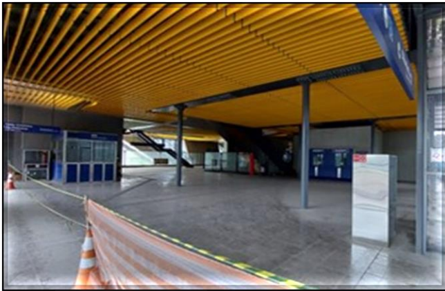
Mezanino – Aguardando a implantação de sistemas.
