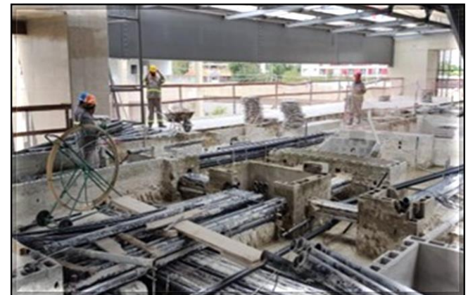
Corpo da estação/Obra Civil – Restauração dos eletrodutos.
