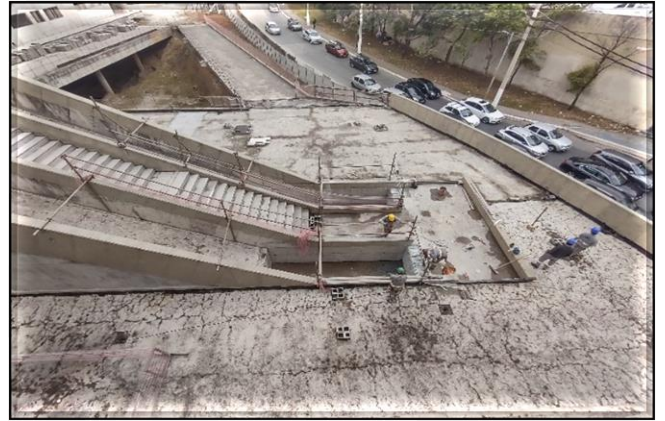
Corpo da estação/Obra Civil – Regularização da caixa da escada do acesso.
