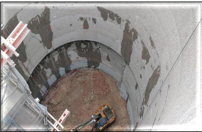
Escavação do poço.
