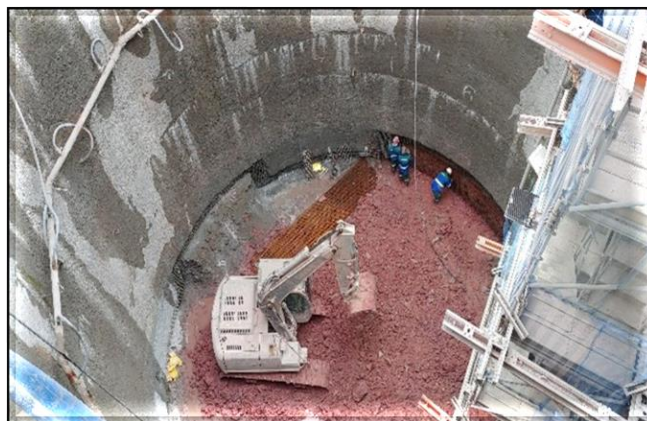
Escavação do poço.
