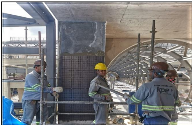
Acesso B/Obra Civil – Execução do acabamento.
