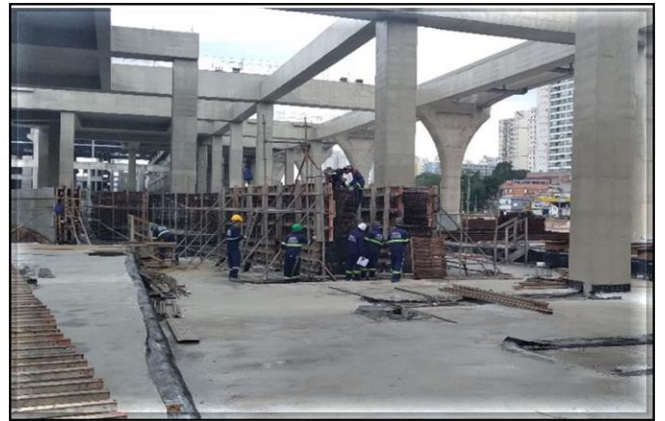
Obra Civil – Execução das vigas guia.
