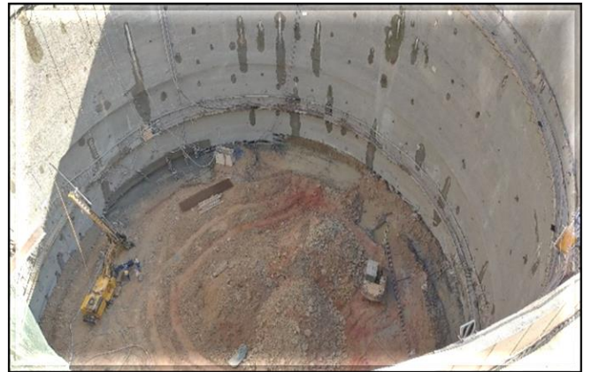
Escavação do poço do corpo da estação.
