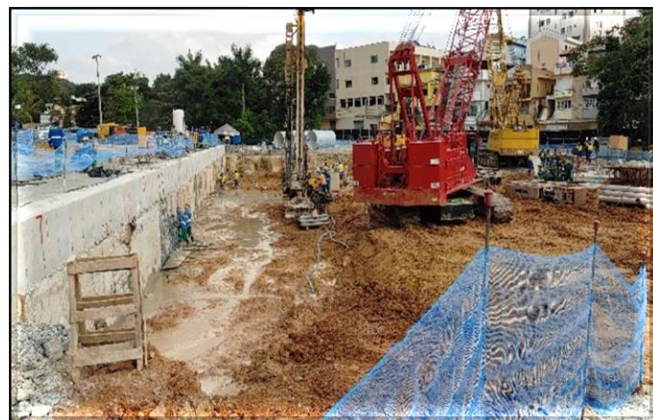
Escavação da vala.
