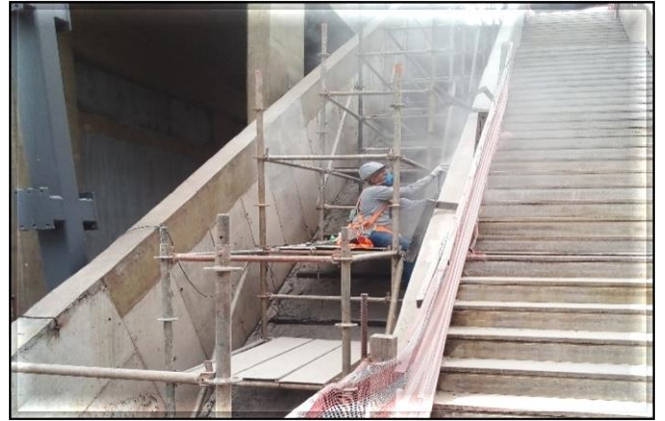
Acesso C/Obra Civil – Tratamento da caixa da escada.
