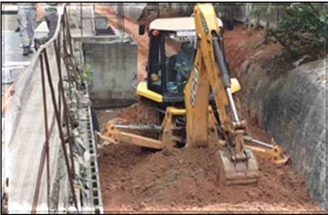
Corpo/Obra Civil – Execução de terraplenagem.
