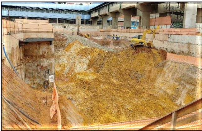
Escavação e execução de tirantes da vala do corpo da estação.
