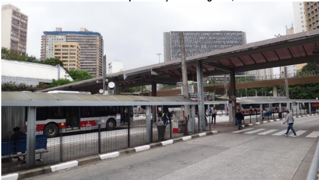
Foto 9.3.189 - Usos Afetados pela estação Anhangabaú, Terminal Bandeira
