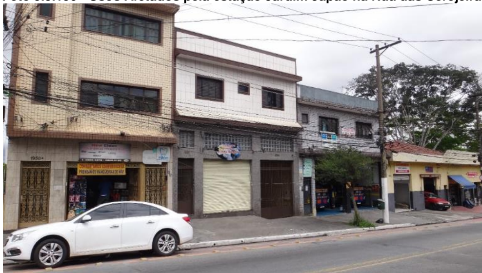
Foto 9.3.150 - Usos Afetados pela estação Jardim Japão na Rua das Cerejeiras
