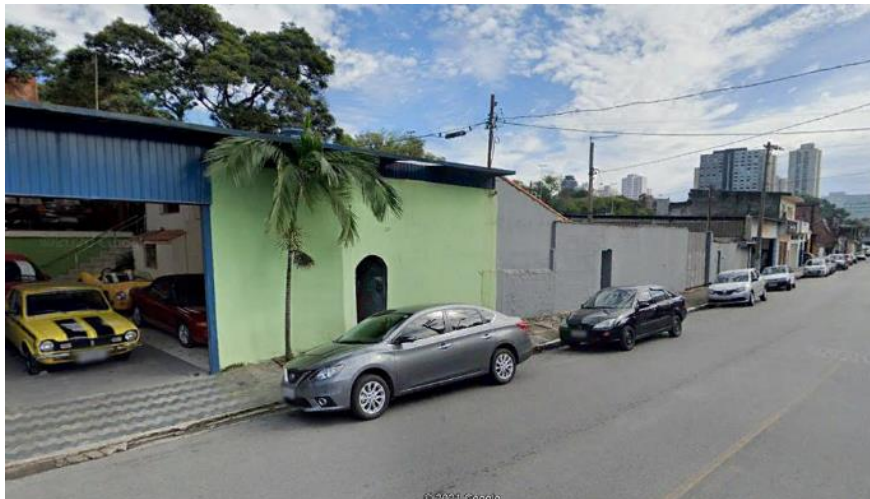
Foto 9.3.116 - Vista dos Imóveis Afetados na Av. Guarulhos
