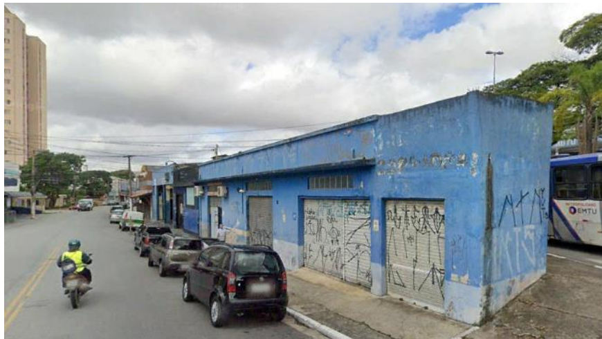
Foto 9.3.115 - Vista dos Imóveis Afetados na Av. Guarulhos
