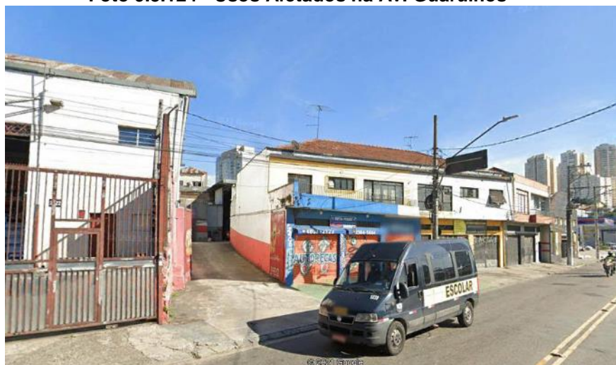
Foto 9.3.124 - Usos Afetados na Av. Guarulhos
