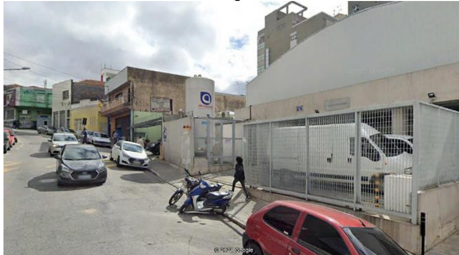
Foto 9.3.109 Estação Guarulhos Rua Cerqueira César – Área de carga e descarga do Hospital Carlos Chagas
