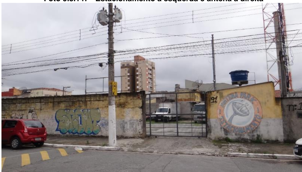
Foto 9.3.147 - Estacionamento à esquerda e antena à direita
