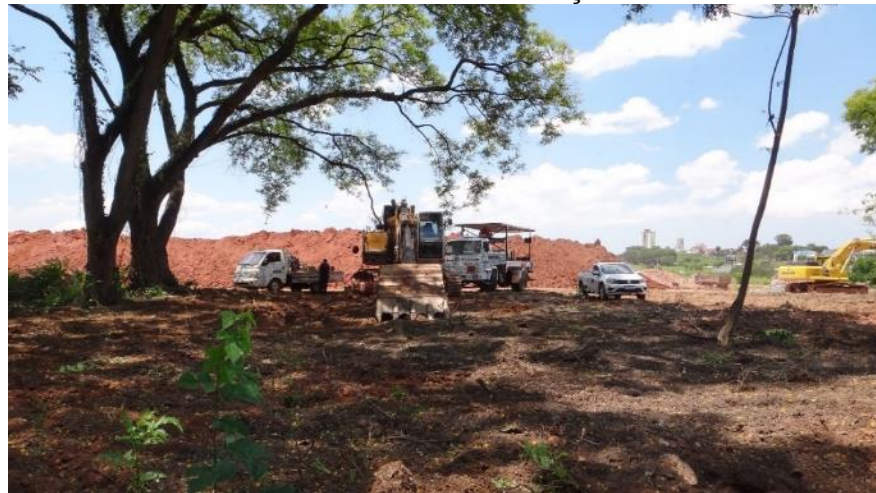
Foto 9.3.139 - Área com movimentação de terra
