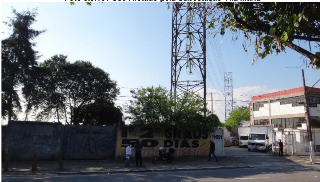
Foto 9.3.161 Uso Afetado pela Subestação Vila Maria
