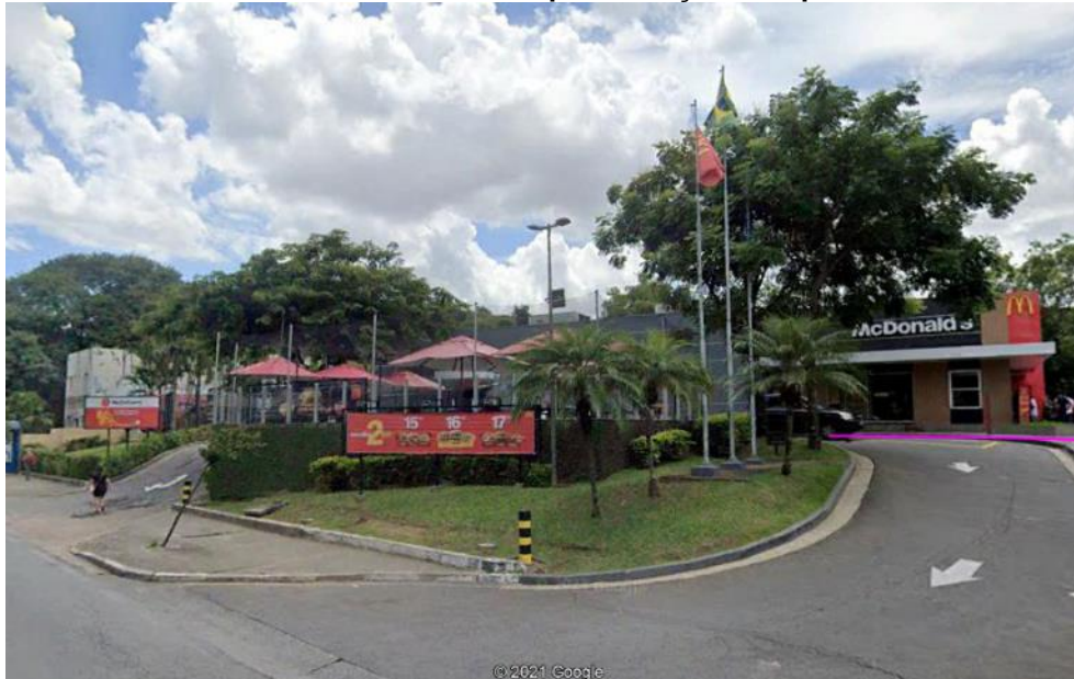
Foto 9.3.104 – Uso Afetado pela Estação Bosque Maia
