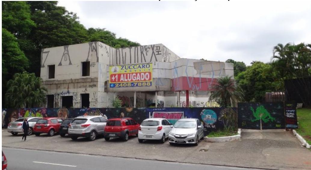
Foto 9.3.105 – Uso Afetado pela Estação Bosque Maia
