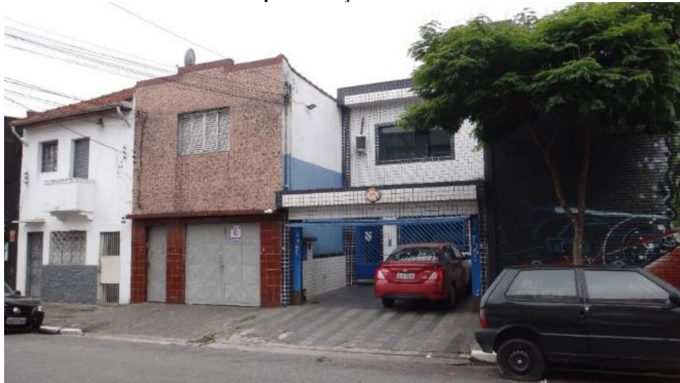
Foto 9.3.158 - Usos Afetados pela estação Vila Maria na Rua Antônio Fonseca
