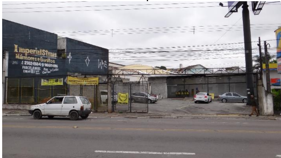
Foto 9.3.100 – Usos Afetados pelo VSE 1 – Av. Tiradentes
