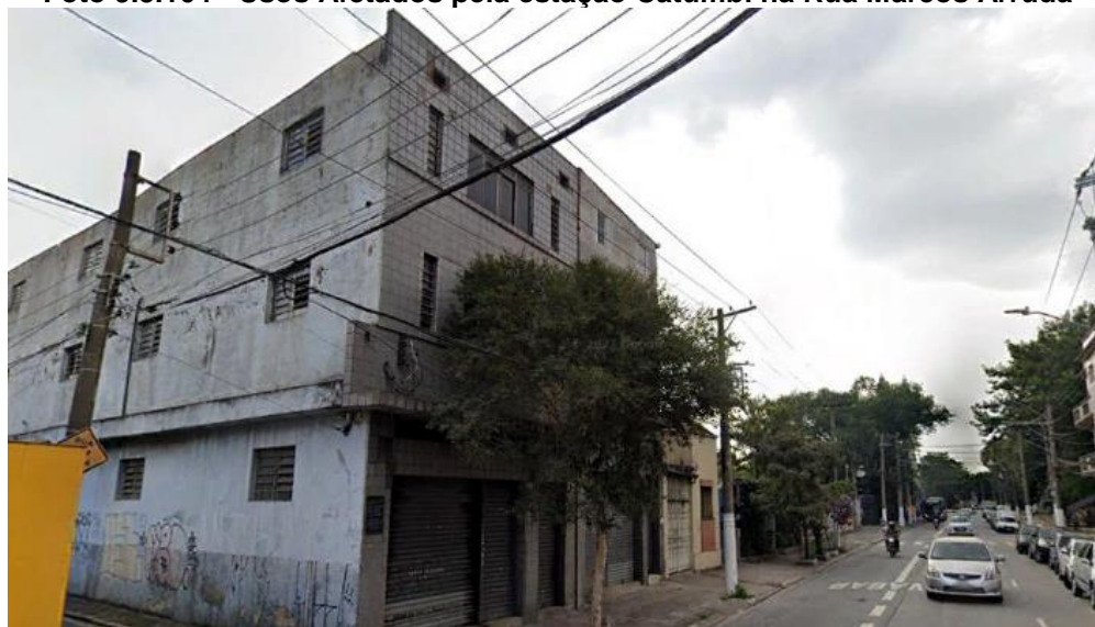
Foto 9.3.164 - Usos Afetados pela estação Catumbi na Rua Marcos Arruda
