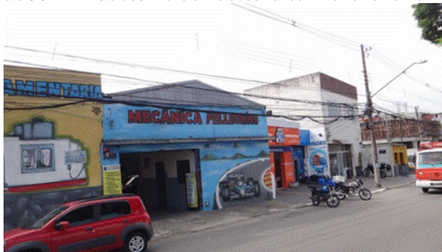
Foto 9.3.117 - Vista dos Imóveis Afetados na rua Antônio Lervolinov
