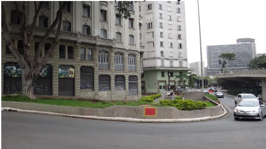
Foto 9.3.188 - Usos Afetados pela estação Anhangabaú, Rua Riachuelo
