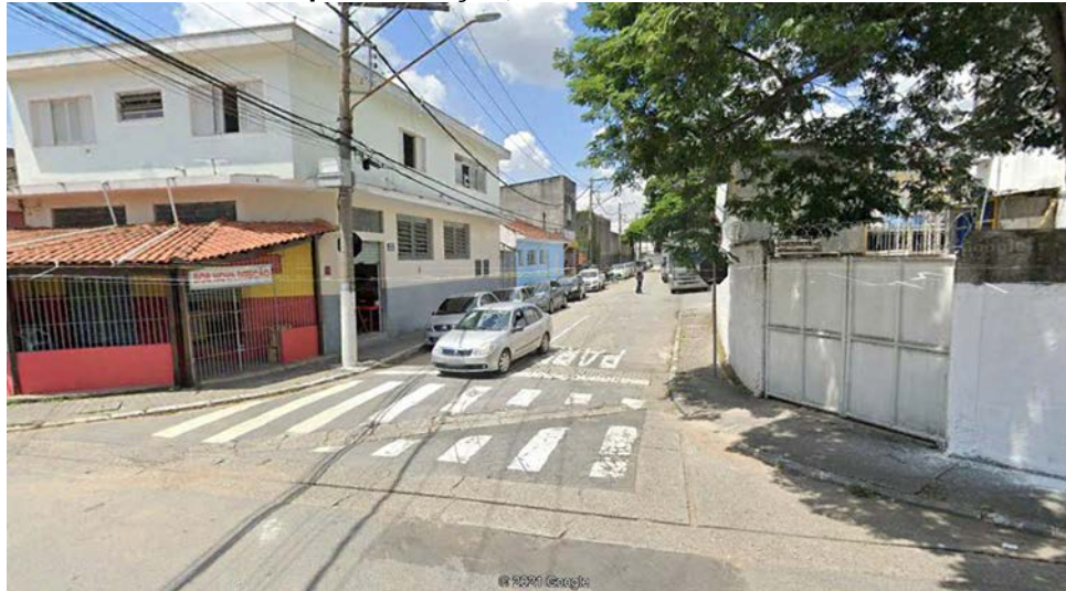
Foto 9.3.43 – Vista das áreas da estação na esquina da rua Cavadas com Canadense: à esquerda o corpo da estação, à direita acesso a ela
