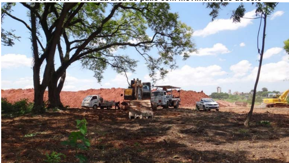
Foto 9.3.41 – Vista da área do pátio com movimentação de solo
