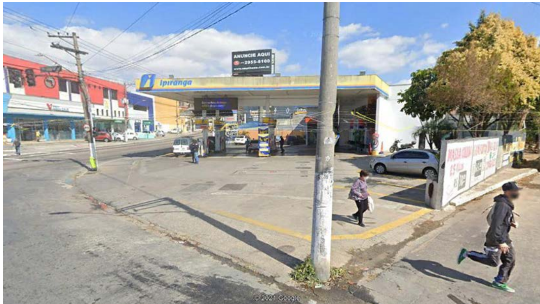
Foto 9.3.62 – Vista do local do VSE 01
