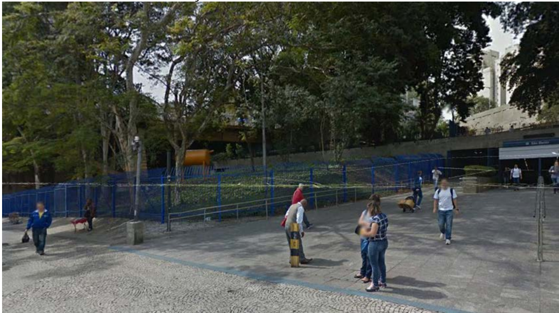
Foto 9.3.10 – Local de implantação do acesso leste da estação São Bento, incluindo o atual acesso à estação homônima da Linha 1-Azul
