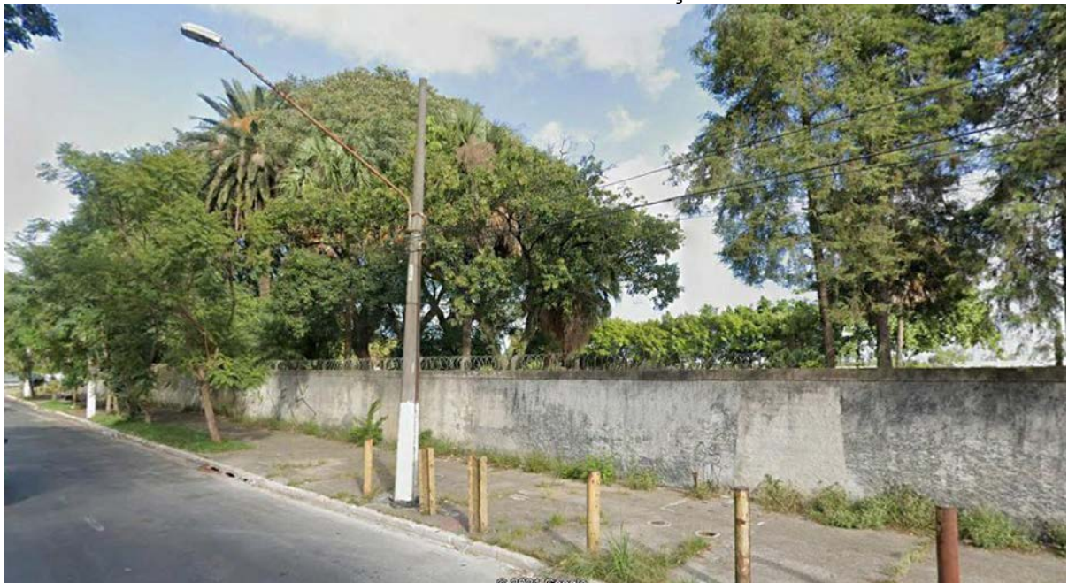
Foto 9.3.20 – Vista do local da subestação Vila Maria
