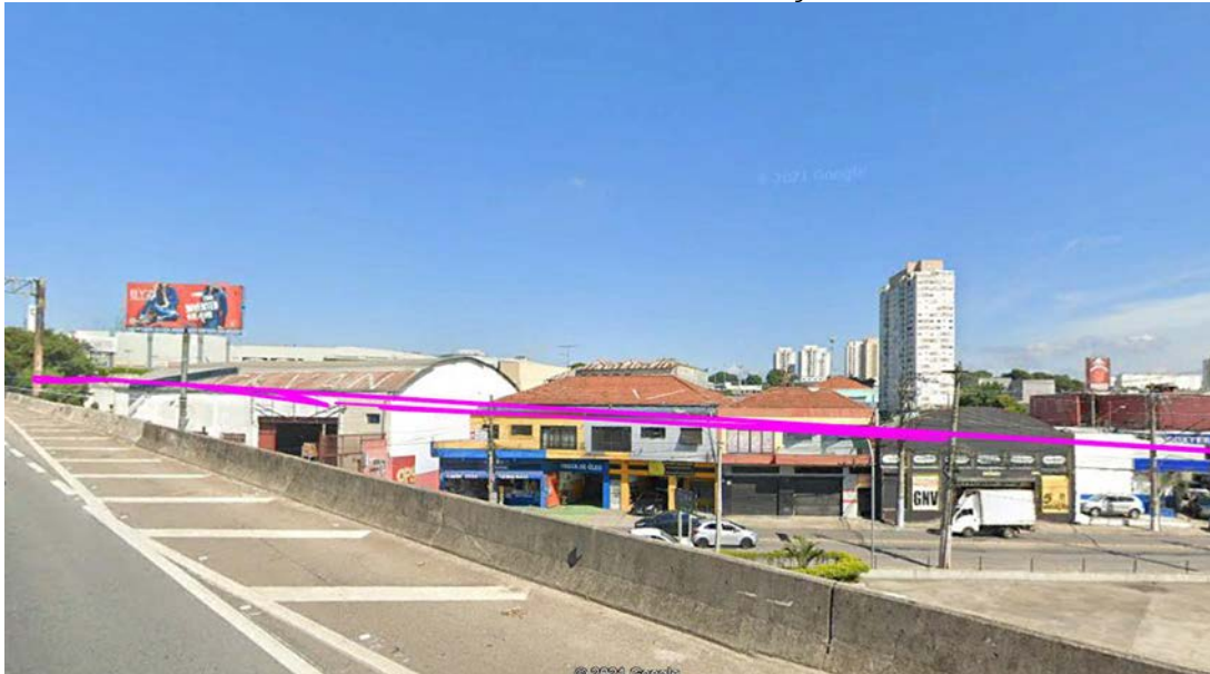
Foto 9.3.46 – Vista do Local da Estação Dutra
