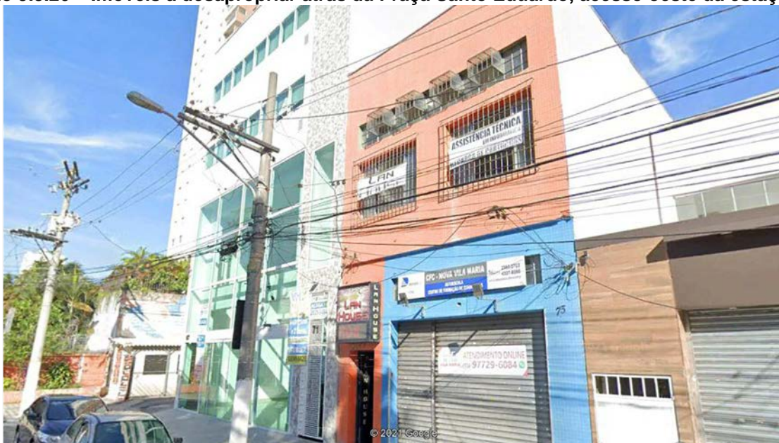
Foto 9.3.26 – Imóveis a desapropriar atrás da Praça Santo Eduardo, acesso oeste da estação
