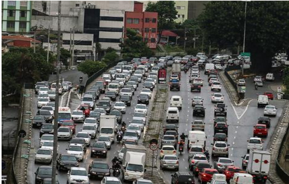
Foto 9.3.63 – Tráfego intenso no viaduto Júlio de Mesquita Filho na ligação Leste Oeste, próximo ao VSE 18 à direita
