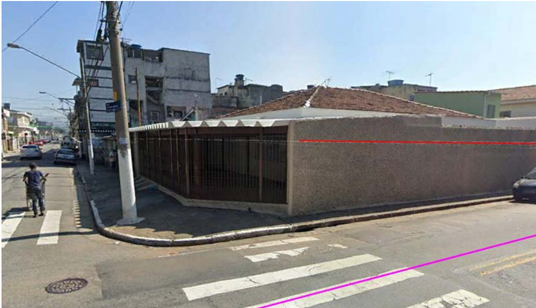
Foto 9.3.34 – Vista do local do VSE 08
