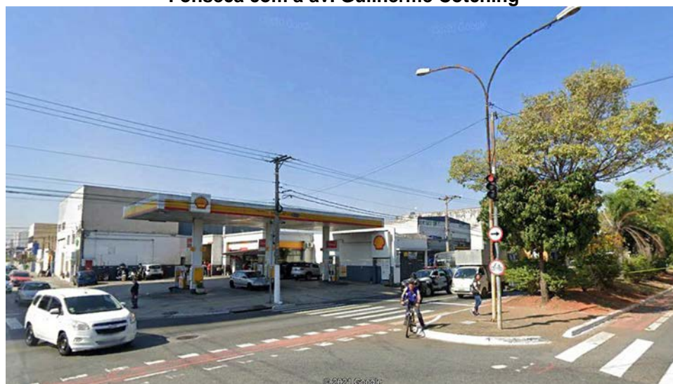
Foto 9.3.23 – Vista do local da implantação da estação Vila Maria desde o entroncamento da rua Antônio Fonseca com a av. Guilherme Cotching
