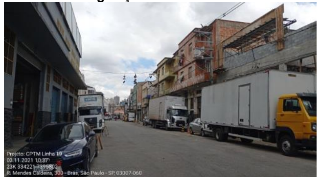
Foto 9.2.47 – Outra vista da área onde será implantada a Estação Pari que se caracteriza pela ausência de vegetação
