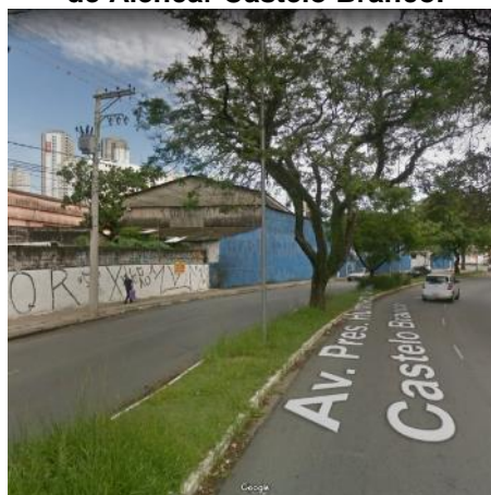
Figura 9.1.16 – Contexto do córrego sem denominação tamponado na Av. Pres. Humberto de Alencar Castelo Branco.
