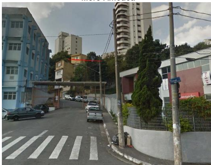
Foto 9.1.4 – Vista de face do talude, com acesso pela Rua Mere Amédea
