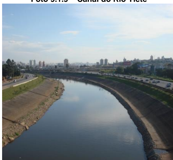
Foto 9.1.9 – Canal do Rio Tietê
