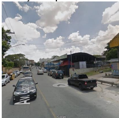
Figura 9.1.14 – Contexto onde passa o córrego sem denominação tamponado na Av. Guarulhos.
