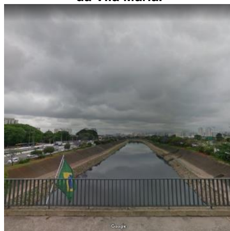
Figura 9.1.32 – Vista do trecho em que o traçado da Linha 19-Celeste passa sob o Rio Tietê, na Ponte da Vila Maria.
