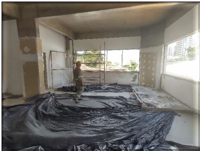
ETO/Obra civil – execução do acabamento.
