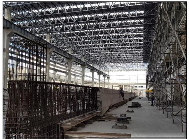
Bloco A – execução da cobertura.
