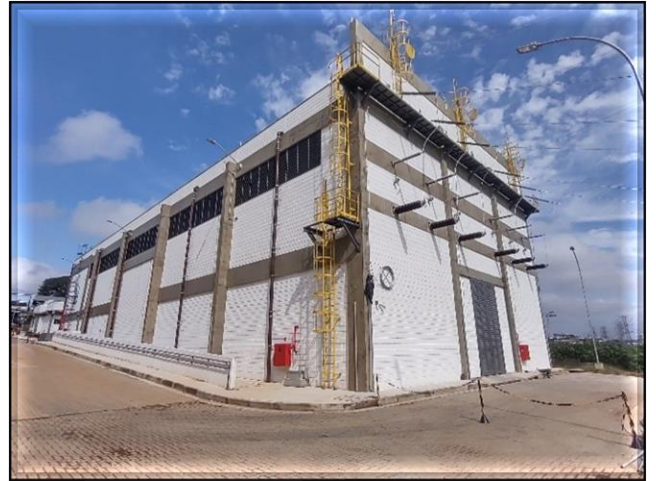
Sistemas – Subestação energizada.
