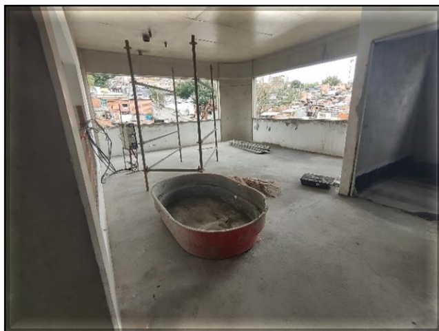
Edifício Técnico e Operacional (ETO)/ Obra civil – execução do acabamento.
