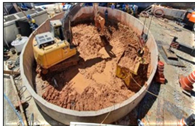
Escavação do poço.
