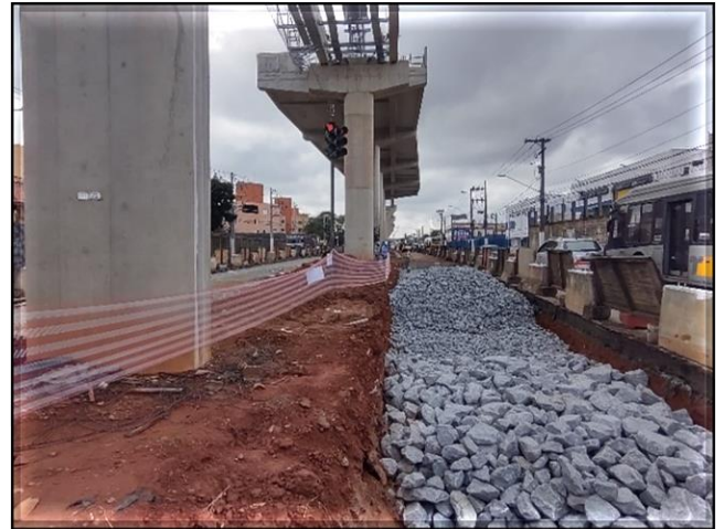
Obra Civil – recomposição do viário.
