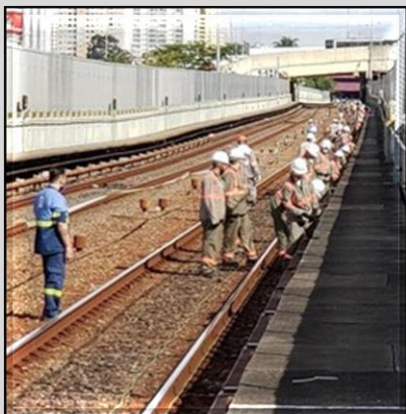
Lançamento de cabos do CBTC
