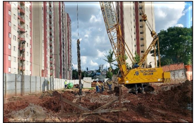
Parede diafragma da vala
