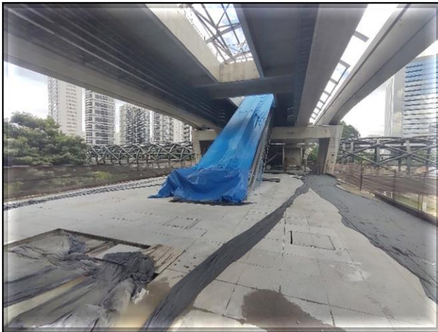
Corpo da estação/Obra civil – acabamento do mezanino.
