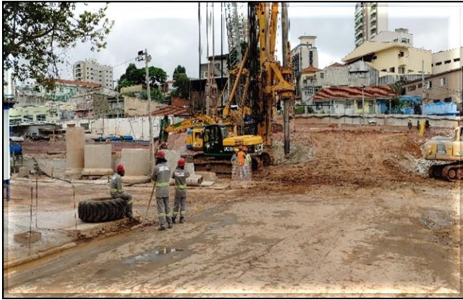
Parede diafragma da vala do corpo da estação.
