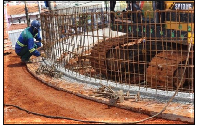
Viga de borda para escavação do Poço.
