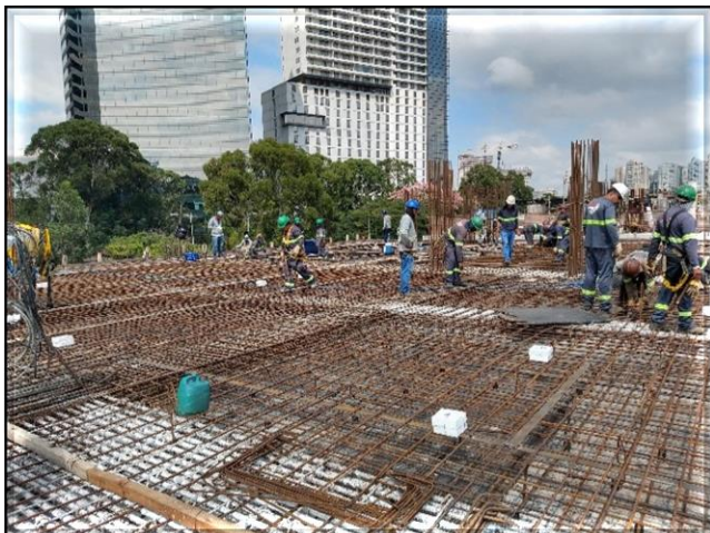
Vias do monotrilho/ Obra Civil – execução do Track Switch.
