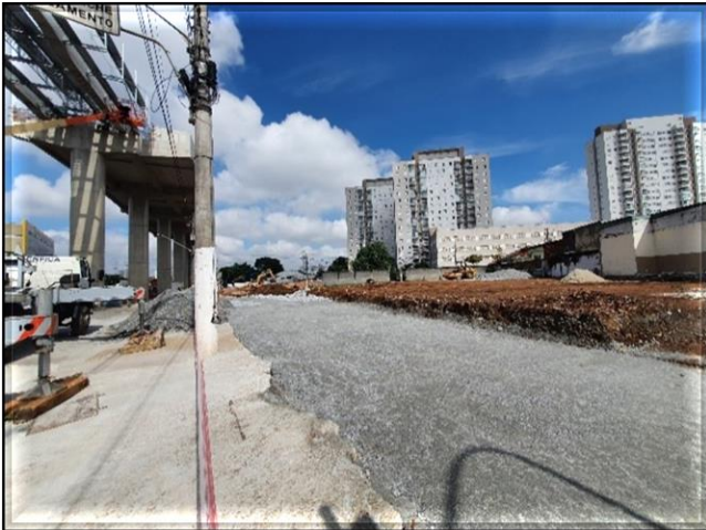
Obra Civil – execução do novo viário.
