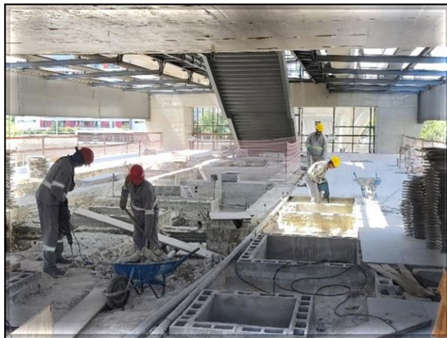
Corpo da estação/Obra civil – execução de demolição e acabamento do mezanino.
