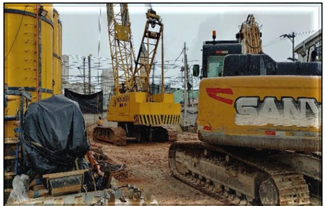
Parede diafragma da vala do acesso.
