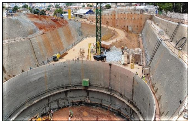
Escavação do poço do corpo da estação.
