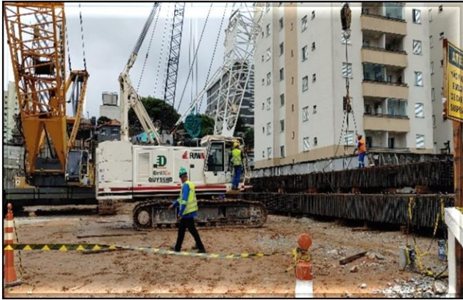
Parede de diafragma dos poços do corpo da estação.
