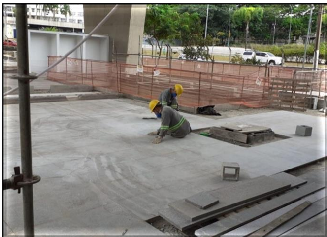
Acesso/Obra civil – execução do piso de granito na região da escada.
