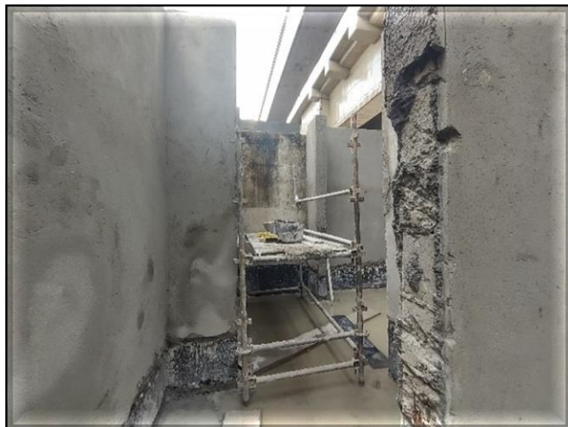
Corpo da estação/Obra civil – execução do reboco das salas operacionais.
