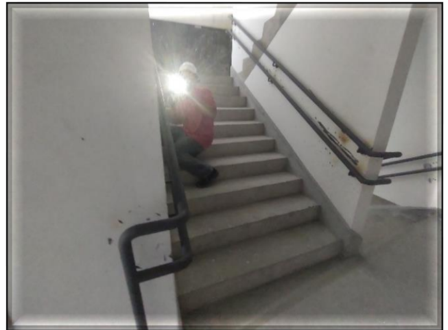
ETO/Obra civil – execução da pintura do corrimão.
