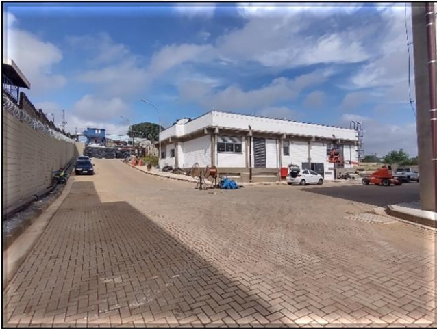
Obra Civil – em execução acabamentos e retirada de pendências.
