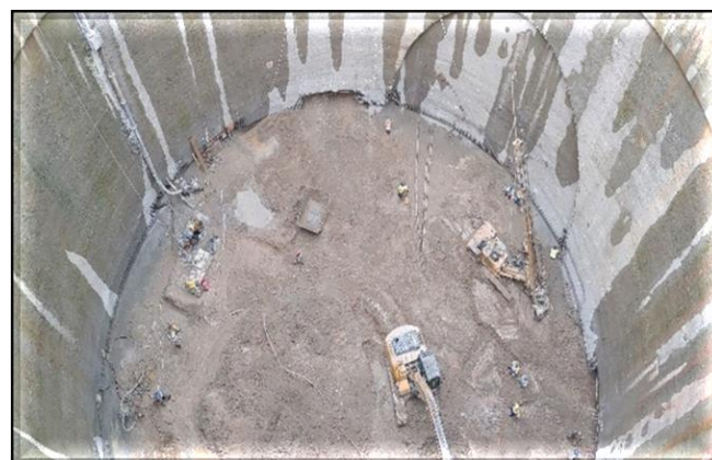
Escavação do poço do corpo da estação.
