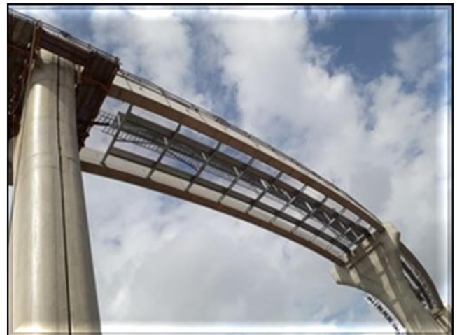
Obra Civil – montagem da passarela metálica.
