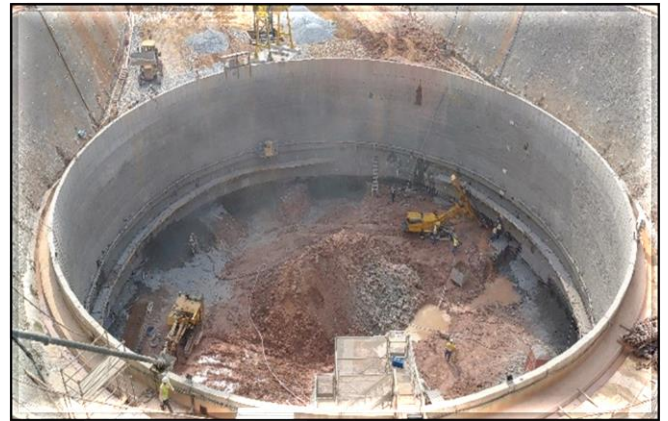
Escavação do poço do corpo da estação.
