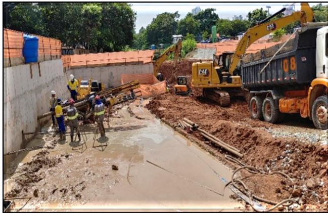
Parede diafragma da vala do corpo da estação e execução de tirantes.
