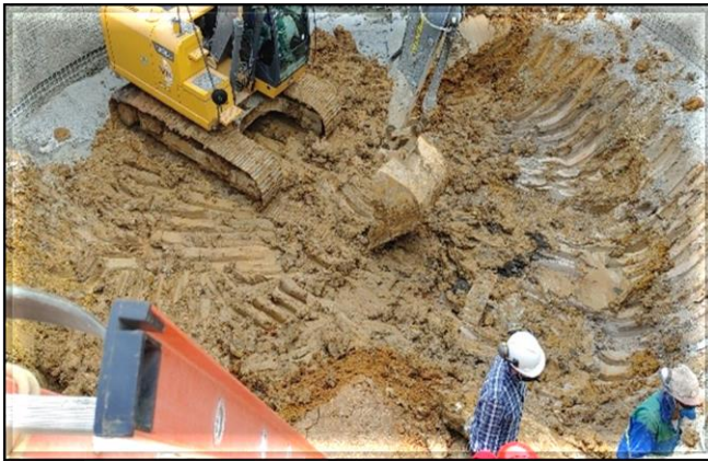
Escavação do poço.
