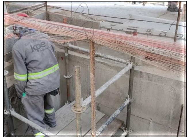
Corpo da estação – ajuste do apoio de instalação de da escada rolante.
