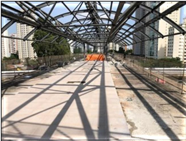
Corpo da estação – Obra Civil – piso de granito na plataforma.
