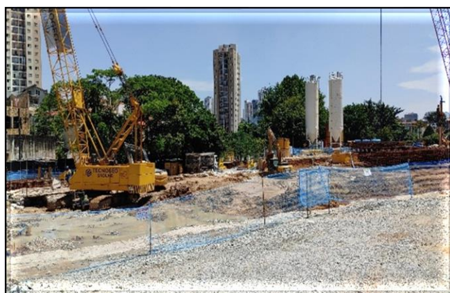
Parede diafragma da vala.
