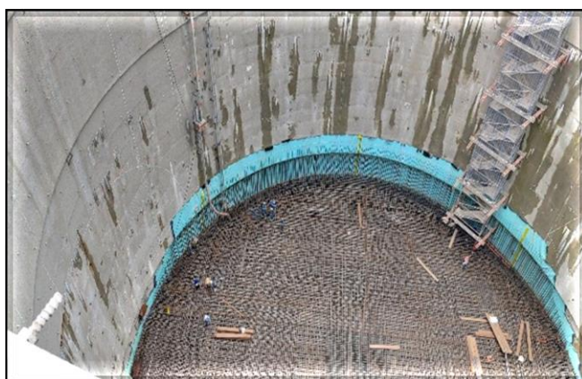
Armação da laje de fundo do poço do corpo da estação
