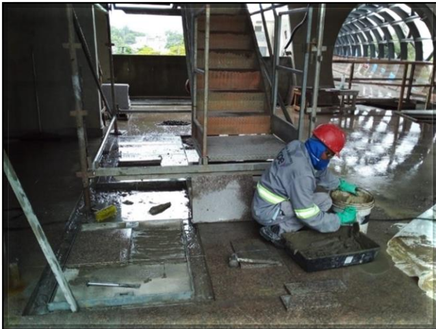
Corpo da estação – execução do piso de granito e instalação de alçapão.
