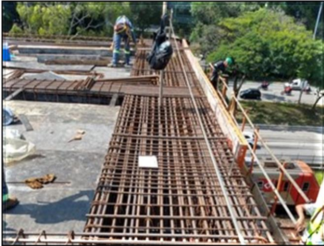
Vias do monotrilho – execução do Track Switch.
