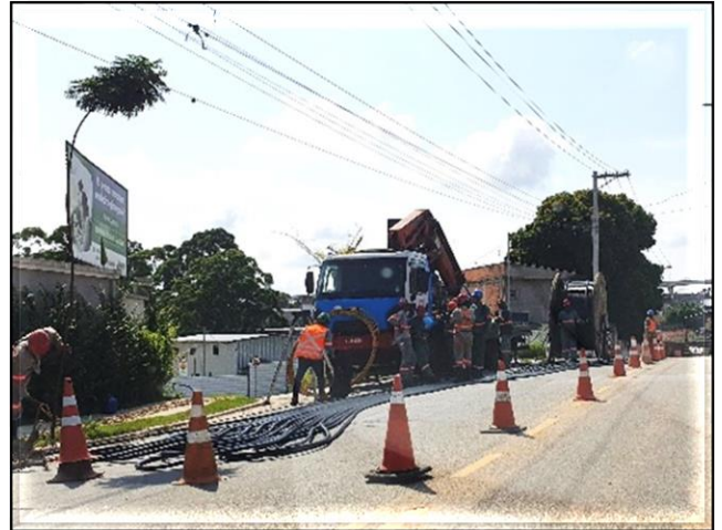
Sistemas – Lançamento de cabos no banco de dutos.
