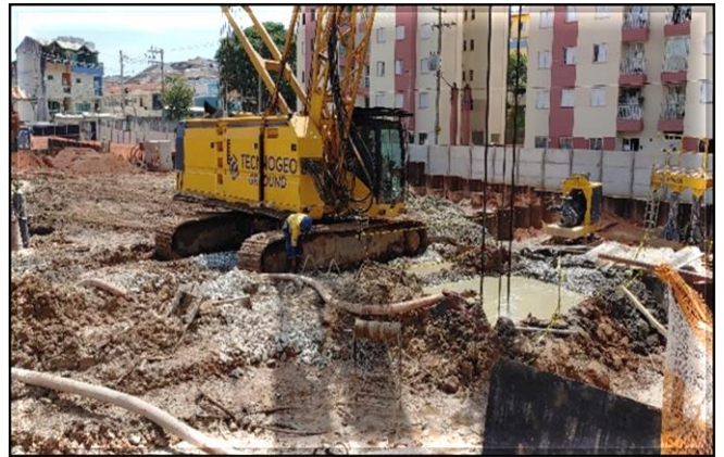
Parede diafragma da vala
