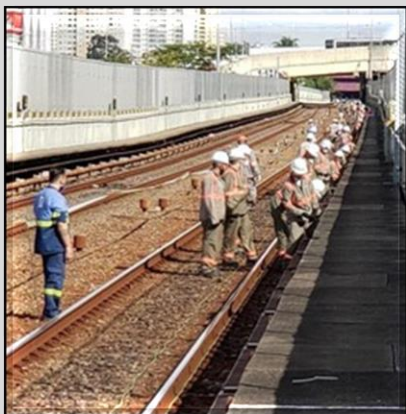
Lançamento de cabos do CBTC
