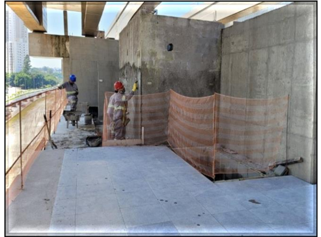
Corpo da estação – execução do reboco no mezanino.
