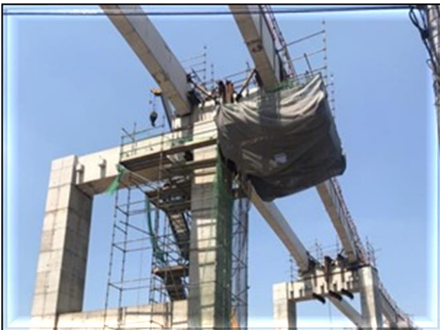
Obra Civil – monolitização dos módulos de concreto.
