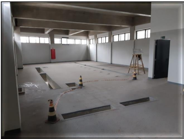
Edifício Técnico e Operacional (ETO) – aguardando a implantação de sistemas.
