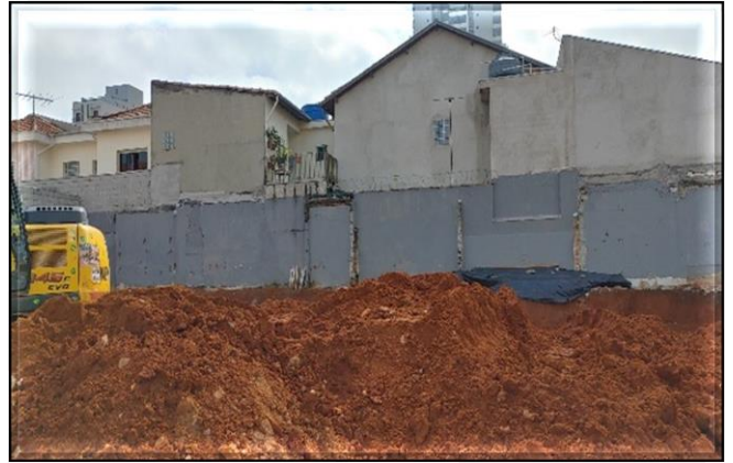
Terraplenagem da área.
