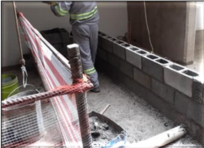
Acesso – execução de alvenaria de fechamento da escada rolante.
