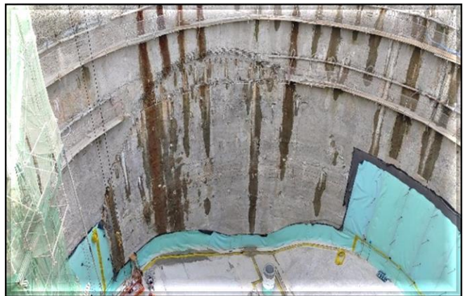
Impermeabilização do Poço.
