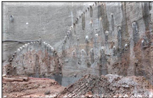
Escavação do Poço e tratamento dos emboques dos túneis.
