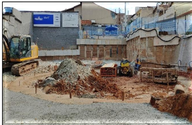
Lastro da viga de borda para escavação do Poço.
