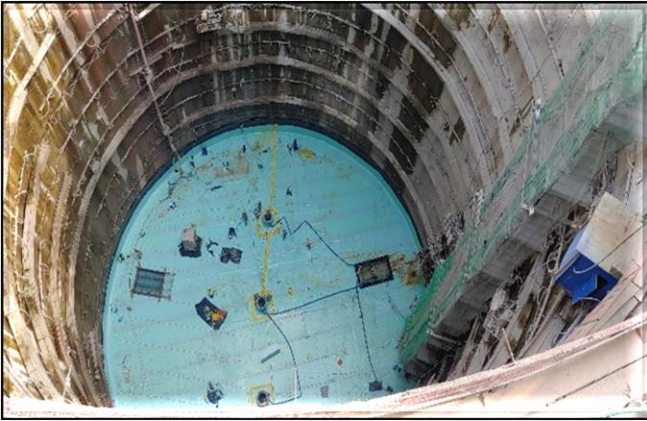
Impermeabilização do poço.
