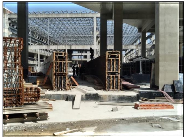
Bloco A – execução das vias internas.
