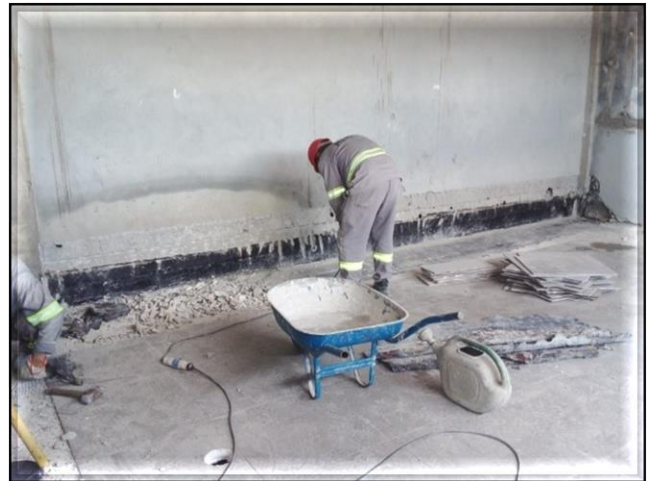
ETO – execução acabamento do vestiário.
