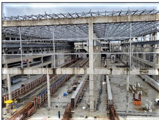
Bloco A – execução das vias internas e instalação das telhas da cobertura.
