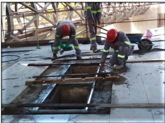
Corpo da estação – instalação de alçapão em caixa de passagem de eletrodutos.
