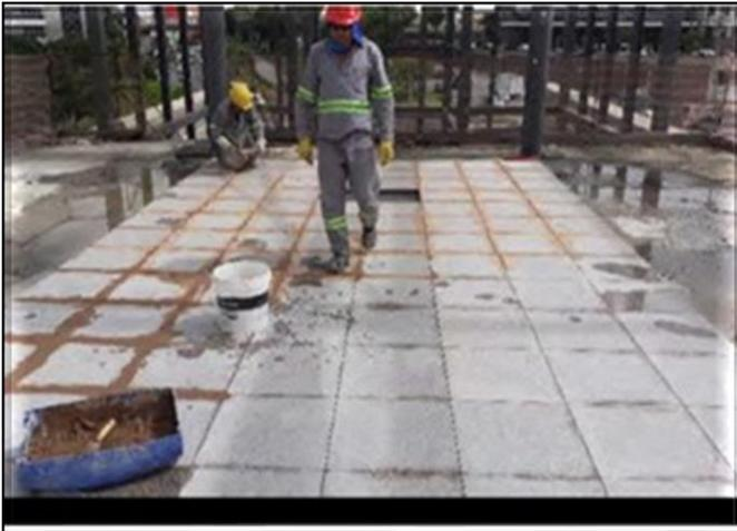
Túnel de Interligação – Instalação dos suportes das grelhas de drenagem.
