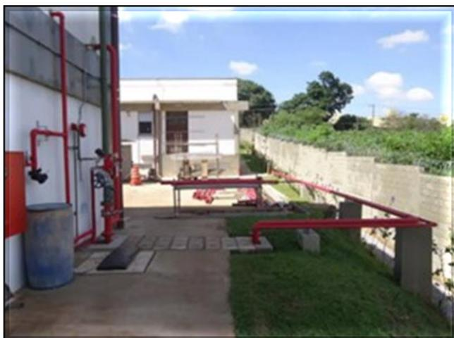
Obra Civil – em execução a montagem da tubulação de combate a incêndio.
