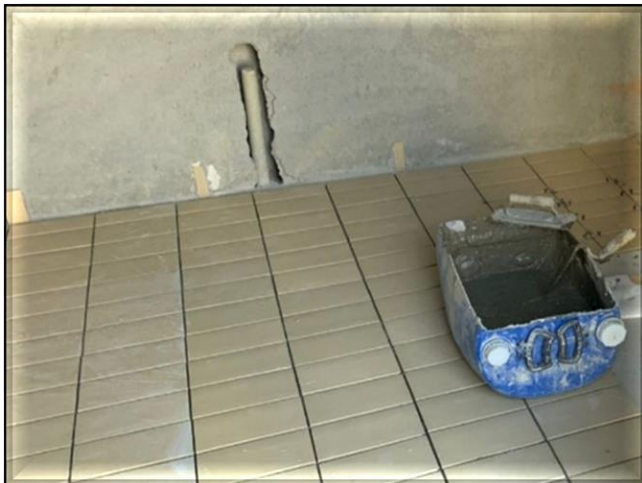
Corpo da Estação – Assentamento de piso.
