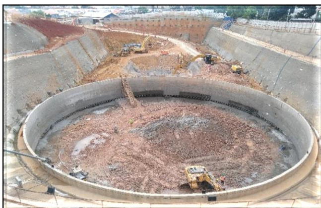
Escavação do poço do corpo da estação.
