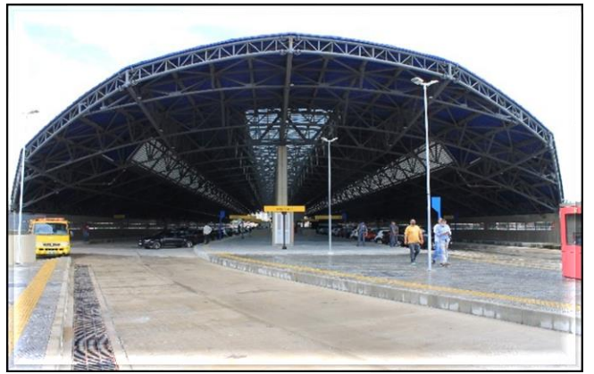
Nível Terminal – Plataformas, pavimento e cobertura metálica. Sistemas em fase de retirada de pendências.
