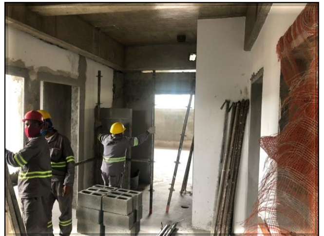
Edifício Técnico Operacional (ETO) – Execução de adequação da alvenaria e instalação de contramarca.
