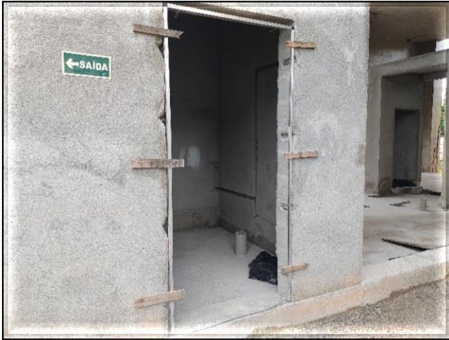
Acesso – instalação de contramarco e execução dos cortes para hidráulica.
