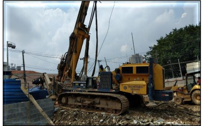
Execução da parede diafragma do corpo da estação
