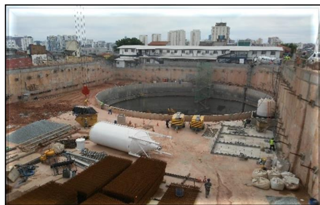
Escavação do poço do corpo da estação.
