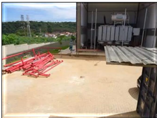
Obra Civil – em execução a montagem a tubulação de combate a incêndio
