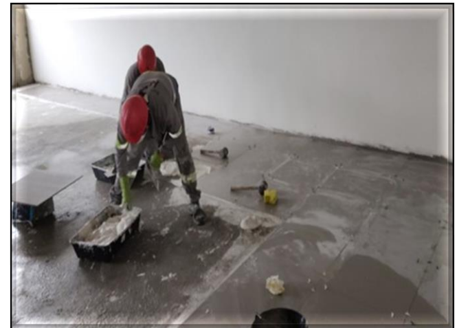
Corpo da Estação – Execução do piso de granito.
