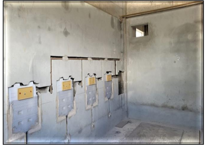
Corpo da Estação – execução de instalações hidráulicas.
