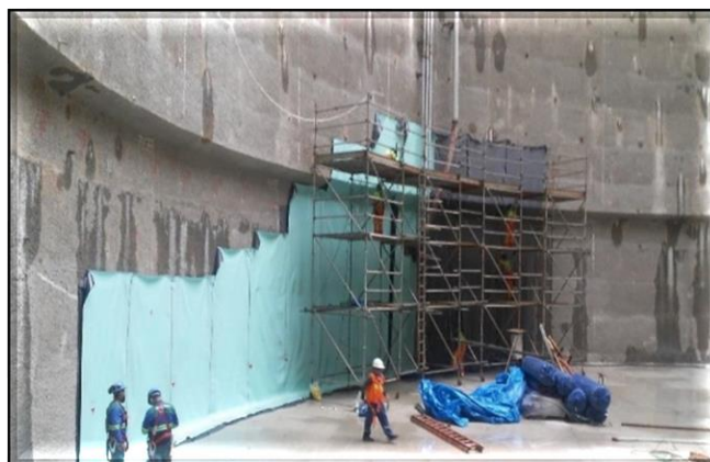
Laje de fundo e impermeabilização do poço do corpo da estação.
