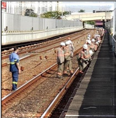
Lançamento de cabos do CBTC
