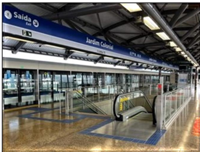
Estação Jardim Colonial pronta para inauguração.
