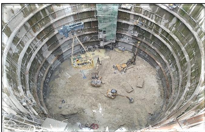
Escavação do poço
