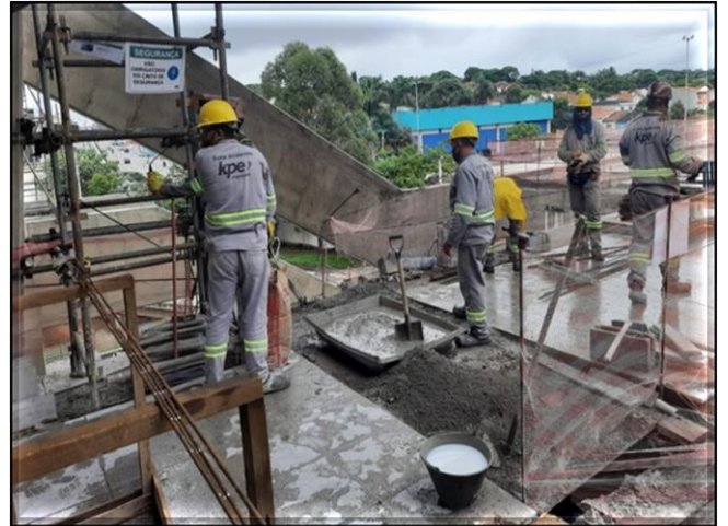
Corpo da Estação – Execução do piso de granito.
