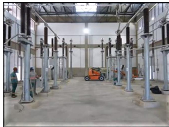
Sistemas – montagens e testes na sala de alta tensão.
