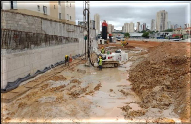
Muro de divisa em execução.
