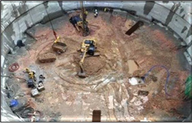
Escavação do poço do corpo da estação
