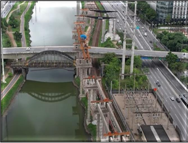
Vias do Monotrilho - Lançamento de vigas-guia.
