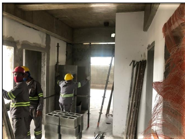
Edifício Técnico Operacional (ETO) – execução de adequação da alvenaria e instalação de contramarco.
