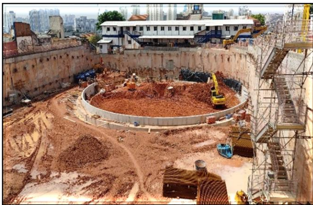
.Viga de borda para escavação do poço do corpo da estação
