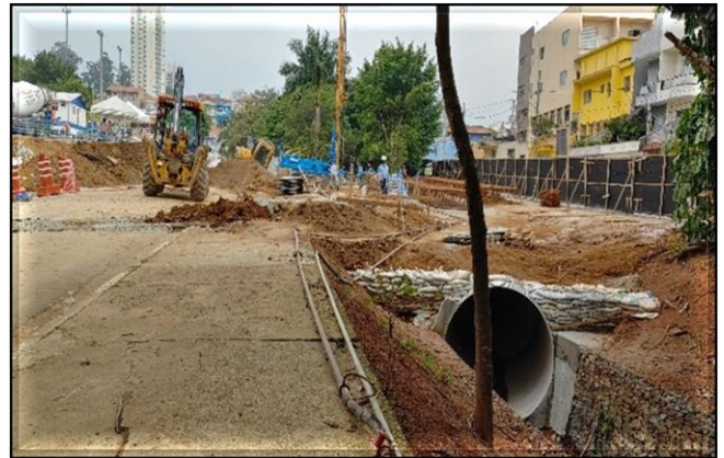
Desvio do córrego finalizado.
