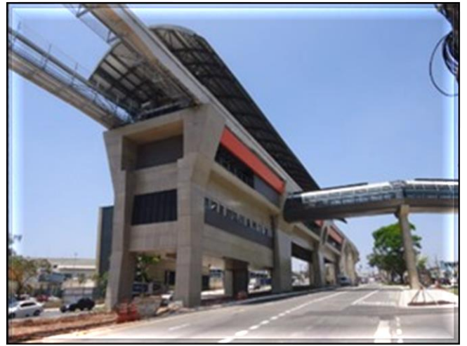
Obra Civil – Limpeza e arremate finais
