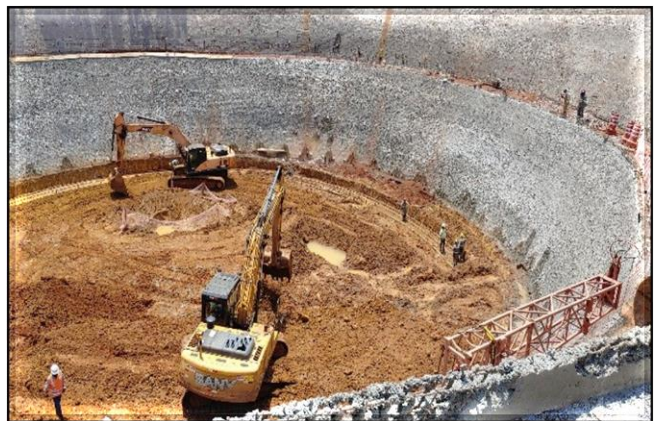
.Escavação e execução do solo grampeado
