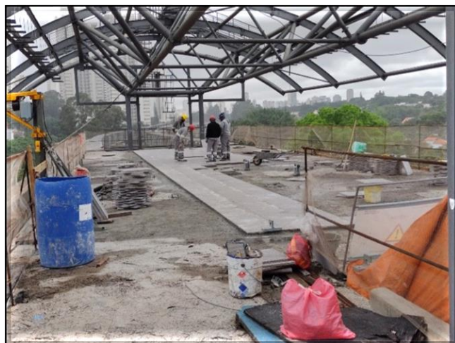
Corpo da estação – execução do piso de granito na plataforma.
