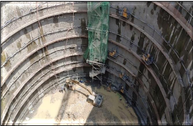
Escavação do poço
