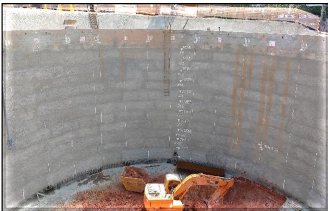
Escavação do poço do corpo da estação
