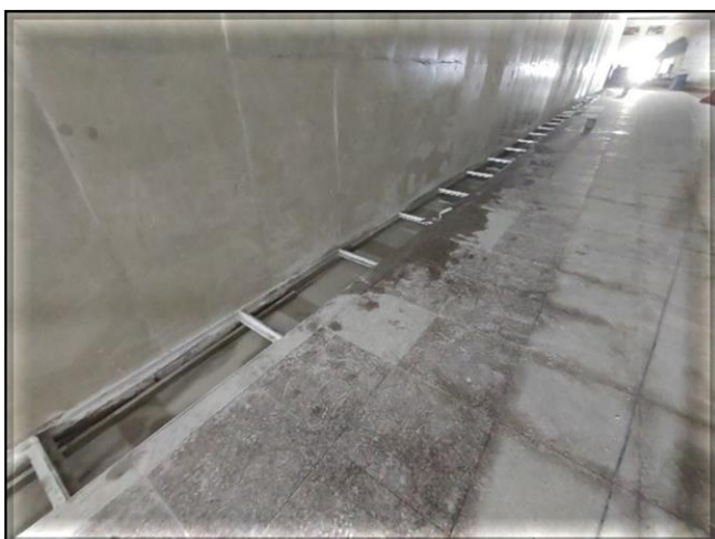
Túnel de interligação – instalação dos suportes das grelhas de drenagem.
