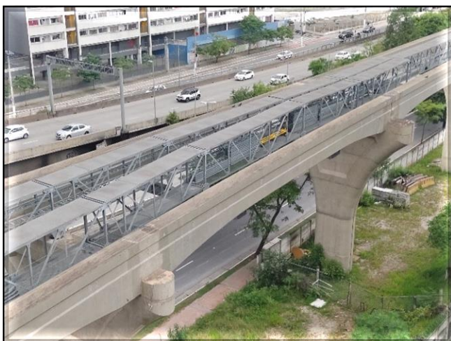
Vias do monotrilho – instalação do bandejamento no trecho entre as estações Vila Cordeiro e Chucri Zaidan.
