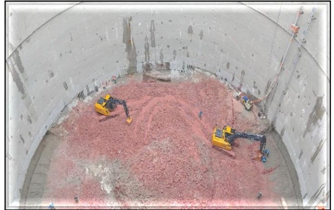
Escavação do poço do corpo da estação
