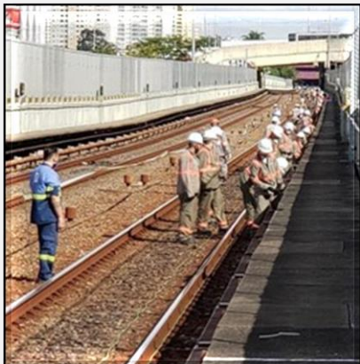
Lançamento de cabos do CBTC
