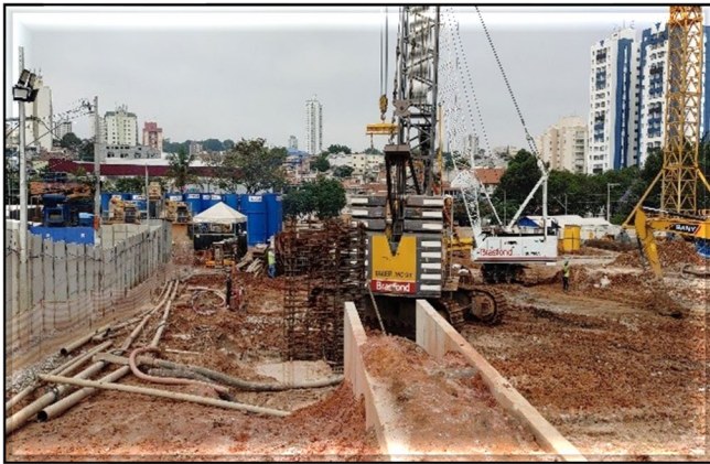
Escavação da Parede diafragma do corpo da estação
