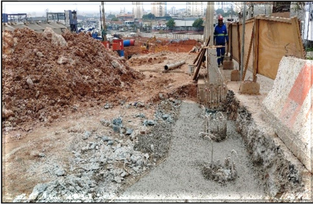
Estação em execução.
