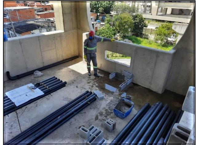
Acesso – execução da caixa de passagem dos eletrodutos
