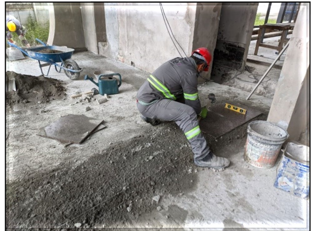
Acesso – execução do piso de granito no hall do Elevador
