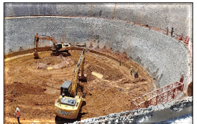
.Escavação e execução do solo grampeado
