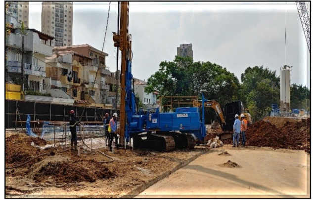
Tratamento para emboque da tuneladora
