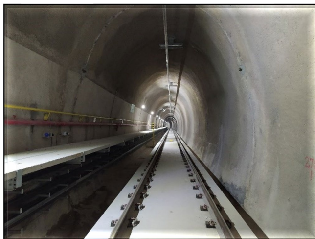
Túnel NATM Singelo – sistemas em fase de retirada de pendências.
