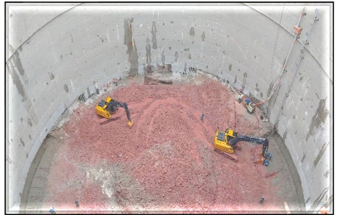
Escavação do poço do corpo da estação
