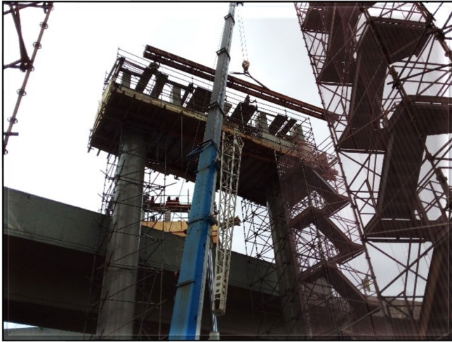
.Vias do monotrilho – lançamento da viga de apoio para lançamento das vigas-guia
