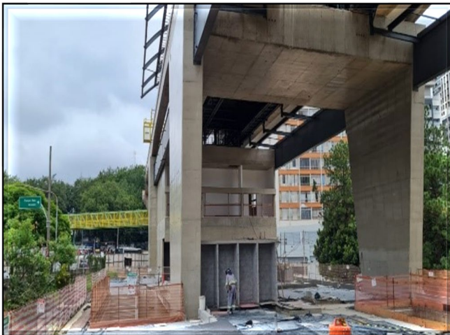
Corpo da Estação – execução dos módulos de alvenaria junto ao pilar
