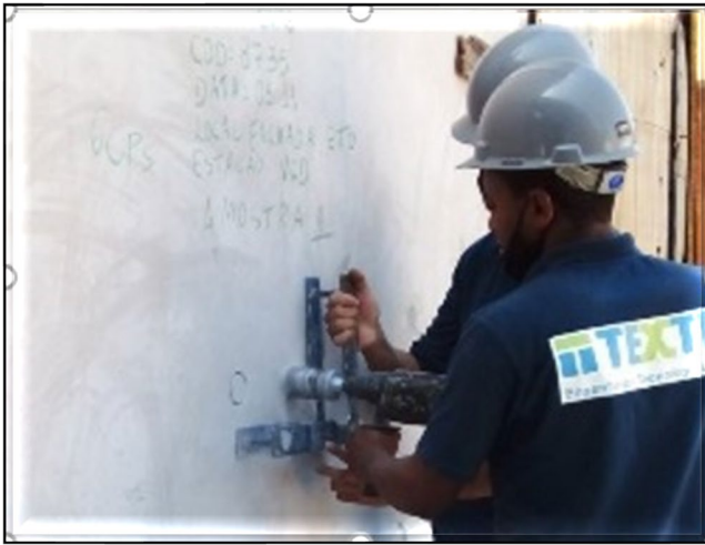
Edifício Técnico Operacional – ensaio de argamassa
