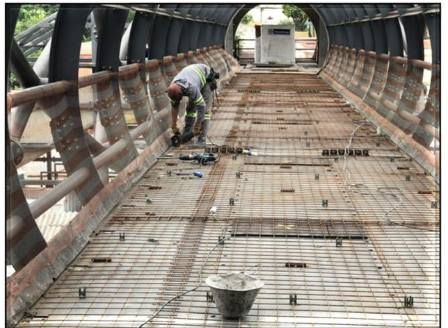
Passarela – Obra Civil – Execução da ferragem do contrapiso e preparação para instalação do corrimão
