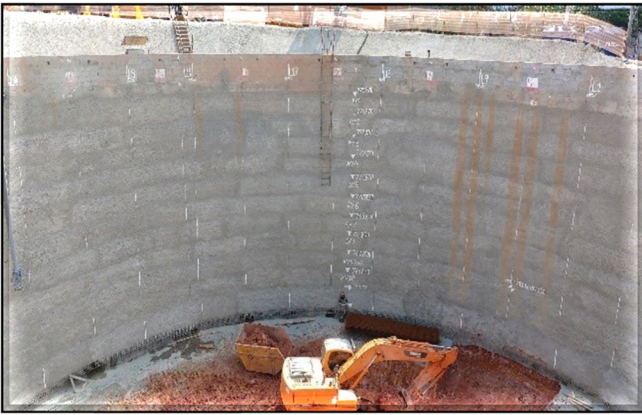
Escavação do poço do corpo da estação
