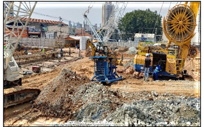
Execução da parede diafragma do corpo da estação
