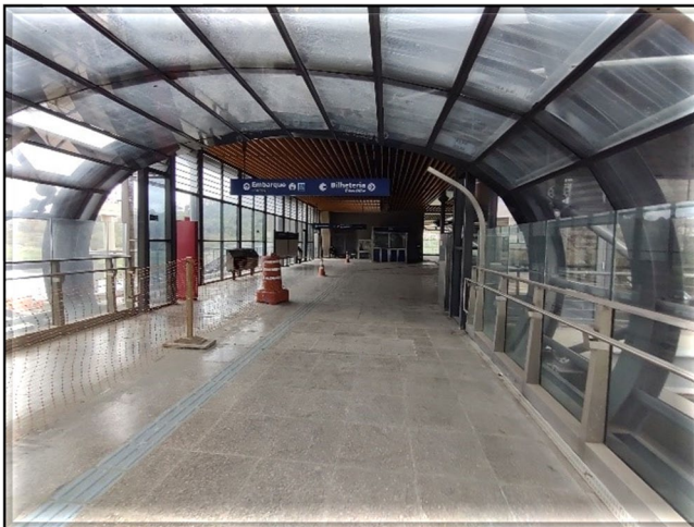
Passarela – aguardando a implantação de sistemas
