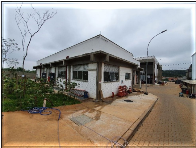
Obra Civil- em execução acabamento e paisagismo
