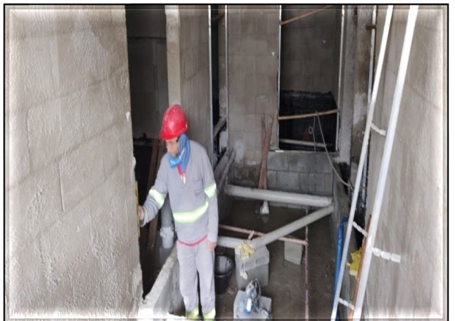
Corpo da Estação -adequação e tubulação dos sanitários
