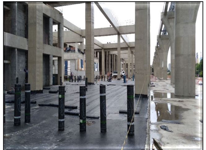
Setores 5 e 6 – aplicação da manta asfáltica
