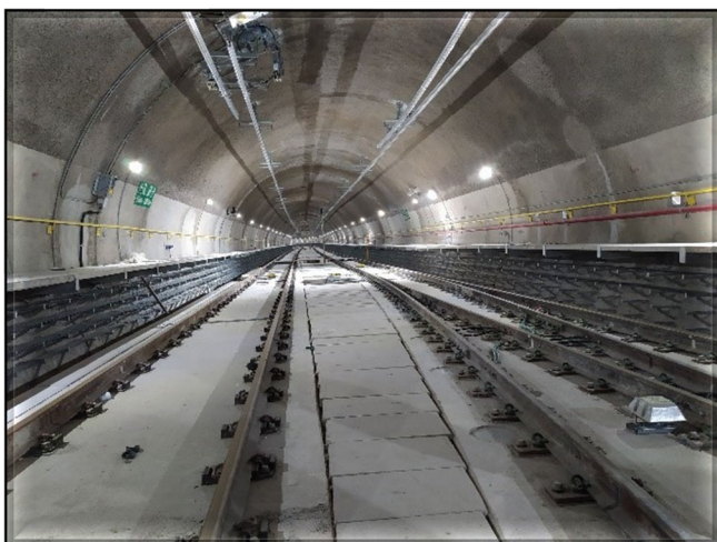
Túnel de via 02 – sistemas em fase de retirada de pendências
