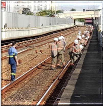
Lançamento de cabos do CBTC
