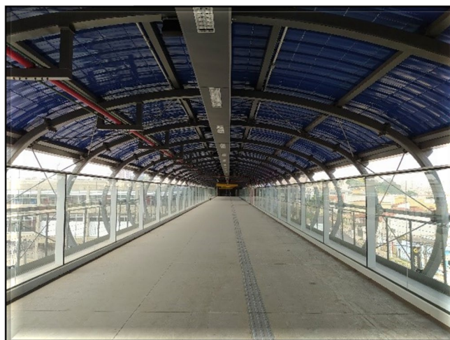
Passarela entre os Acessos Eliseu de Almeida e Heitor dos Prazeres
