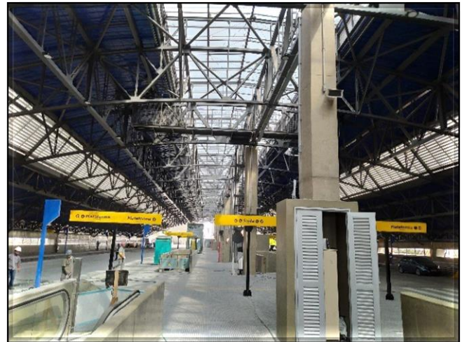
Nível Terminal – Sistemas de Telecomunicações e Auxiliares comissionados.
