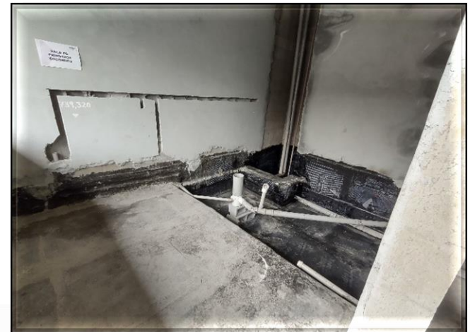
Salas operacionais - execução da tubulação de esgoto.
