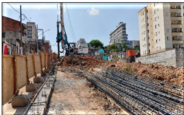
Estações em execução.
