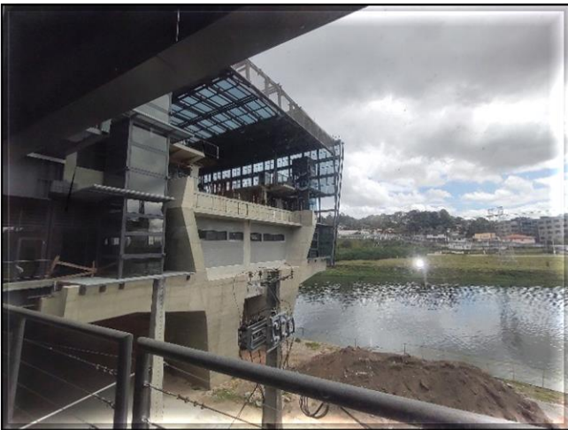
Corpo da estação – aguardando o lançamento das vigas-guia.
