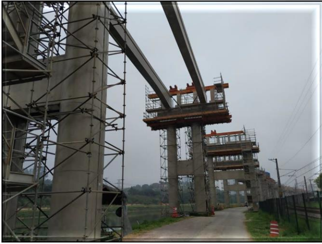
Vias do monotrilho – lançamento das vigas-guia.
