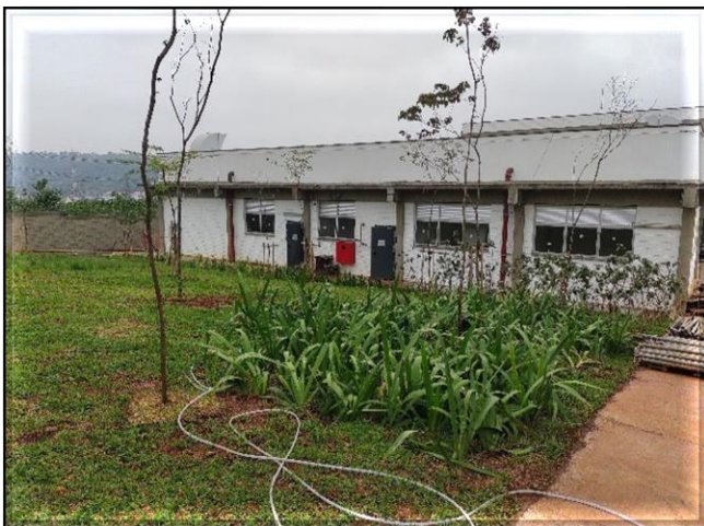
Obra Civil – em execução acabamento e paisagismo.
