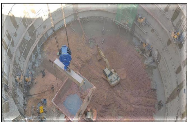
Escavação do Poço.
