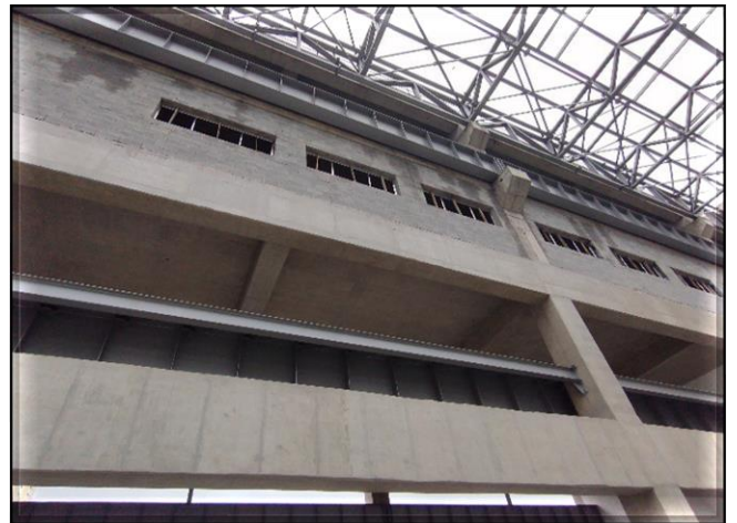
Bloco A – execução da alvenaria e emboço..
