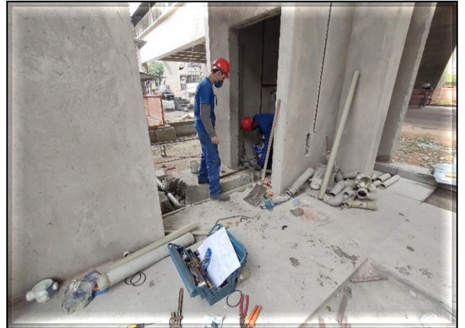
Acesso – execução da tubulação de esgoto do sanitário do bicicletário.
