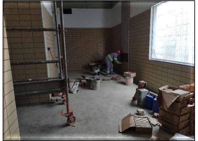
Edifício Técnico Operacional – execução do revestimento na sala de baterias.
