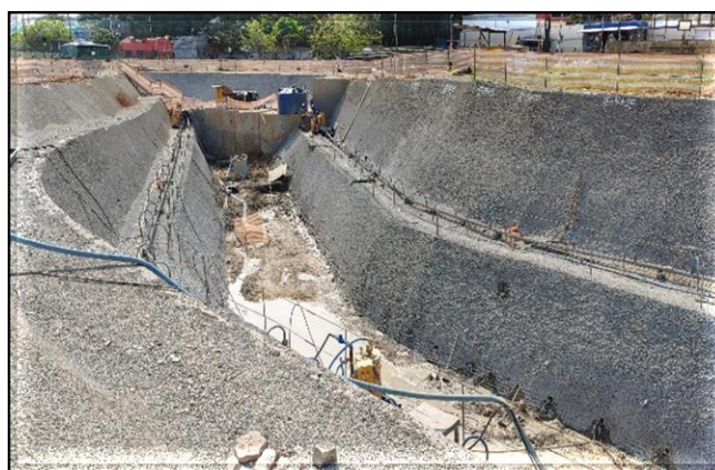
Desvio do córrego do Rincão.
