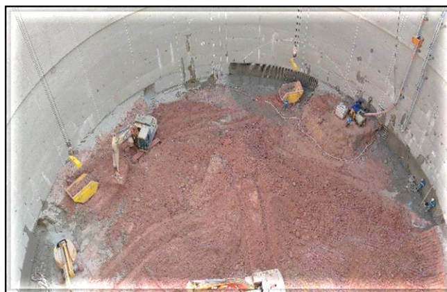
Escavação do poço do corpo da estação.
