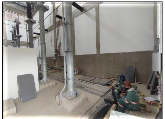
Sistemas – lançamento de cabos na sala de alta tensão.
