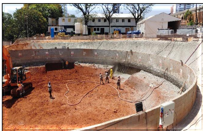
Escavação do poço do corpo da estação.
