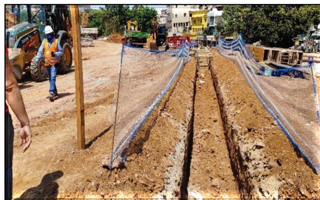
Parede guia para escavação da parede de diafragma
