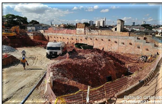
Escavação da Vala e execução de tirantes.
