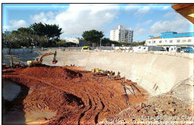
Escavação e execução de solo grampeado.
