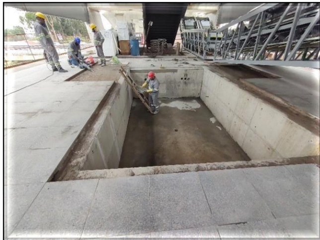
Mezanino – adequação da caixa da escada. Sistemas – escada rolante a ser posicionada.
