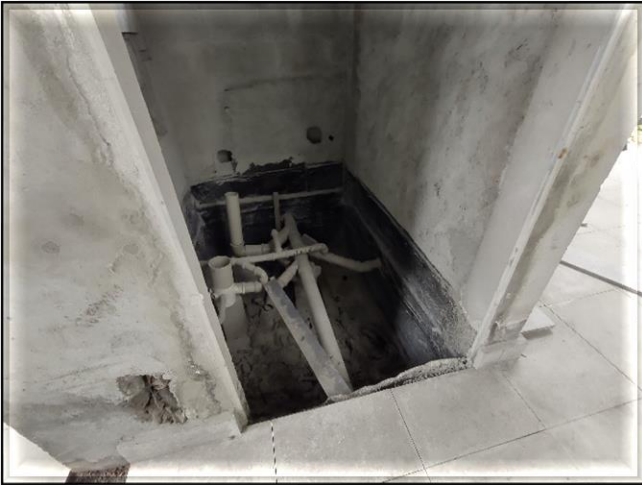
Acesso – execução da tubulação de esgoto do sanitário do bicicletário.
