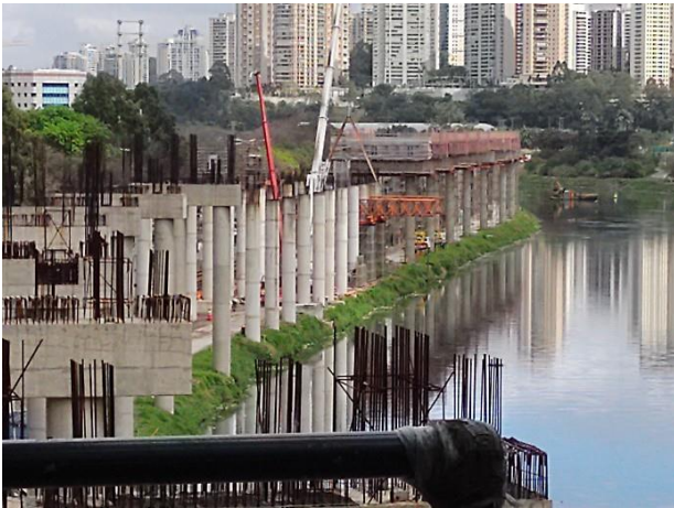
Conclusão dos apoios das vigas.
