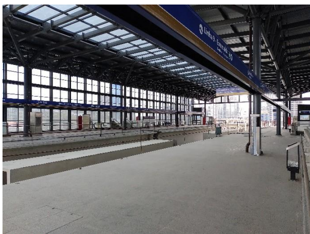
Aguardando o lançamento das vigas-guia.
