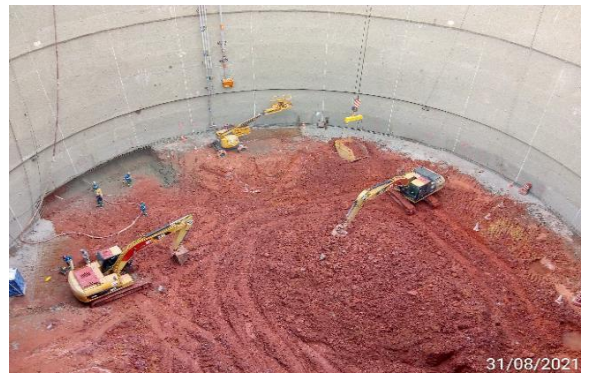
Escavação do poço.
