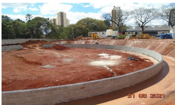
Viga de borda para escavação do poço.
