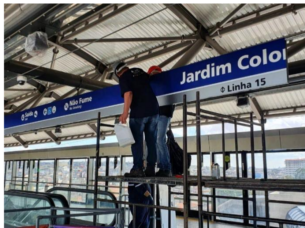
Instalação da comunicação visual e acabamento.
