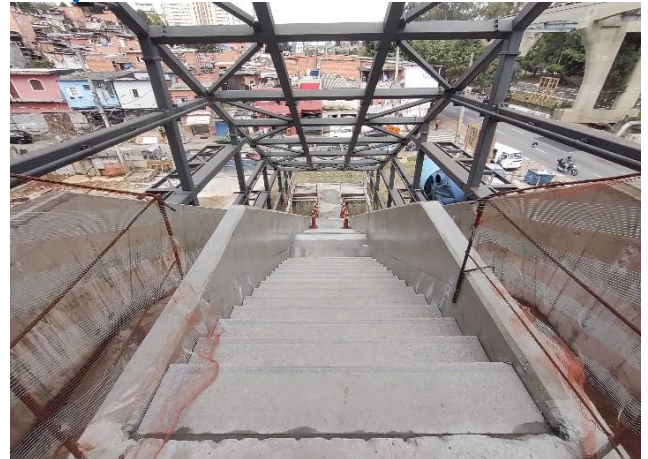
Execução do piso de granito na escada fixa.
