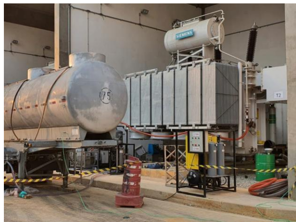
Montagem e testes dos transformadores de alta tensão.
