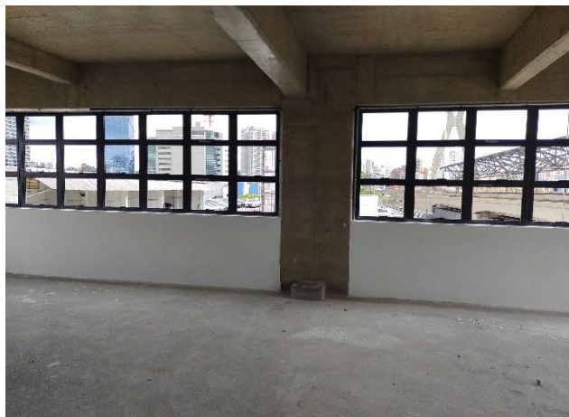
Instalação dos caixilhos.
