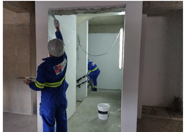
Aplicação de massa corrida nas paredes.
