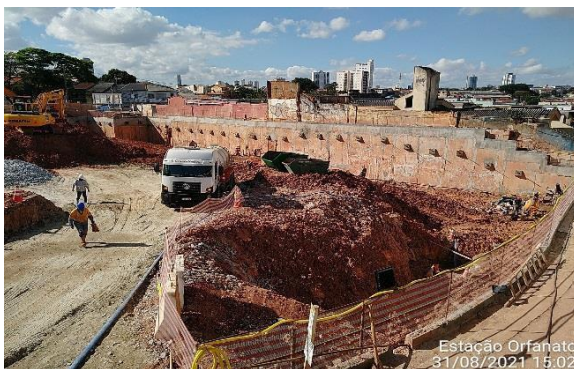
Escavação e execução de tirantes.
