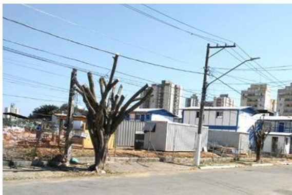
Montagem do canteiro de obras.
