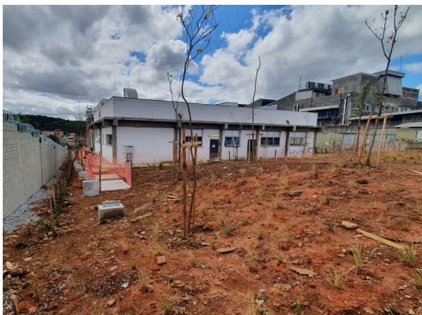
Execução do acabamento e paisagismo.
