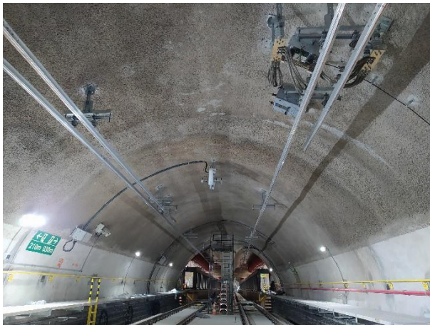
Túnel de Via 02 – ajustes na altura das cordoalhas da Rede Aérea; tomadas e aterramento dos bandejamentos instalados.
