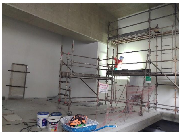
Aplicação da massa corrida nas paredes.
