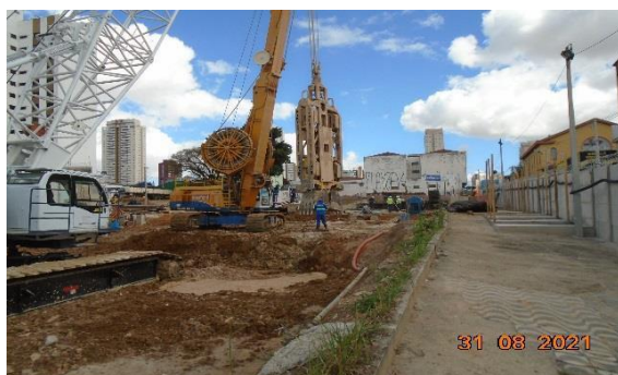
Execução da parede de diafragma.
