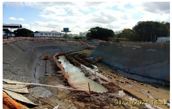
Desvio do Córrego do Rincão.
