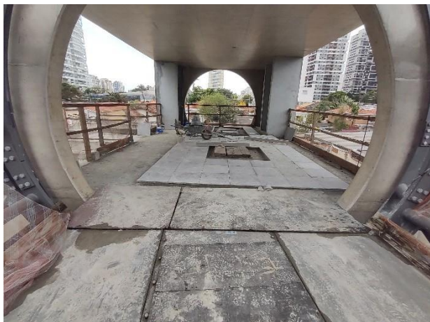
Execução do piso de granito.
