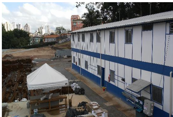
Montagem do canteiro de obras.
