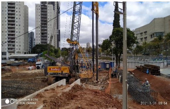
Execução da parede de diafragma.
