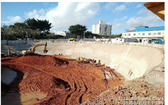
Escavação e execução de solo grampeado.
