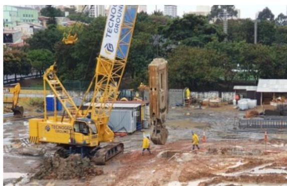
Estação Penha – execução da parede guia e parede de diafragma.
