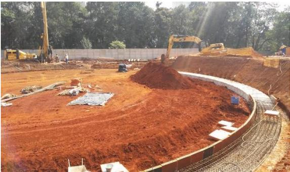
Estação Santa Isabel – viga de borda para escavação do poço do corpo da estação.
