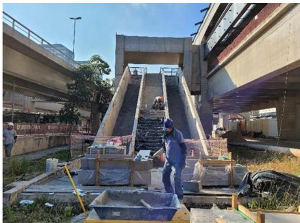
Acesso – instalação do piso de granito na escada.
