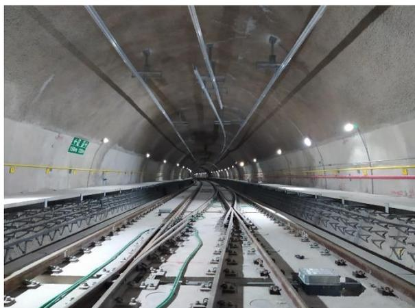
Túnel de Via 07 – ajustes na altura da Rede Aérea, instalação de tomadas e aterramento dos bandejamentos.
