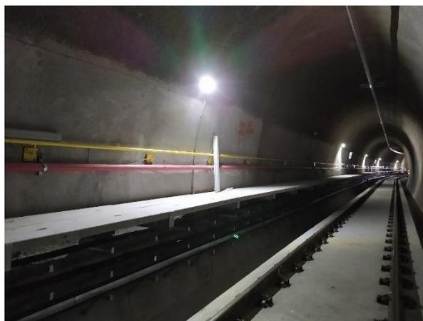
Túnel de Via 05 – ajustes na altura da Rede Aérea e aterramento dos bandejamentos.
