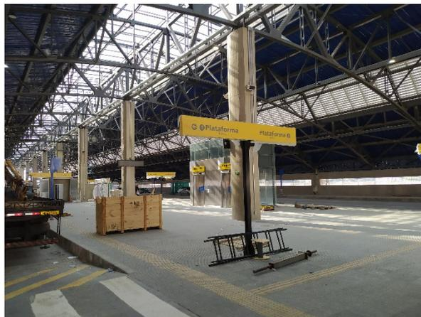
Nível Terminal – iluminação, câmeras, sonofletores e displays de LCD instalados.
