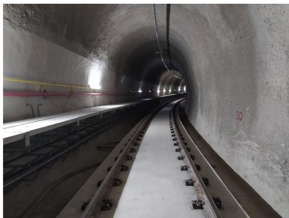
Túnel de Via 05 – barras de alumínio da Rede Aérea instaladas.
