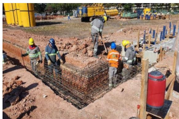
Estação Penha – execução da parede guia e parede de diafragma.
