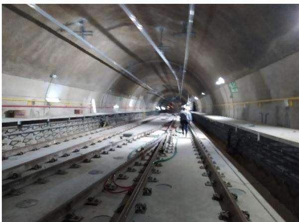
Túnel de Via 04 – migração da alimentação elétrica das luminárias para os painéis definitivos
