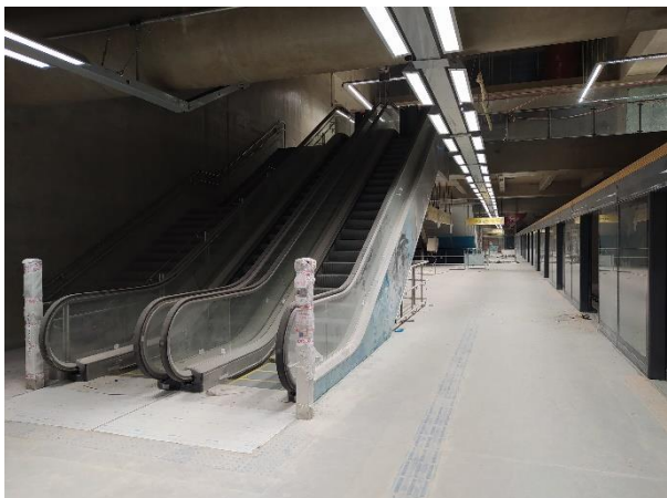
Plataformas – luminárias instaladas, escadas rolantes em fase de comissionamento, portas de plataforma comissionadas.
