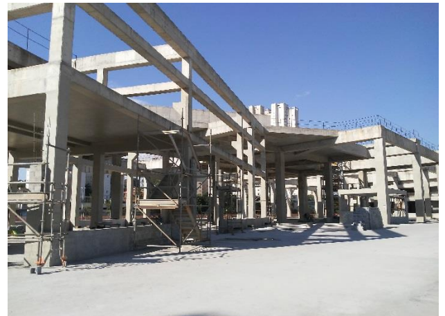
Bloco C - execução da alvenaria.
