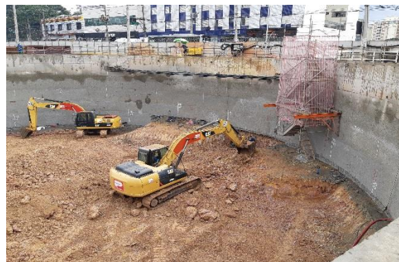
Estação Vila Formosa – escavação do poço do corpo da estação.
