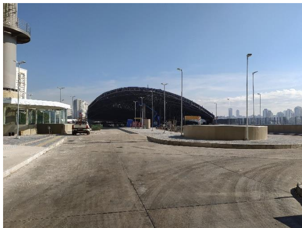
Nível Terminal – área externa do terminal, com iluminação em instalação.
