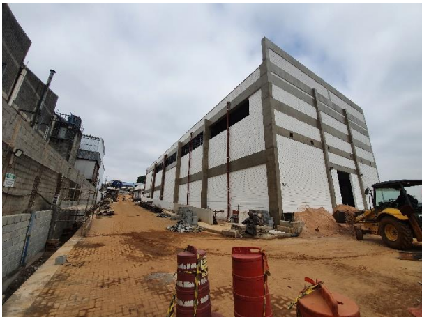
Obra Civil – em execução calçadas, muro e instalação de venezianas.
