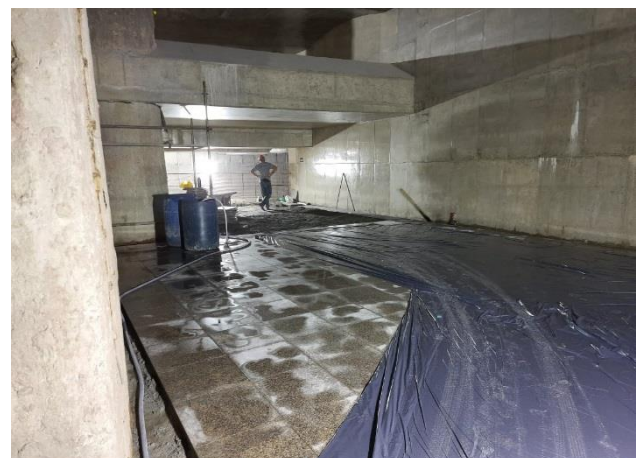
Túnel de Ligação- piso de granito.
