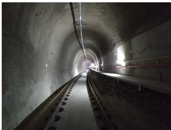
Túnel de Via 05 – barras de alumínio da Rede Aérea em instalação.
