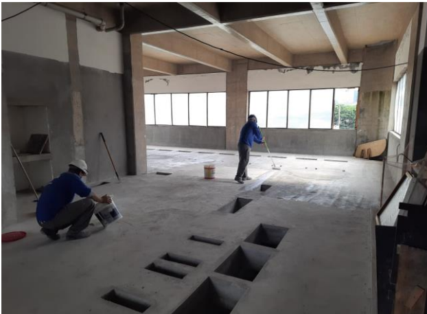
ETO - acabamento das Salas Técnicas.
