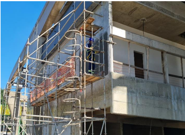
Corpo da estação - execução do reboco.
