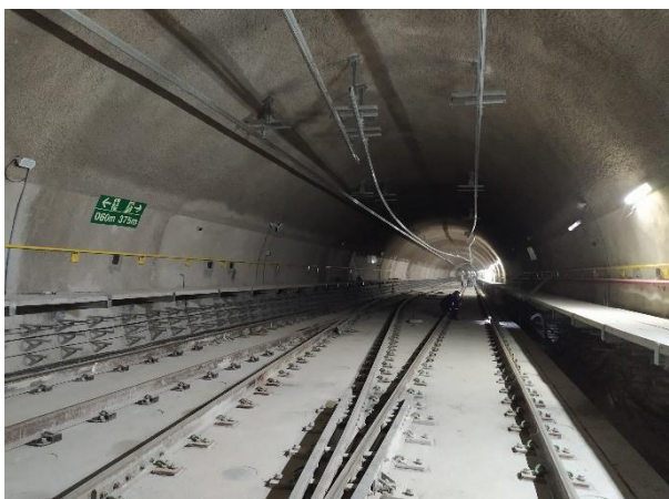
Túnel de Via 04 – instalação das barras de alumínio da Rede Aérea em nivelamento.
