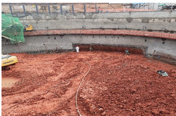
VSE Falchi Gianini – escavação do Poço.
