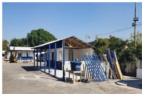
Estação Penha – instalação do canteiro de obras.
