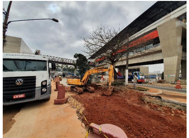
Obra Civil – execução da base da pavimentação do entorno da estação.
