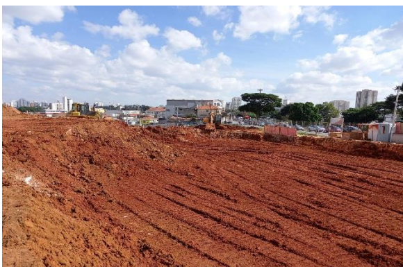
Estação Santa Clara – regularização do terreno.
