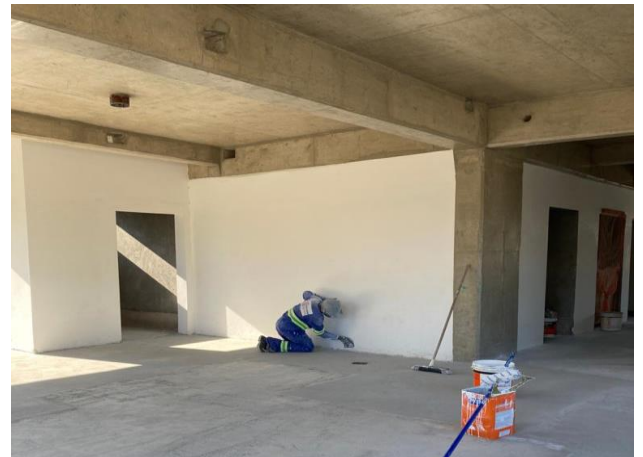
ETO- execução do acabamento.
