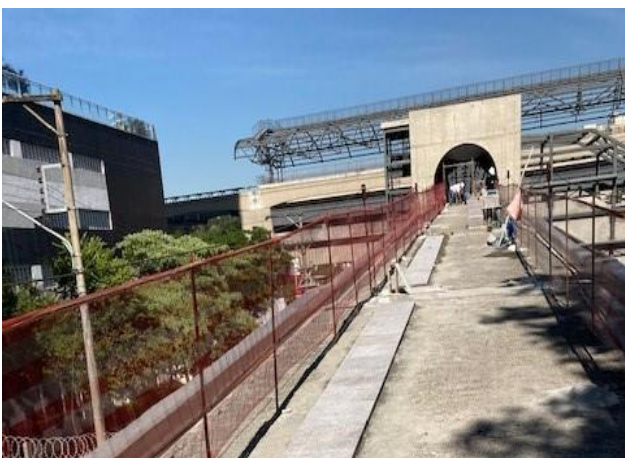
Acesso – piso de granito na rampa.
