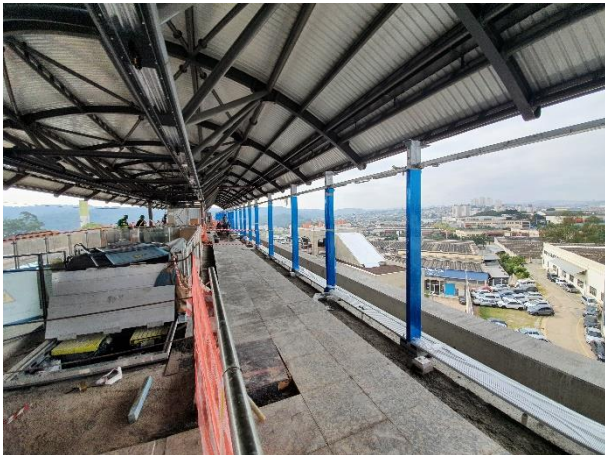
Obra Civil – instalação do piso de granito; Sistemas – montagem das Portas de Plataforma.
