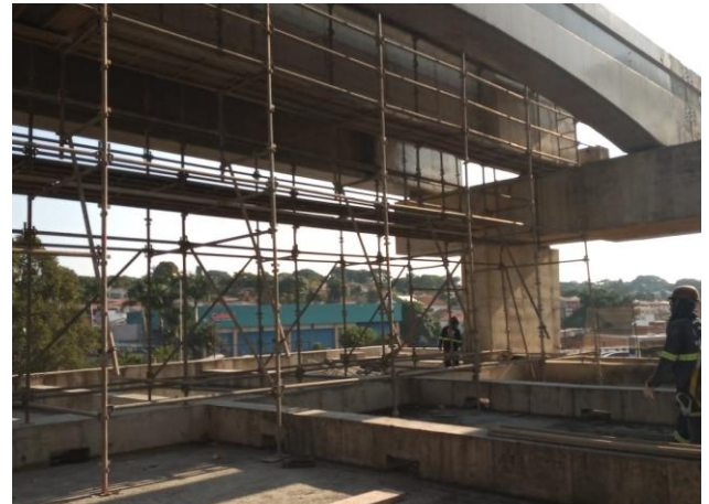
Corpo da Estação - montagem do cimbramento.
