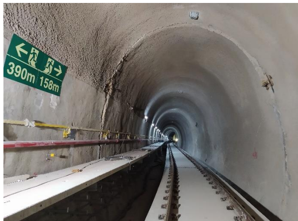
Túnel de Via 05 – bandejamento e comunicação visual em execução.
