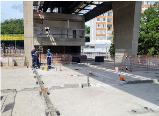
Corpo da estação - execução da Obra Civil.
