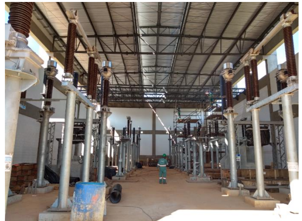
Sistemas – Montagem de Equipamentos de alta tensão na Sala de Elétrica.
