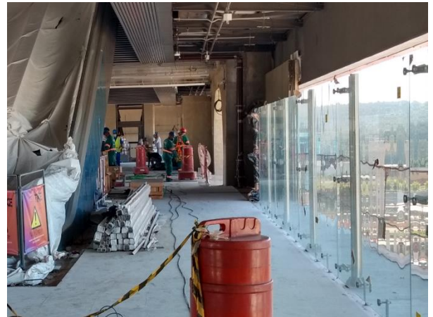
Obra Civil – instalação dos vidros do guarda corpo e forro; Sistemas – montagem da infraestrutura.
