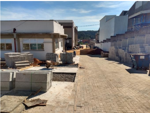
Obra Civil – em execução calçadas, guias e piso intertravado.
