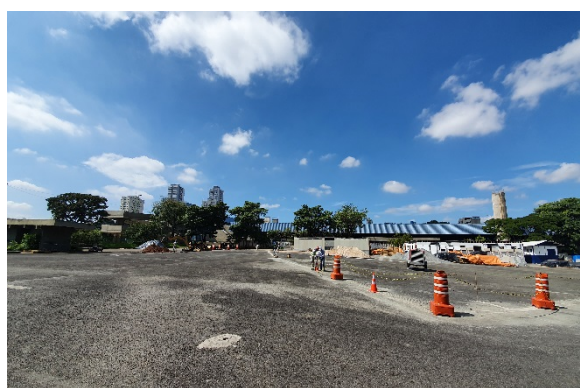
Estação Penha – instalação do canteiro de obras
