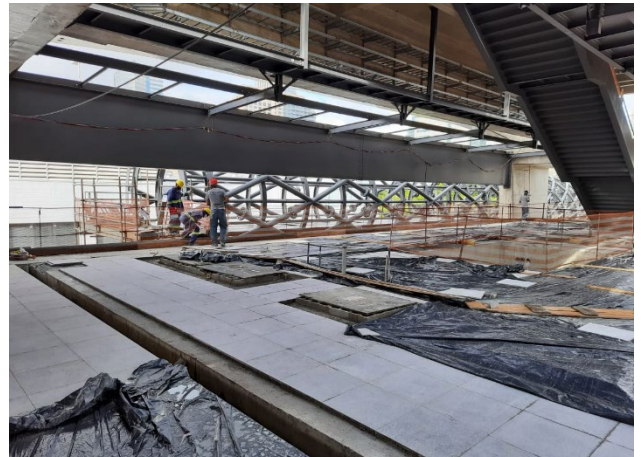
Corpo da estação - piso de granito no mezanino.
