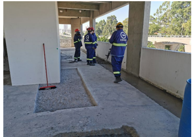
Edifício Técnico Operacional - execução da Obra Civil.
