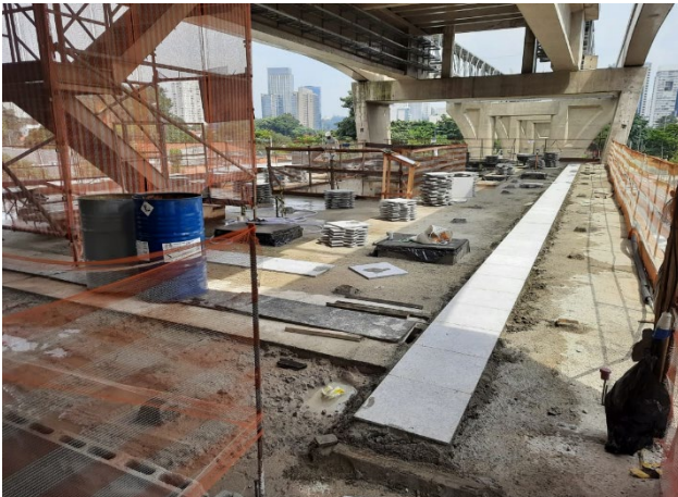
Corpo da estação - piso de granito no mezanino.
