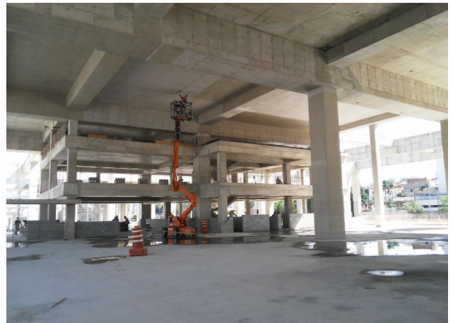
Bloco E - tratamento do concreto.
