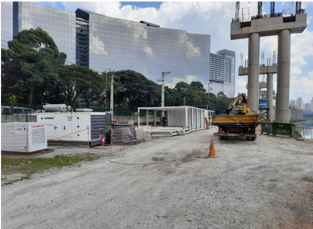
Vias do monotrilho - obra bruta.
