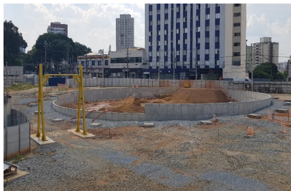
Estação Vila Formosa – parede guia para escavação do poço do corpo da estação.
