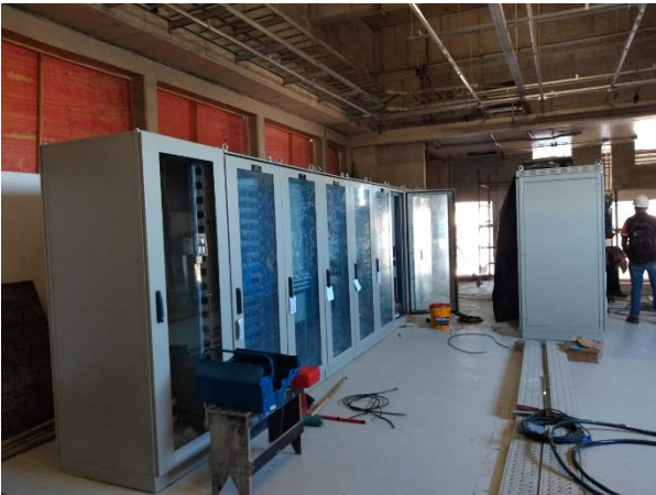
Sistemas – montagem de equipamentos e painéis na Sala de Equipamentos Eletrônicos.
