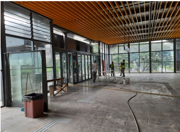
Corpo da estação - vista geral.
