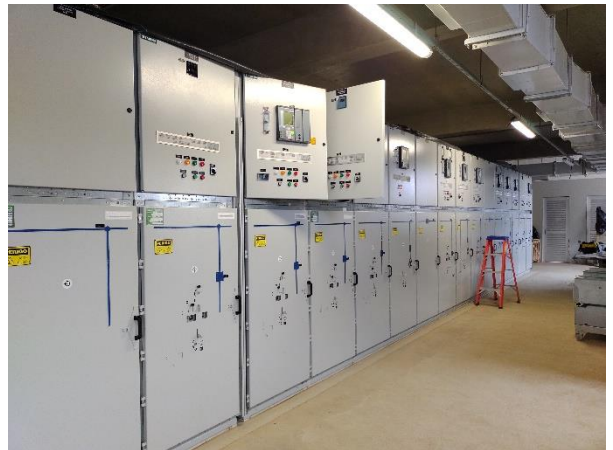
Sistemas – montagem e testes dos cubículos de média tensão.
