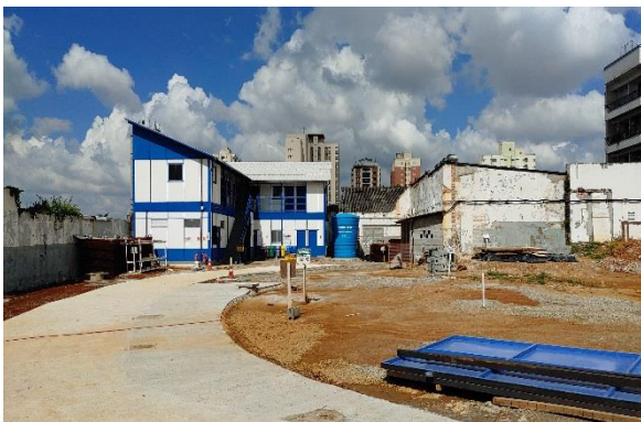
VSE Falchi Gianini – instalação do canteiro de obras.
