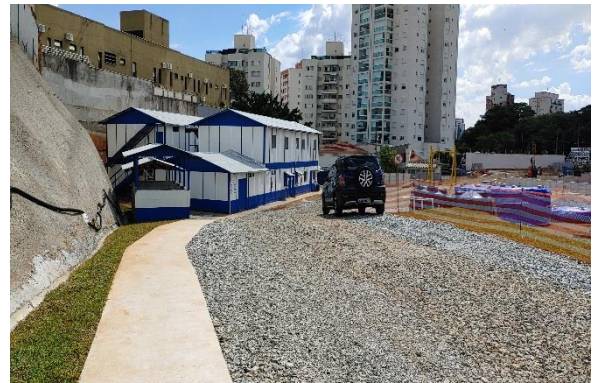
Estação Vila Formosa – instalação do canteiro de obras.
