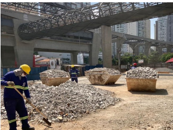
Corpo da estação - obra bruta.
