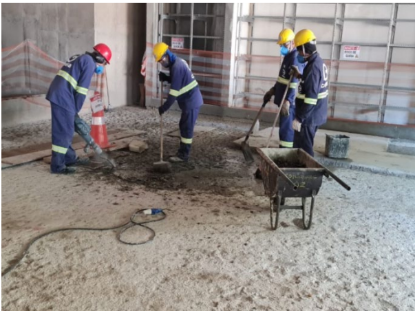
Corpo da estação - obra bruta.
