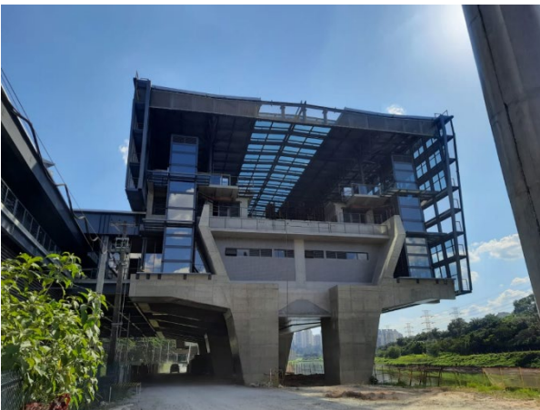
Corpo da estação – Vista geral.
