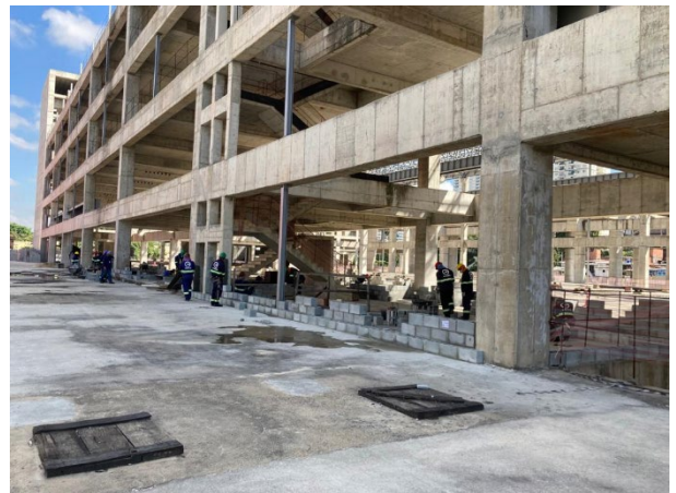
Setor 5 - Estrutura de concreto - obra bruta.
