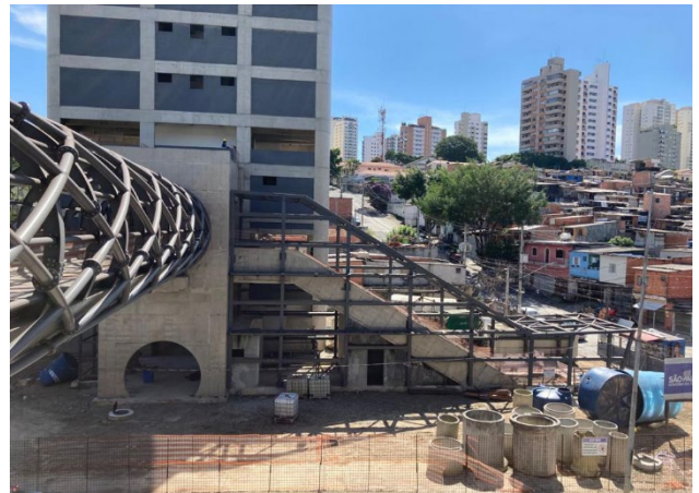
Corpo da estação - obra bruta.
