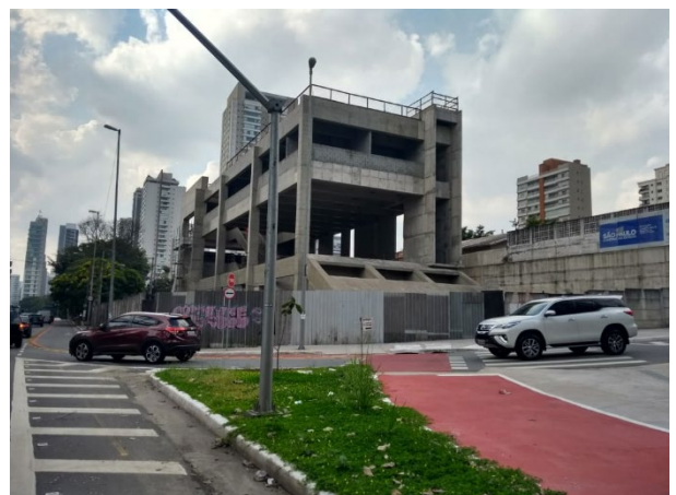
Corpo da estação - obra bruta.
