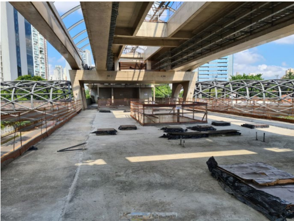
Corpo da estação - obra bruta.
