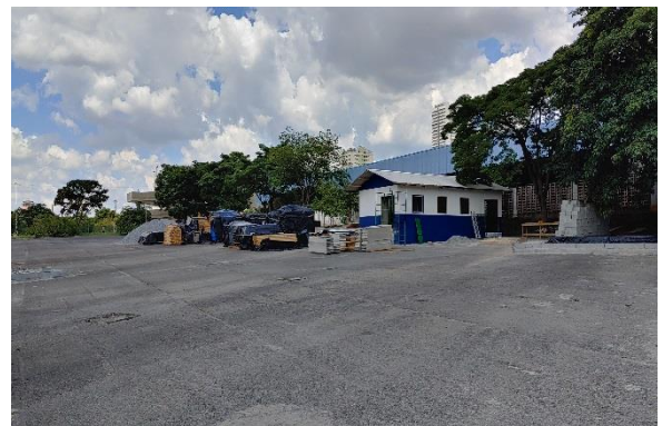
Estação Penha – instalação do canteiro de obras.
