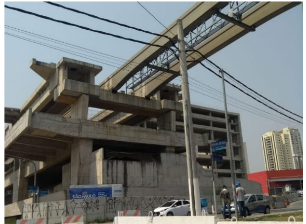
Corpo da estação - obra bruta.
