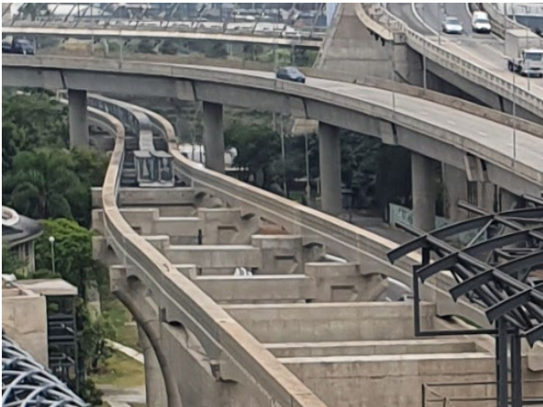
Vias do monotrilho - obra bruta.
