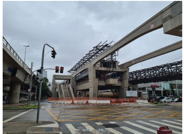
Corpo da estação - obra bruta.
