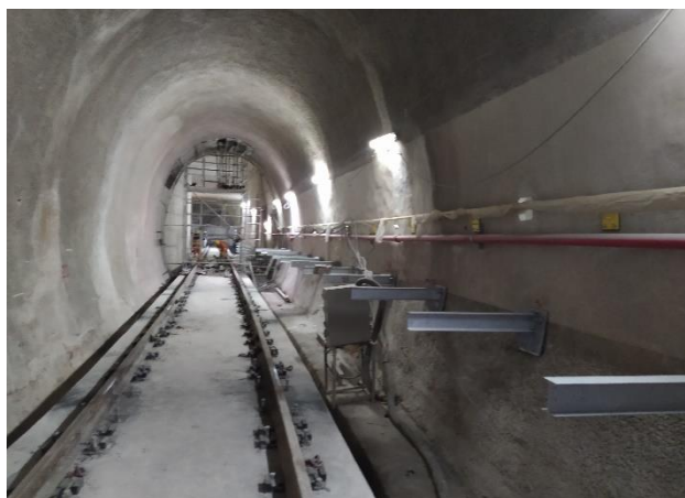
Túnel de Via 05 – passarela de emergência em execução.
