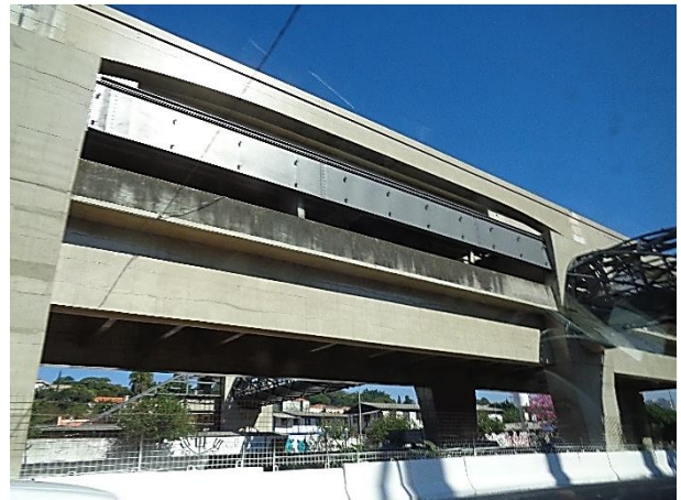
Corpo da estação - obra bruta.
