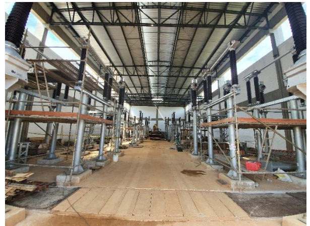
Sistemas – instalação de equipamentos de alta tensão.
