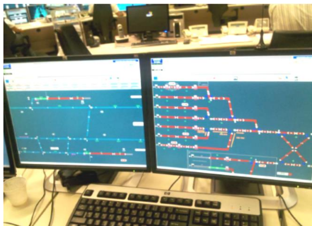
Painel de controle de tráfego
