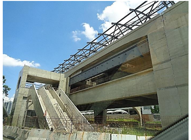
Corpo da estação - obra bruta.
