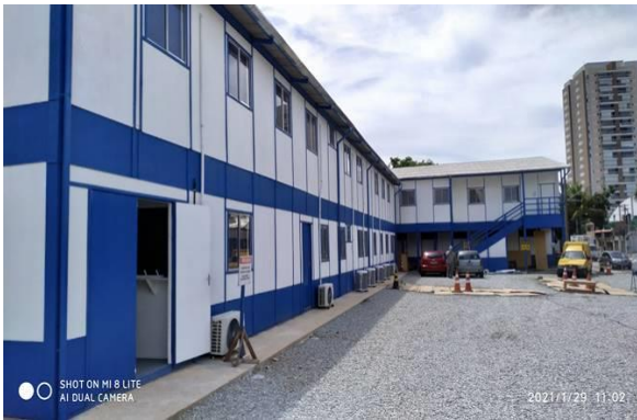
Estação Anália Franco – instalação do canteiro de obras.
