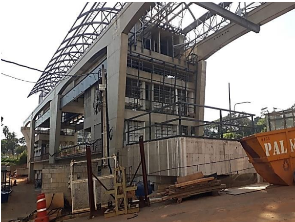
Corpo da estação - obra bruta.
