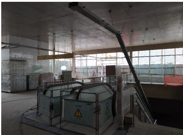
Acesso Taborda - instalação dos vidros.
