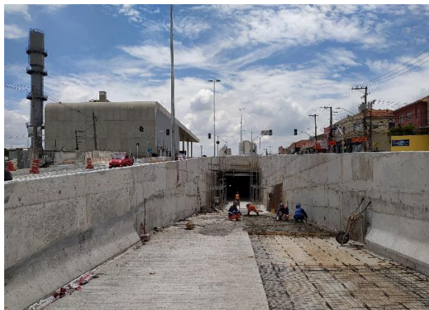
Acesso ao Terminal de Ônibus ("Mergulhão") – execução do pavimento rígido.
