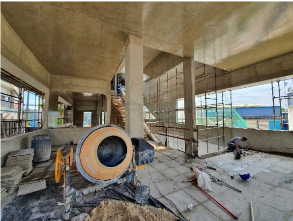
Obra Civil – assentamento do granito no Acesso Sul.
