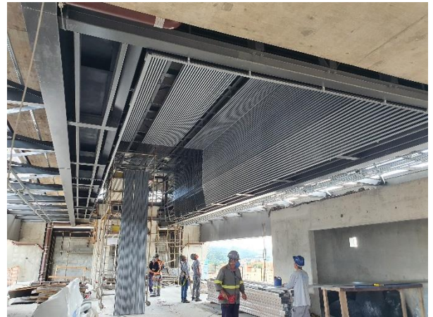
Obra Civil – instalação do forro no passadiço. Sistemas – montagem de infraestrutura de telecomunicações.
