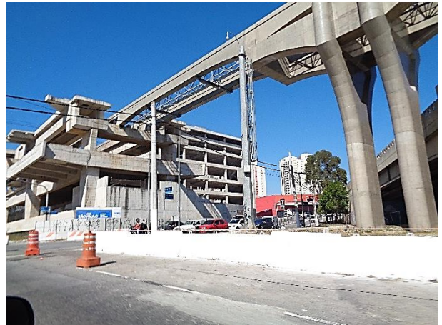
Corpo da estação - obra bruta.
