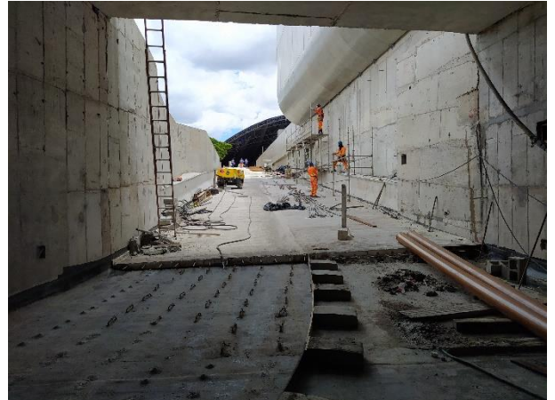
Acesso ao Terminal de Ônibus (“Mergulhão”) – formas e armação para a concretagem do pavimento (adequação do viário).
