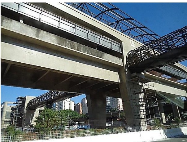
Corpo da estação - obra bruta.
