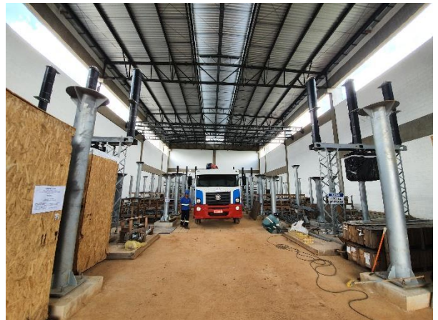
Sistemas – instalação de equipamentos de alta tensão.
