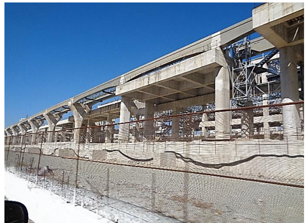
Setor 5 - Estrutura de concreto - obra bruta.
