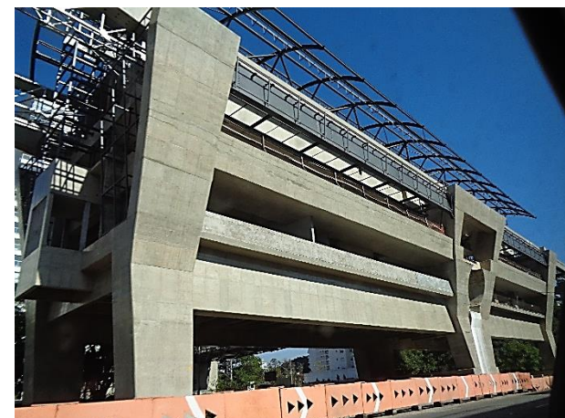
Corpo da estação - obra bruta.
