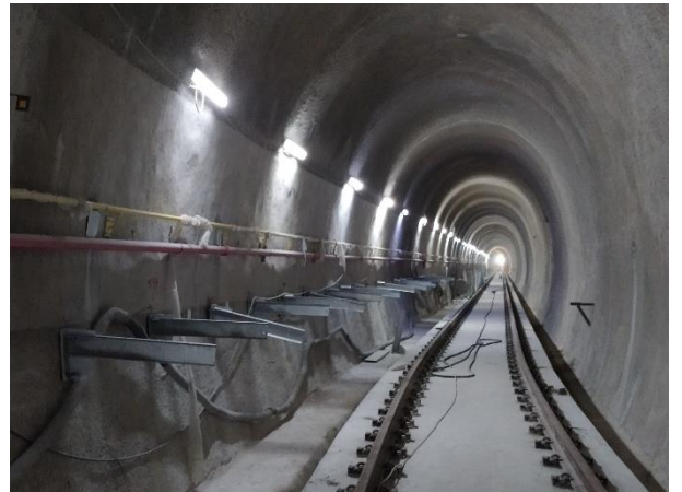
Túnel de Via 05 – trilhos instalados e suportes das passarelas de emergência em execução.
