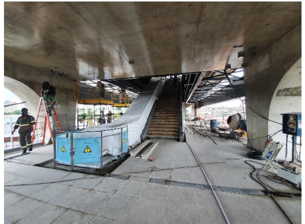
Obra Civil – execução de alvenarias e acabamento. Sistemas – escadas rolantes posicionadas; montagem de infraestrutura de telecomunicações.
