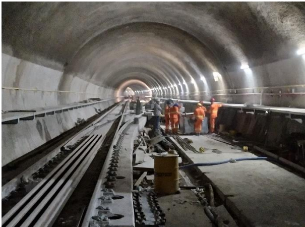
Túnel de Via 04 – passarelas de emergência e lajes flutuantes das Vias Permanentes em execução
