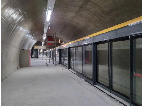
Plataformas – vidros e header-boxes das Portas de Plataforma instalados.
