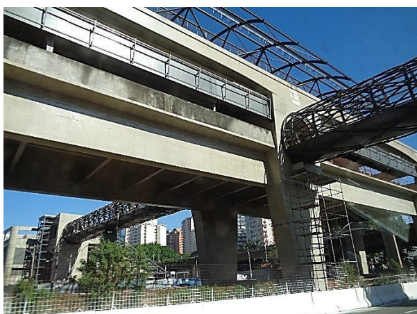
Corpo da Estação - obra bruta.
