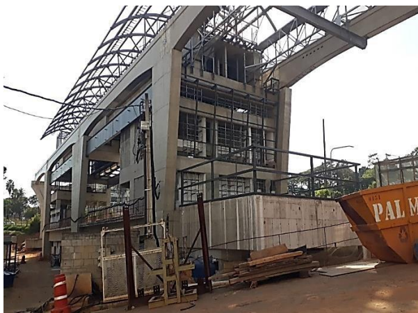
Corpo da Estação - obra bruta.
