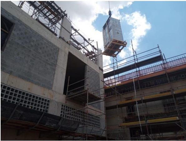
Obra Civil – entrega dos cubículos no ETO.
