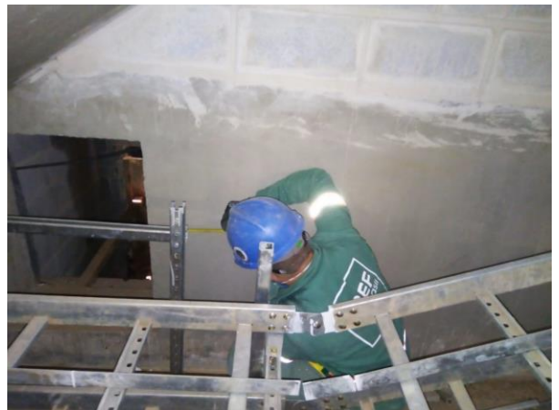
Sistemas – instalação do bandejamento.
