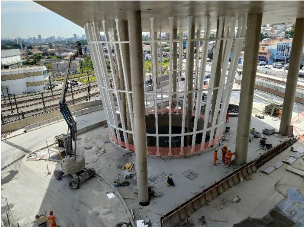
Acesso Heitor dos Prazeres – execução da estrutura metálica do cone de vidro.
