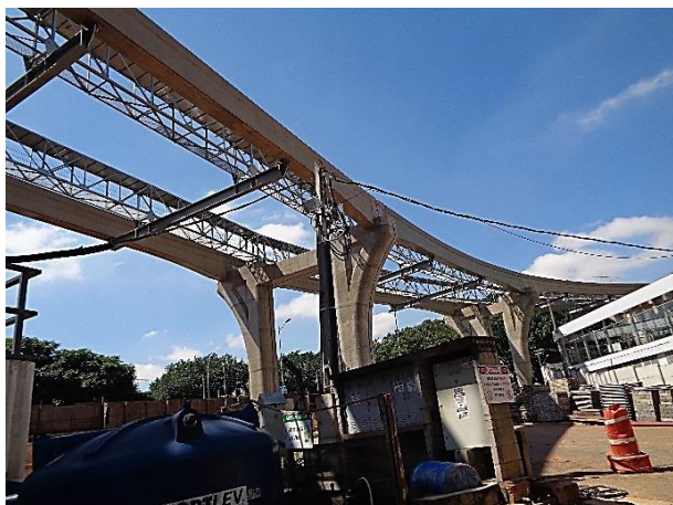
Vias do monotrilho - obra bruta.
