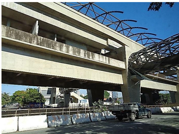
Corpo da estação - obra bruta.
