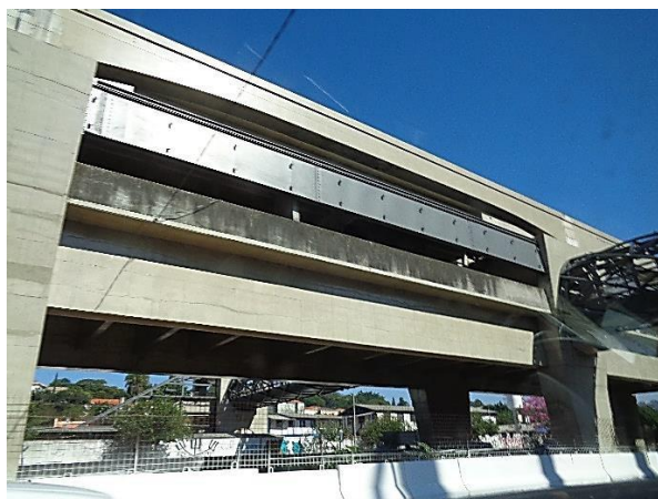
Corpo da Estação - obra bruta.
