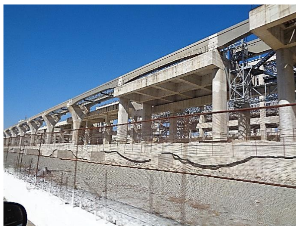
Setor 5 - Estrutura de concreto - obra bruta.
