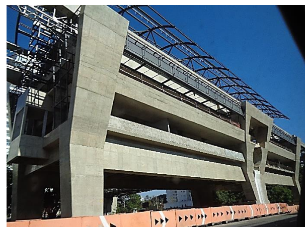
Corpo da Estação - obra bruta.
