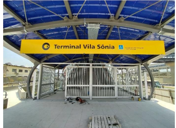
Acesso Eliseu de Almeida – instalação da comunicação visual e acabamentos em execução.
