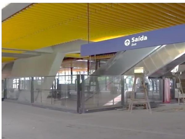
Corpo da estação - comunicação visual.
