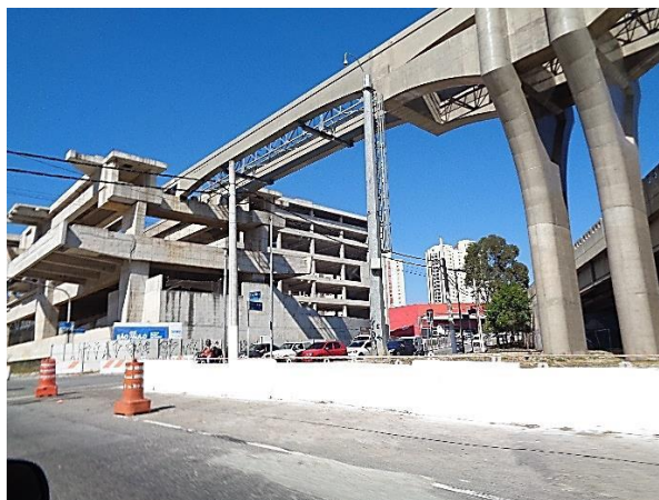
Corpo da Estação - obra bruta.
