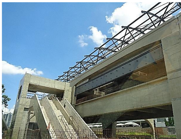
Corpo da Estação - obra bruta.
