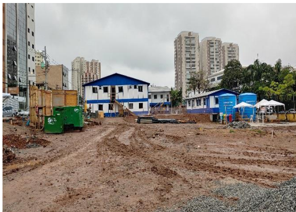
Estação Anália Franco – Instalação do canteiro de obras.
