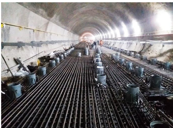
Túnel de Via 04 – lajes flutuantes e amortecimento em execução.
