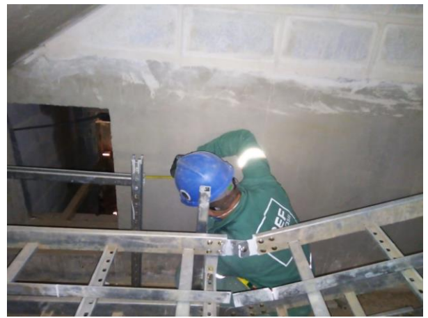
Sistemas – instalação do bandeamento.
