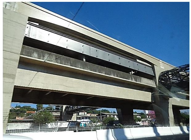
Corpo da Estação - obra bruta.
