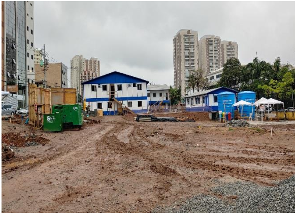
Estação Anália Franco – Instalação do canteiro de obras.
