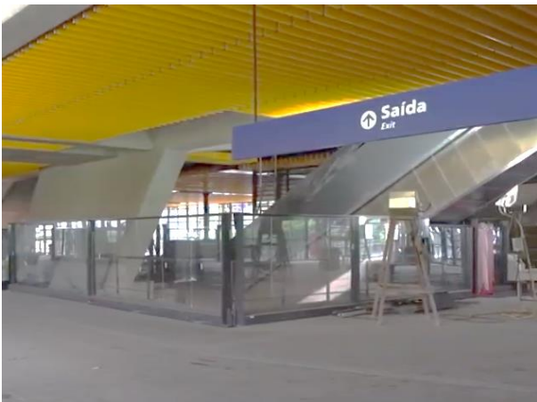
Corpo da estação - comunicação visual.
