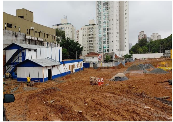
Estação Vila Formosa – Instalação do canteiro de obras.
