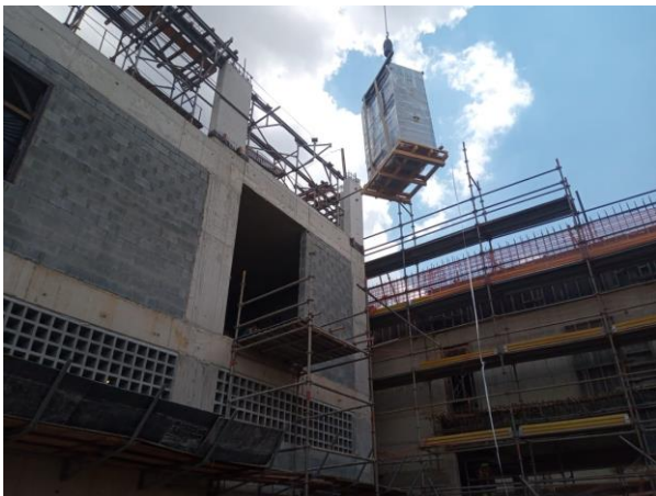
Obra Civil – entrega dos cubículos no ETO.
