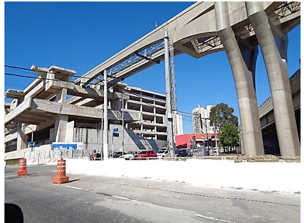
Corpo da Estação - obra bruta.
