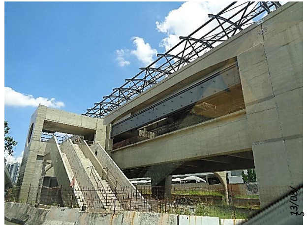
Corpo da Estação - obra bruta.
