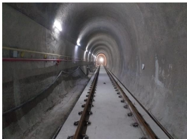
Túnel de Via 05 – laje flutuante e instalação de trilhos em execução. Trecho parcialmente concluído.
