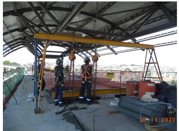
Obra Civil – instalação das telhas da cobertura da plataforma. Sistemas – posicionamento das escadas rolantes.
